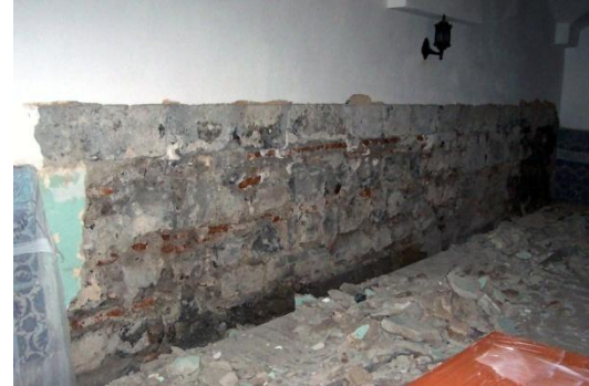
Fotoğraf-86: Geri dönüşümsüz çimento katkıli harçla sıvanmış alanların temizliği (Doğu Cephesi) (Melik Ahmet Paşa Camii, Diyarbakır).
