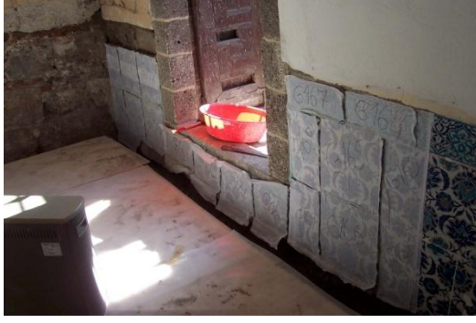
Fotoğraf-95: Güney Cephesi söküm öncesi çinilerin koruma altına alınması (Melik Ahmet Paşa Camii, Diyarbakır).
