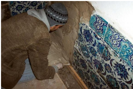
Fotoğraf-109: Onarılan çinilerin monte aşaması (Batı Cephesi) (Melik Ahmet Paşa Camii, Diyarbakır).
