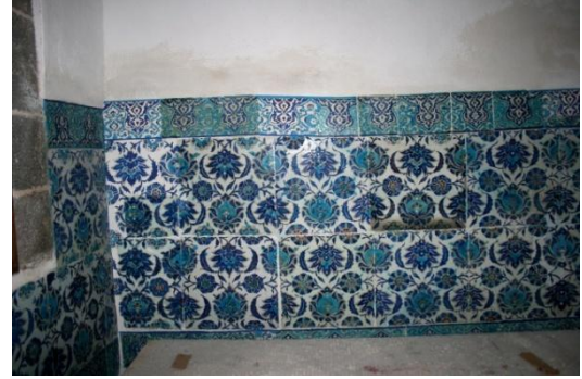
Fotoğraf-136: Batı Cephesi çinileri restorasyon sonrası, detay (Melik Ahmet Paşa Camii, Diyarbakır).
