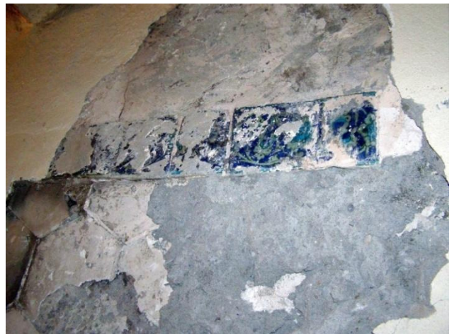
Fotoğraf-84: Mahfil merdiven boşluğu, sıva altından çıkarılan çini ve çini izleri (Melik Ahmet Paşa Camii, Diyarbakır).
