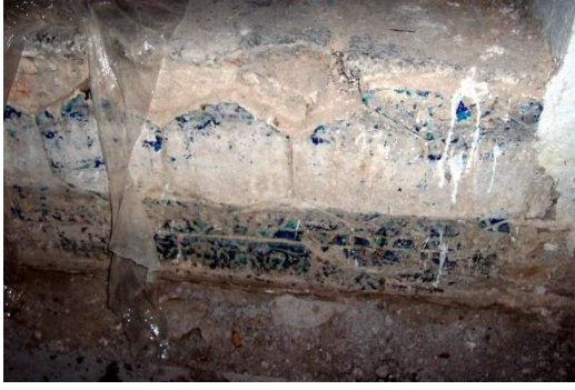
Fotoğraf-129: Mahfil merdiven eşiği çinileri restorasyon öncesi, detay (Melik Ahmet Paşa Camii, Diyarbakır).
