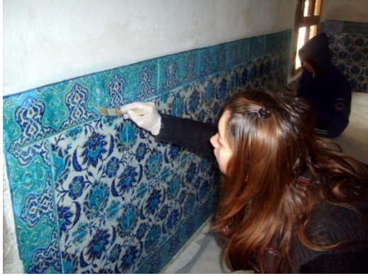
Fotoğraf-123: Onarılan alanlara koruyucu uygulanması (Melik Ahmet Paşa Camii, Diyarbakır).
