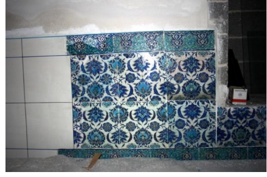
Fotoğraf-134: Batı Cephesi çinileri restorasyon sonrası, detay (Melik Ahmet Paşa Camii, Diyarbakır).
