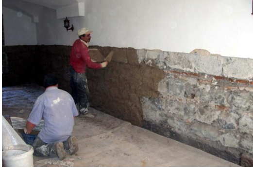
Fotoğraf-101: Doğu Cephesi, çinilerin monte edileceği alanın geri dönüşümlü kaba sıva ile sıvanması (Melik Ahmet Paşa Camii, Diyarbakır).
