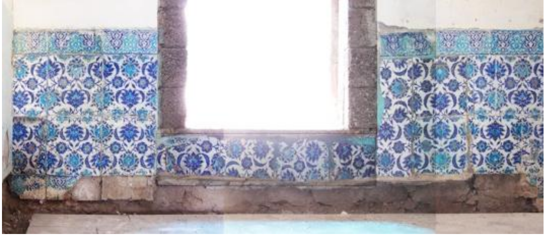
Fotoğraf-60: Güney Cephesi mihrap sağı ikinci pencere bölgesindeki müdahale detay çizimi yapılan çinili alan (Melik Ahmet Paşa Camii, Diyarbakır).
