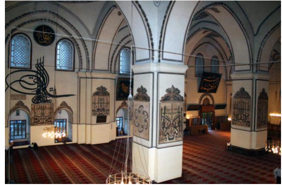
Fotoğraf-34: Bursa Ulu Camii sıva üstü kalem işleri restorasyon öncesi görünümü. (Fotoğraf: M. Semih İrteş).
