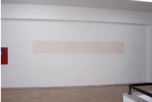
Fotoğraf-149: Duvar yüzeyinin ve desen yapılacak alanların zemin renklerinin boyanmış görünümü.
