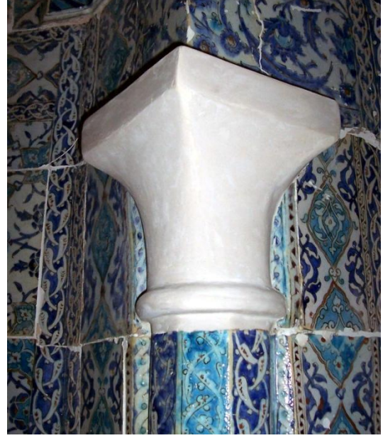
Fotoğraf-94: Alçı kalıp alınarak dökümü yapılan mihrap sütun başlığı (Melik Ahmet Paşa Camii, Diyarbakır).
