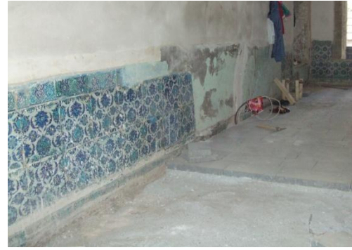
Fotoğraf-52: Batı Cephesi çinileri, Restorasyon öncesi (Melik Ahmet Paşa Camii, Diyarbakır).
