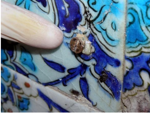
Fotoğraf-81: Çinilere monte edilmiş vida ve dübel gibi zararlı maddeler (Melik Ahmet Paşa Camii, Diyarbakır).
