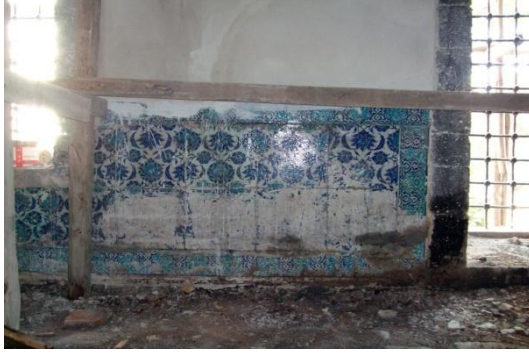
Fotoğraf-49: Kuzey Cephesi çinileri orta bölüm, Restorasyon öncesi (detay) (Melik Ahmet Paşa Camii, Diyarbakır).
