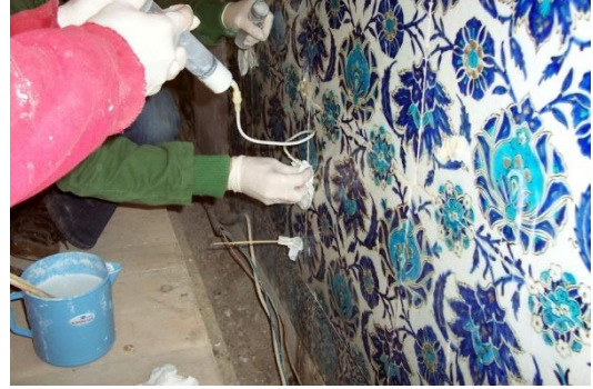
Fotoğraf-88: Güney Cephesi çinileri Sağlama çalışması (Melik Ahmet Paşa Camii, Diyarbakır).
