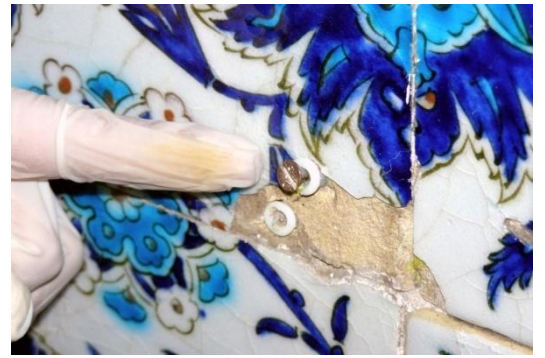
Fotoğraf-54: Çinilerin üzerine monte edilmiş zararlı unsurlar (vida, dübel) (Melik Ahmet Paşa Camii, Diyarbakır).
