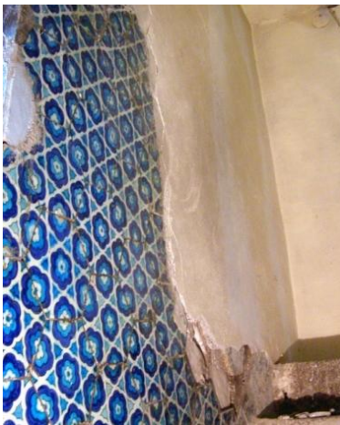
Fotoğraf-83: Mahfil merdiven boşluğu, altında çini olabileceği düşünülen sıvalı alan (Melik Ahmet Paşa Camii, Diyarbakır).
