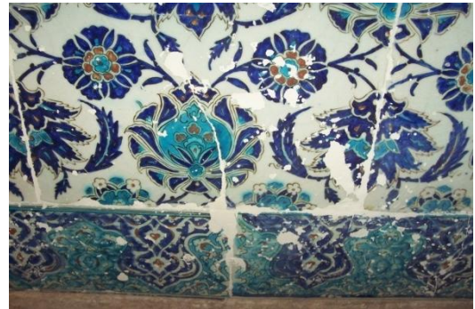
Fotoğraf-92: Güney Cephesi çinileri, çatlak ve kırıkların onarım sonrası (Melik Ahmet Paşa Camii, Diyarbakır).
