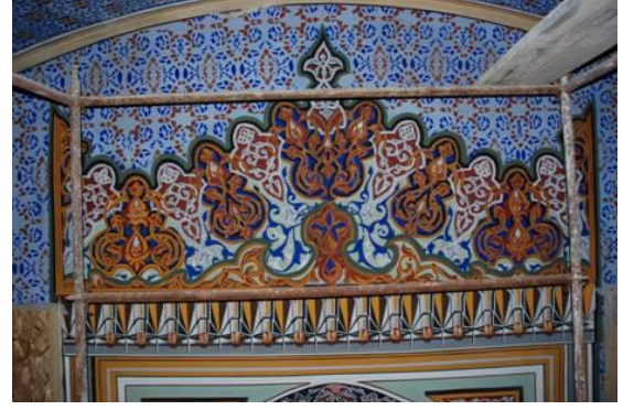
Fotoğraf-43: İstanbul Pertevniyal Valide Sultan Camii kuzeybatı beden duvarı, sıva üstü kalem işleri, restorasyon öncesi. (Fotoğraf; Art Restorasyon Kültür Sanat ve Araştırmacılık Tic. Ltd. Şti.).
