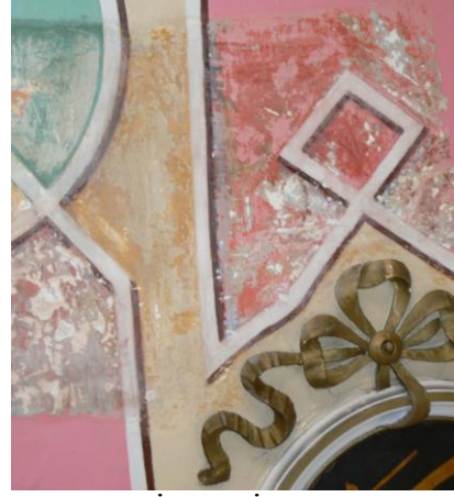
Fotoğraf-26: İzmir İkiçeşmelik Camii kubbesi sıva üstü kalem işleri raspa çalışması (detay).
