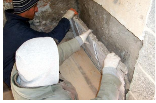
Fotoğraf-96: Güney Cephesi çinileri söküm aşaması (Melik Ahmet Paşa Camii, Diyarbakır).
