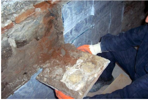
Fotoğraf-97: Doğu Cephesi çinileri söküm aşaması (Melik Ahmet Paşa Camii, Diyarbakır).
