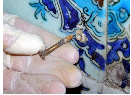
Fotoğraf-82: Çinilere monte edilmiş vida ve dübel gibi zararlı maddelerin temizliği (Melik Ahmet Paşa Camii, Diyarbakır).
