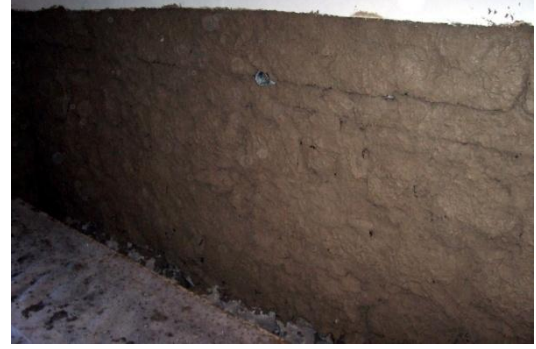
Fotoğraf-102: Doğu Cephesi çinilerin monte edileceği alanın geri dönüşümlü kaba sıva ile sıvanmış hali (Melik Ahmet Paşa Camii, Diyarbakır).
