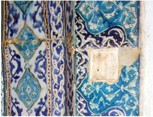
Fotoğraf-89: Temizliği yapılmış hasarlı kısım (Mihrap çinileri bordür alanı) (Melik Ahmet Paşa Camii, Diyarbakır).
