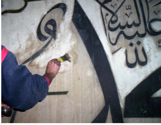
Fotoğraf-35: Sıva üstü hat yazıları kimyasal temizlik (Ulu Camii, Bursa). (Fotoğraf: M.Semih İrteş).
