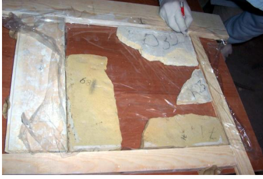
Fotoğraf-107: Hasarlı parçaların tütleme çalışması (Melik Ahmet Paşa Camii, Diyarbakır).
