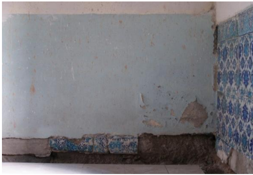
Fotoğraf-125: Güneydoğu Cephesi çinileri restorasyon öncesi, detay (Melik Ahmet Paşa Camii, Diyarbakır).
