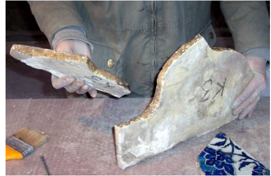
Fotoğraf-104: Hasarlı çinilerin uyumlu parçalarının bulunarak onarımı (Melik Ahmet Paşa Camii, Diyarbakır).
