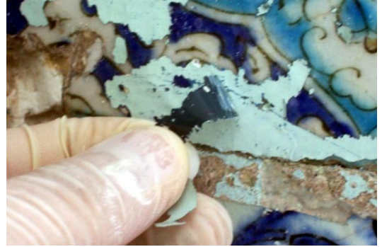
Fotoğraf-74: Çini yüzeylerdeki yağlıboya kalıntılarının temizliği (Melik Ahmet Paşa Camii, Diyarbakır).
