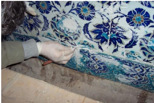
Fotoğraf-91: Güney Cephesi çinileri, çatlak ve kırıkların onarım aşaması (Melik Ahmet Paşa Camii, Diyarbakır).
