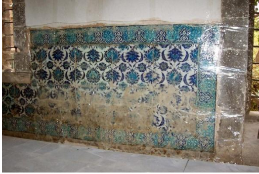
Fotoğraf-69: Kuzey Cephesi çinileri kimyasal temizlik aşaması (Melik Ahmet Paşa Camii, Diyarbakır).
