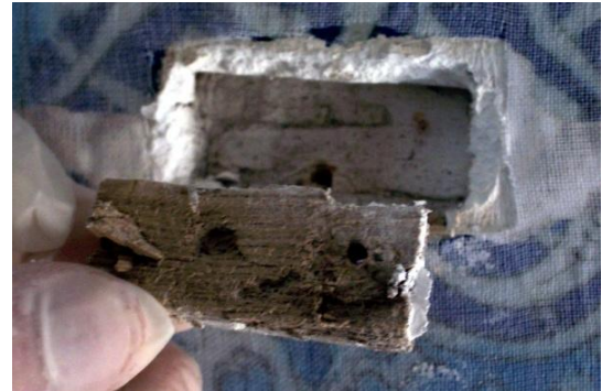
Fotoğraf-80: Çinilere monte edilmiş ahşap ve demir parçaların temizliği (Melik Ahmet Paşa Camii, Diyarbakır).
