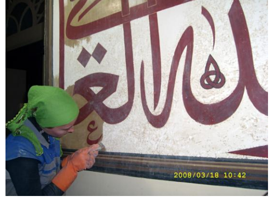
Fotoğraf-36: Sıva üstü hat yazıları mekanik temizlik (Ulu Camii, Bursa). (Fotoğraf: M.Semih İrteş).
