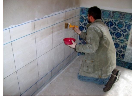
Fotoğraf-124: Onarılan alanlara koruyucu uygulanması (Melik Ahmet Paşa Camii, Diyarbakır).
