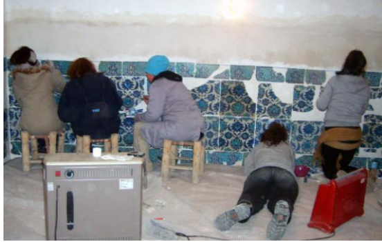
Fotoğraf-114: D.E.Ü. G.S.F. Geleneksel Türk Sanatları Bölümü Öğrencileri tarafından çinilerin eksik kısımlarının kalem işi tekniğinde renklendirilmesi (Doğu Cephesi) (Melik Ahmet Paşa Camii, Diyarbakır).
