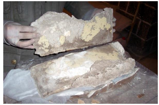
Fotoğraf-100: Sökülen çinilerin arka kısımlarındaki geri dönüşümsüz çimento katkı harç kalıntılarının temizliği (Melik Ahmet Paşa Camii, Diyarbakır).
