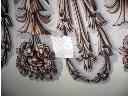
Fotoğraf-33: Bursa Ulu Camii kubbe kalem işlerinde gerçekleştirilen araştırma raspası örneği. (Fotoğraf: M. Semih İrteş).
