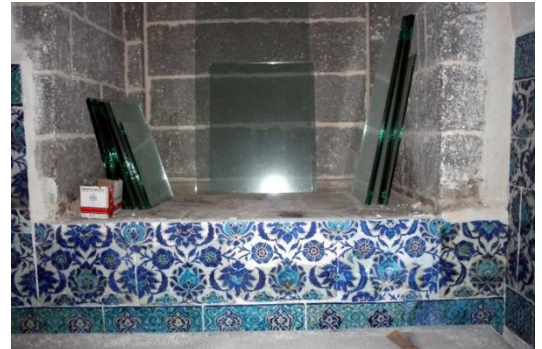
Fotoğraf-132: Batı Cephesi niş eşiği çinileri restorasyon sonrası, detay (Melik Ahmet Paşa Camii, Diyarbakır).
