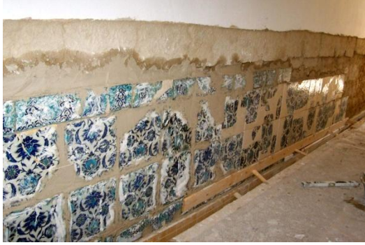
Fotoğraf-113: Onarılan çinilerin monte aşaması (Doğu Cephesi) (Melik Ahmet Paşa Camii, Diyarbakır).
