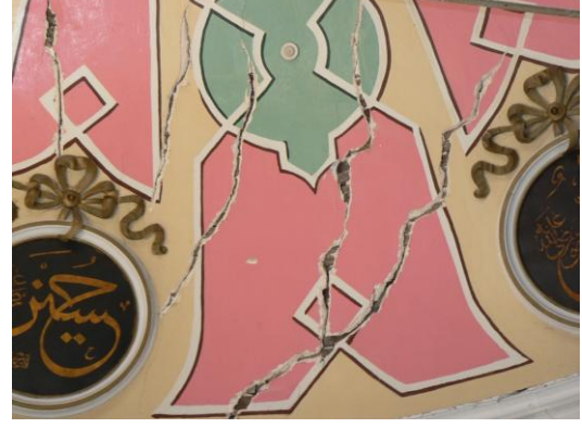
Fotoğraf-24: İzmir İkiçeşmelik Camii kubbesi sıva üstü kalem işleri restorasyon öncesi durumu (Detay).
