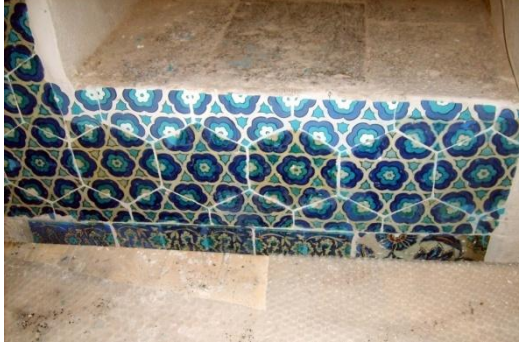
Fotoğraf-119: Mahfil merdiven eşiği çinileri onarım ve renklendirme sonrası görünümü (Melik Ahmet Paşa Camii, Diyarbakır).
