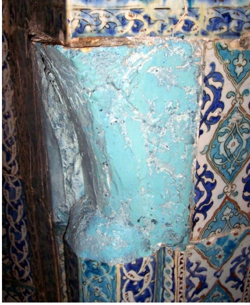
Fotoğraf-77: Tahrip edilmiş mihrap sütun başlığı alanındaki çimento katkılı harç ve yağlıboya kalıntıları (Melik Ahmet Paşa Camii, Diyarbakır).
