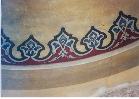
Fotoğraf-13: İstanbul-Kadınca, Sokollu Mehmed Paşa Camii, son cemaat revakı kubbe eteği sıva üstü kalem işleri (restorasyon öncesi).
