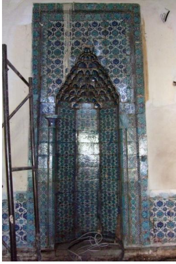
Fotoğraf-139: Mihrap restorasyon öncesi (Melik Ahmet Paşa Camii, Diyarbakır).
