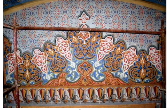
Fotoğraf-45: İstanbul Pertevniyal Valide Sultan Camii kuzeybatı beden duvarı, sıva üstü kalem işleri bazı ufak müdahaleler ve koruyucu uygulanması dışında restorasyonu büyük ölçüde tamamlanmış görünümü. (Fotoğraf; Art Restorasyon Kültür Sanat ve Araştırmacılık Tic. Ltd. Şti.).
