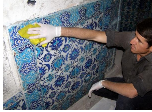
Fotoğraf-64: Çini yüzeylerin özel nemli bezler ile silindiği genel temizlik (Melik Ahmet Paşa Camii, Diyarbakır).
