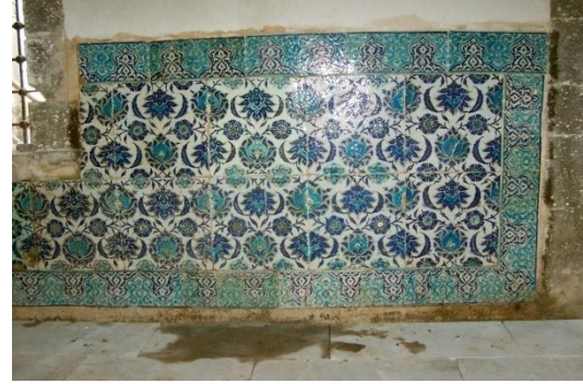
Fotoğraf-70: Kuzey Cephesi çinileri kimyasal temizlik sonrası (Melik Ahmet Paşa Camii, Diyarbakır).
