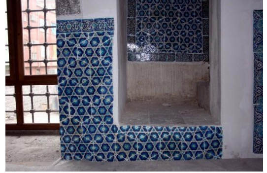
Fotoğraf-130: Mahfil merdiven eşiği çinileri restorasyon sonrası, detay (Melik Ahmet Paşa Camii, Diyarbakır).
