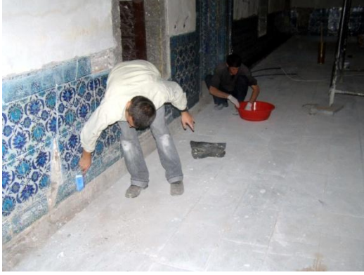
Fotoğraf-63: Çinilerin yüzeyindeki toz katmanlarının alındığı genel temizlik (Melik Ahmet Paşa Camii, Diyarbakır).
