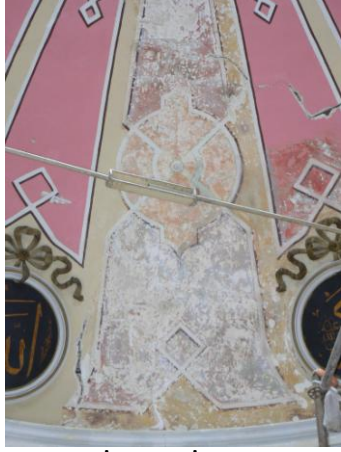
Fotoğraf-25: İzmir İkiçeşmelik Camii kubbesi sıva üstü kalem işleri raspa çalışması.
