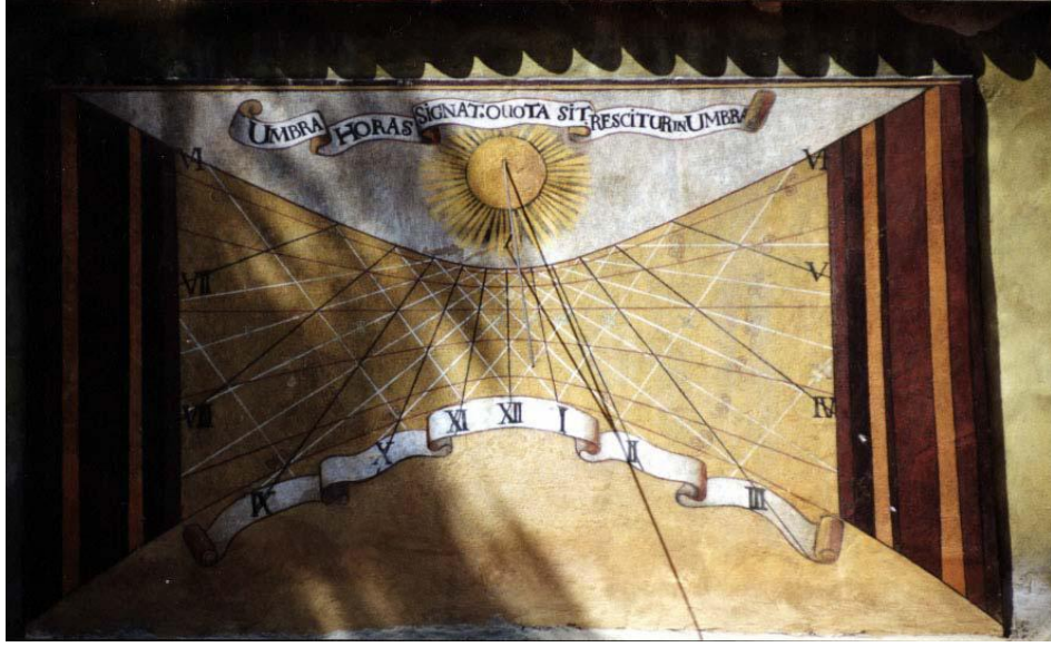
Resim:Çek Cumhuriyeti'nde yer alan Güney yönelimli dikey kadranlı bir Güneş saati. Kadran, ufuk düzlemine dik bir düzlemdir.
