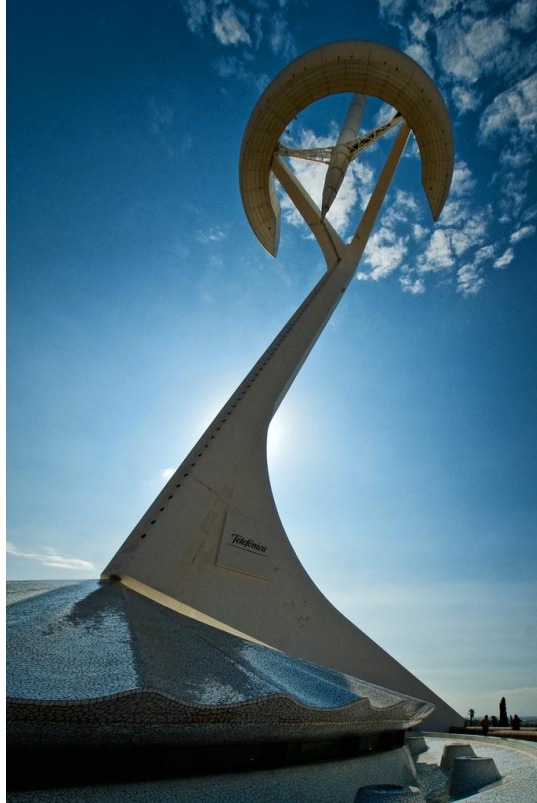
Resim 42: Montjuic iletişim kulesi farklı açıdan görünüm
