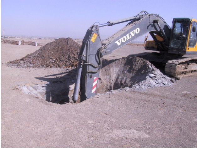
Şekil 5.8 Liç artık döküm sahasında açılan 3 nolu kuyu
