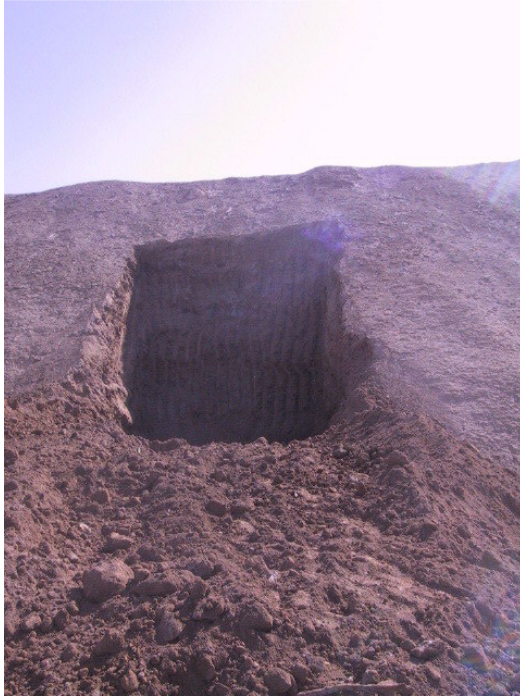
Şekil 5.6 Liç artık döküm sahasında açılan 1 nolu yarma
