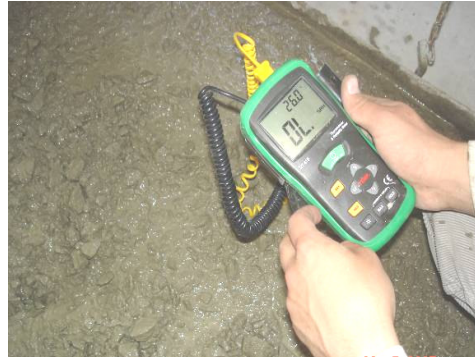
(b) Hava ve beton sıcaklığı ölçümü
