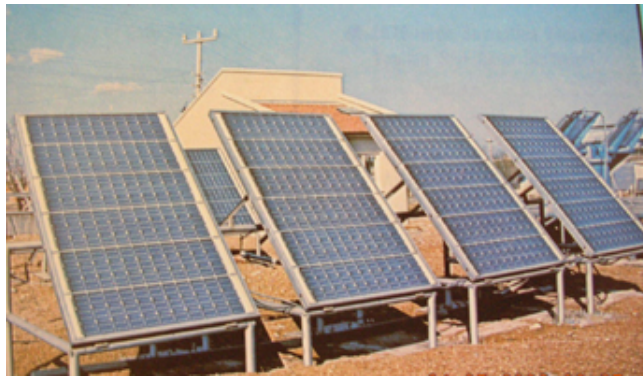
Şekil 1.5 Elektrik ihtiyacını karşılamak amacıyla kurulmuş tek kristalli güneş pili sistemi (1.6 kWp gücünde) (EİE, 2009)
