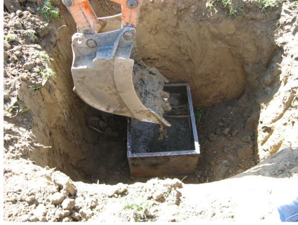
Şekil 6.24 Dikdörtgen prizmasının beton ile doldurulması
