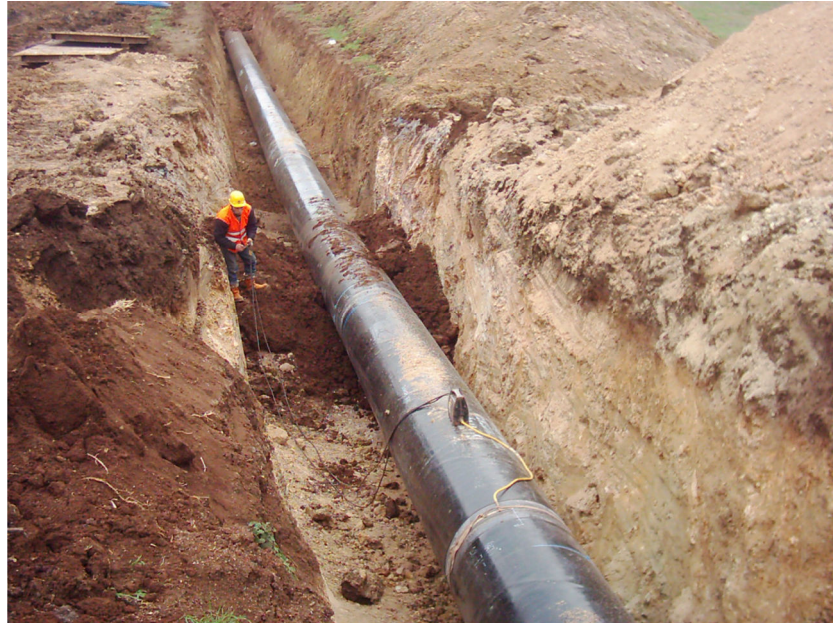
Şekil 6.26 Aydın - İzmir arası doğalgaz boru hattı döşeme çalışması
