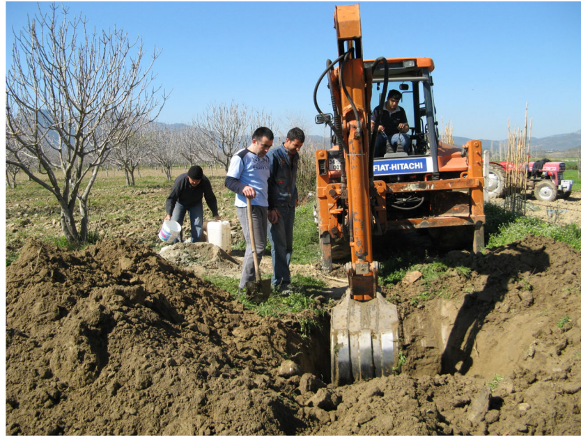
Şekil 6.23 Test alanı yapım çalışması
