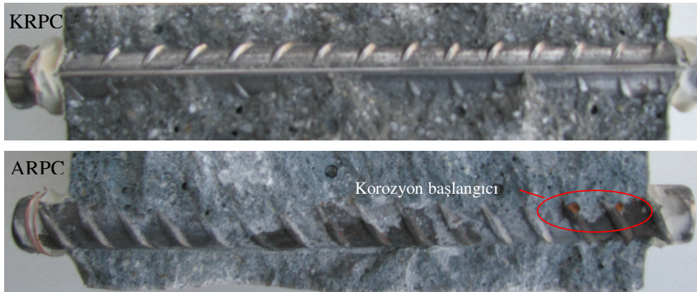
Şekil 9.46 %3,5 NaCl çözeltisinde 400 çevrim ıslanma-kuruma sonunda ARPC ve KRPC karışımlarında donatıda korozyon oluşumları.
