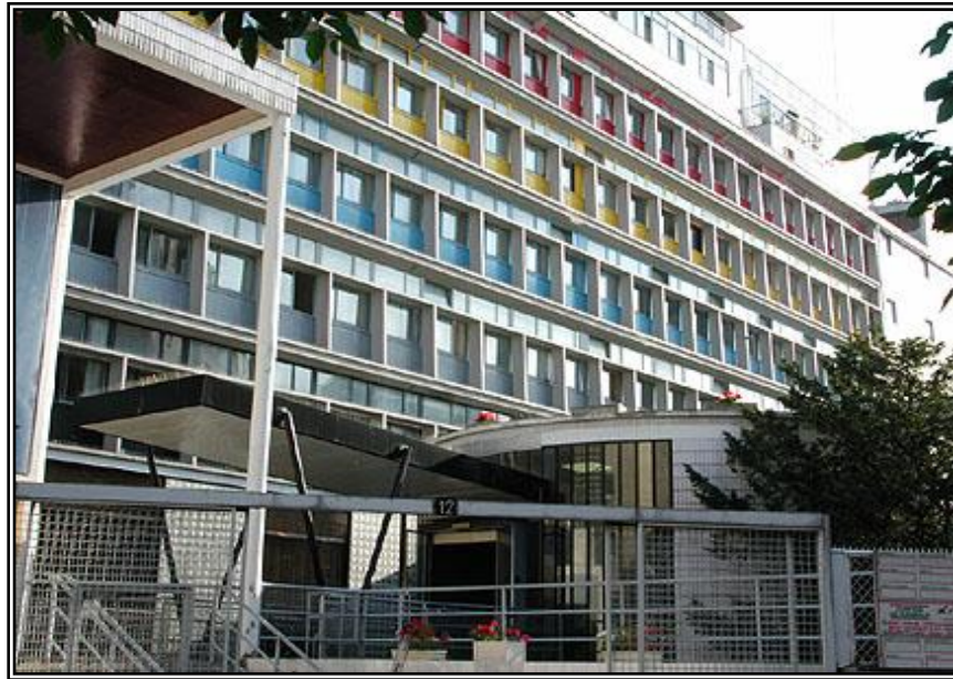
Şekil 2.6 Cité de Refuge Binası, (Evsizler sitesi), ((b.t.). 10 Temmuz 2009, http://www.galinsky.com/buildings/refuge/index.htm )
