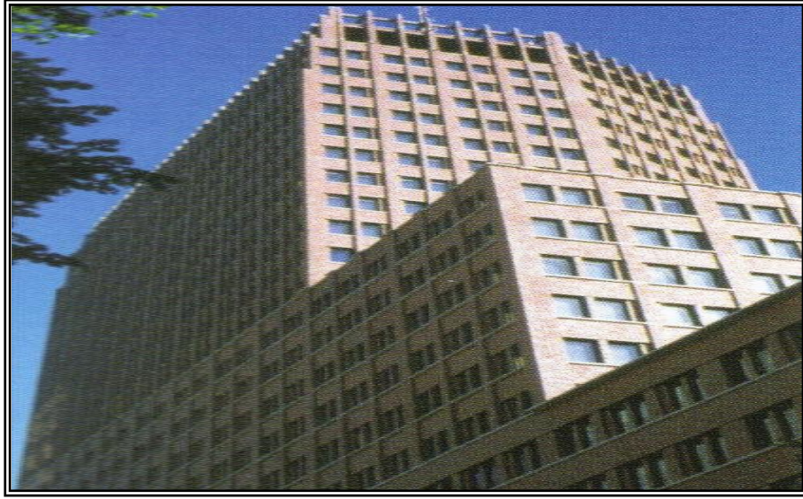
Şekil 2.11 Potsdamer Platz Binası Dış Görünüşü, ( High Rise Manual s.140)
