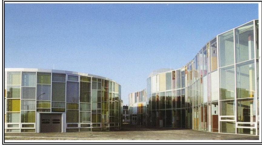
Şekil 2.25 Photonics Centre Binası'nın Dış Görünüşü. (Compagno, 2002, s 154).
