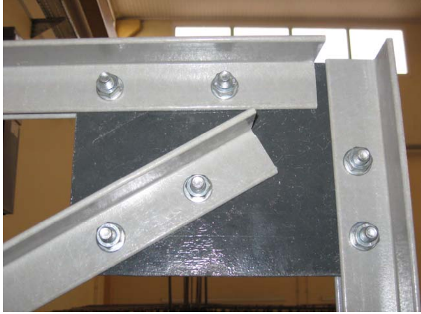
Şekil 5.45 Kafes sistem üst düğüm noktası ve birleşim levhası.
