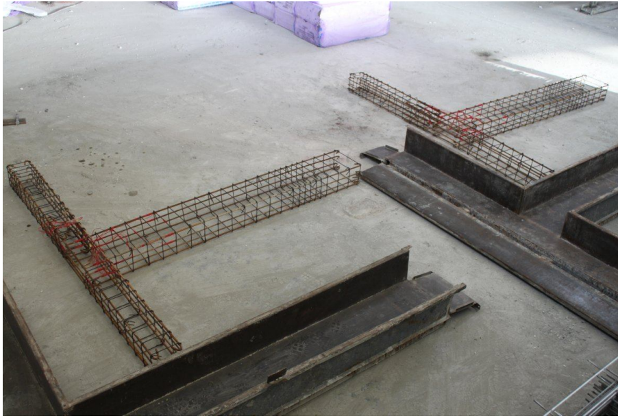
Şekil C.4 Beton dökümü öncesinde hazırlanan kalıp ve donatılar
