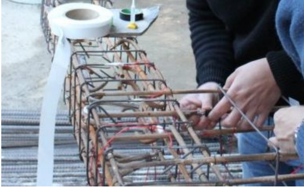
Şekil C.2 Gerinim ölçer ve terminallerin donatı iç yüzeyine yapıştırılması
