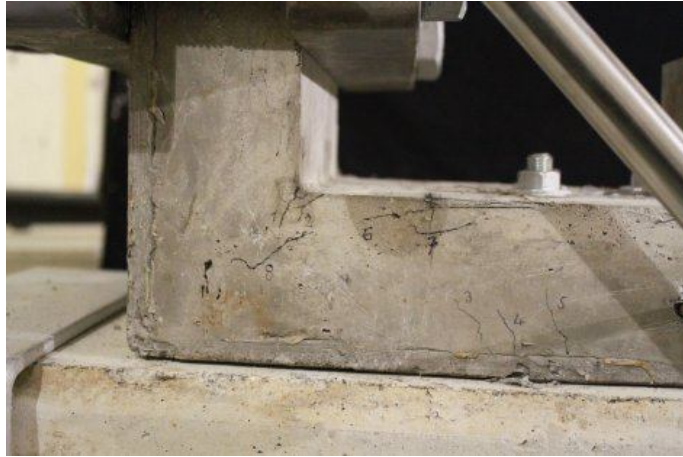
Şekil 2.30 S2 numunesinin % 1,9 ötelenmedeki hasar durumu.
