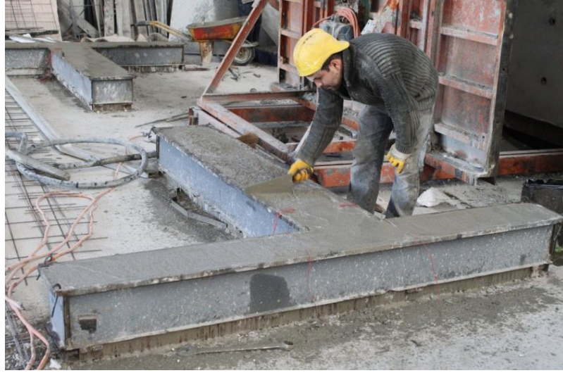
Şekil C.6 Döküm sonrası beton yüzeyinin düzeltilmesi
