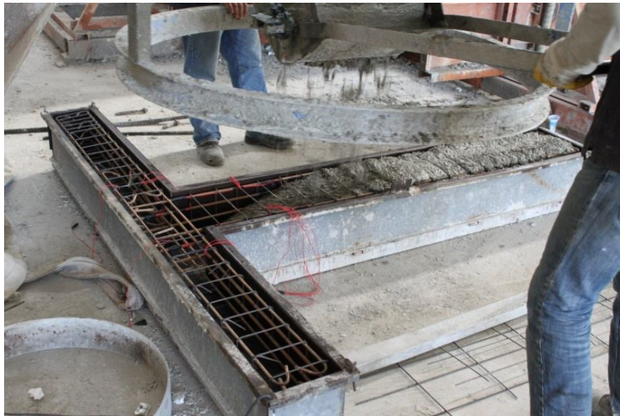
Şekil C.5 Beton dökümü
