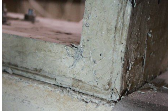
Şekil 2.25 S1 numunesinin % 3,6 ötelenmedeki hasar durumu.
