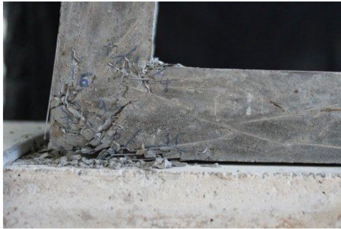
Şekil 2.37 S3 numunesinin % 9,0 ötelenmedeki hasar durumu.
