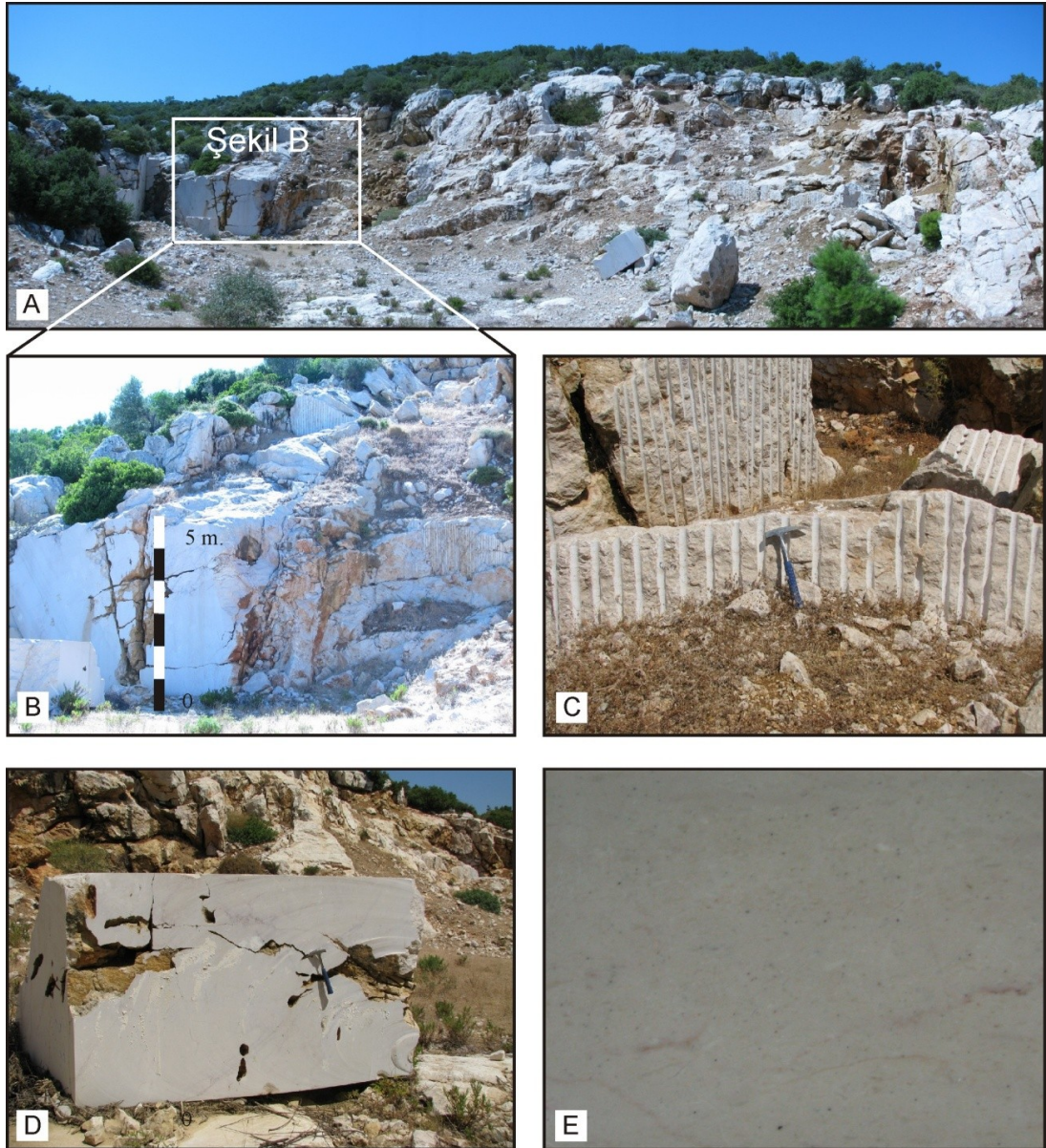
Şekil 4.88 On numaralı blok taş ocağının görünümü (A, B C), ocakta üretilen bloklar (D) ve 10x10 cm 2 lik fayansın görünümü (E). Koordinat: 35457571/4262817.
