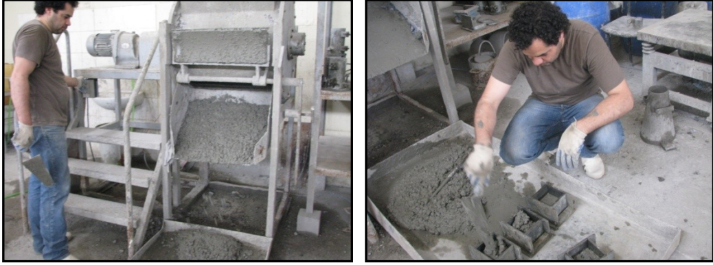
Şekil 8.26 Beton üretimi ve beton kalıplarına yerleştirilmesi
