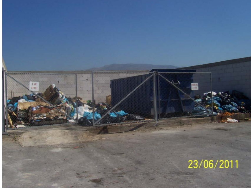
Şekil 3.14 İzmir Limanı Katı Atık Toplama Havuzu
