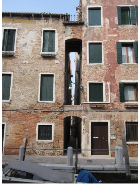
Şekil 5.1 Venedik’te vapur kaynaklı titreşimleri azaltmayı hedefleyen yapı kemerleri
