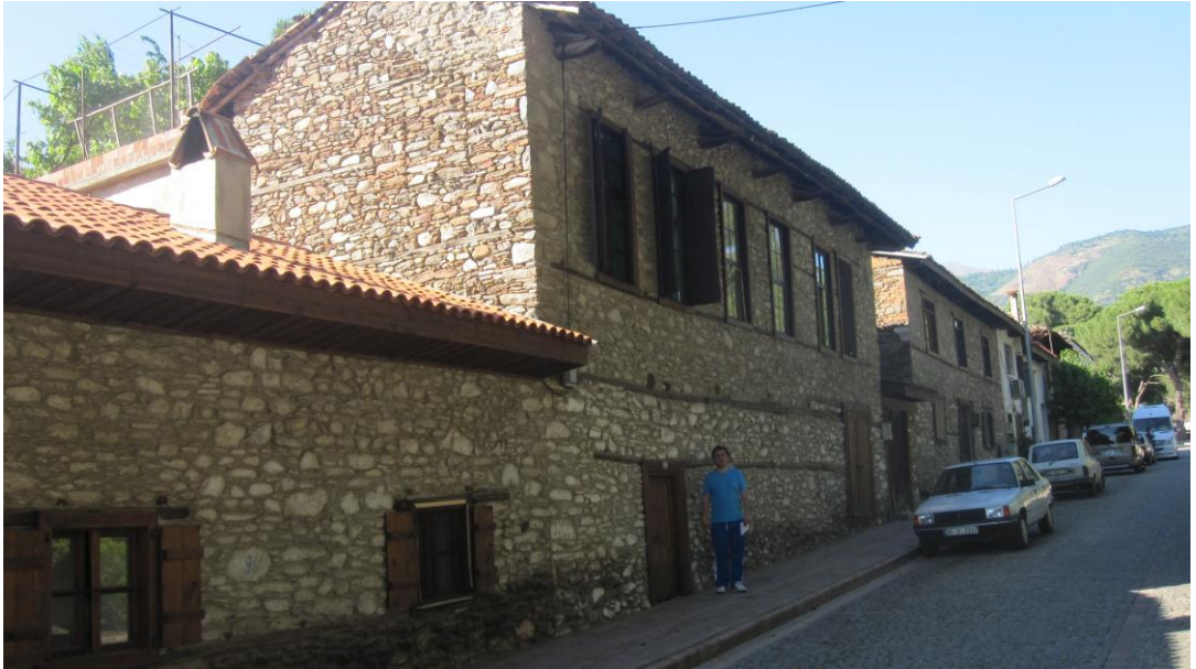
Şekil 3.5 94/B no'lu yapı
