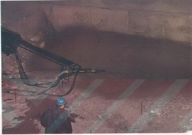
Şekil 4.6 Püskürtme Beton Atılması
