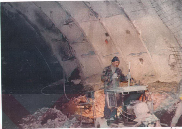
Şekil 4.7 Bulon Deliğine Enjeksiyon (Çimento-Su Karışımı) Basma İşlemi
