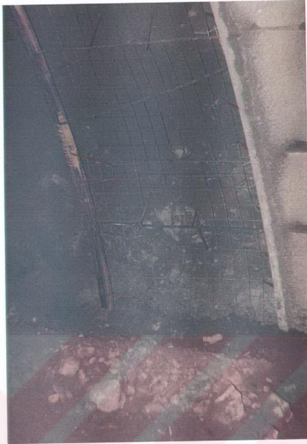
Şekil 4.5 Hasır ve İksa Montajı Tamamlanmış Bir Roundun, Püskürtme Betonunun Öncesi Son Hali
