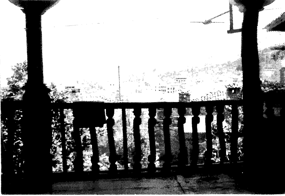
Şekil 3.152 Avrahoğulları Evi Sofadan Ovaya Bakış – Parapet Detayı
