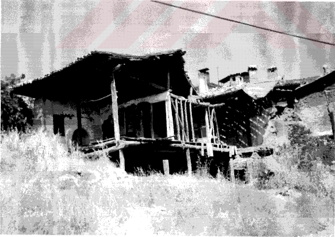
Şekil 4.7 Yıkılmış Tarihi Bir Ev
