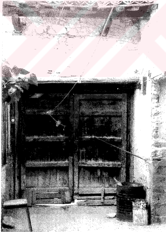
Şekil 3.153 Avrahoğulları Evi Avlu Kapısı
