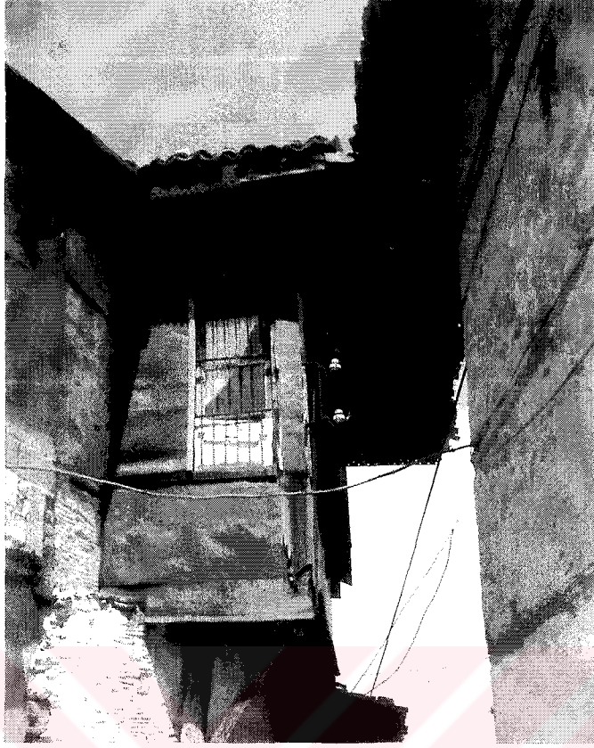
Şekil 3.144 Avralhoğulları Evi Giriş Cephesi
