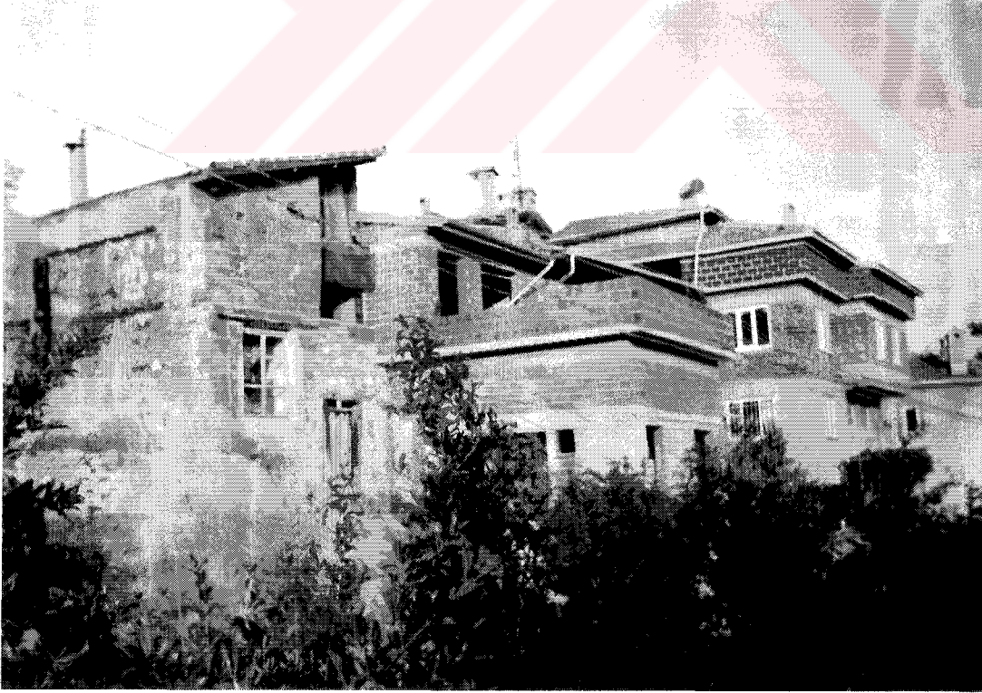
Şekil 4.5 Kayalar Sokağı Üzerinde Yangından Sonra Yapılmış Apartmanlar
