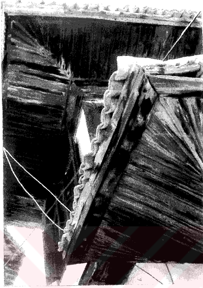
Şekil 3.146 Avralioğulları Evi Giriş Cephesi Saçakları
