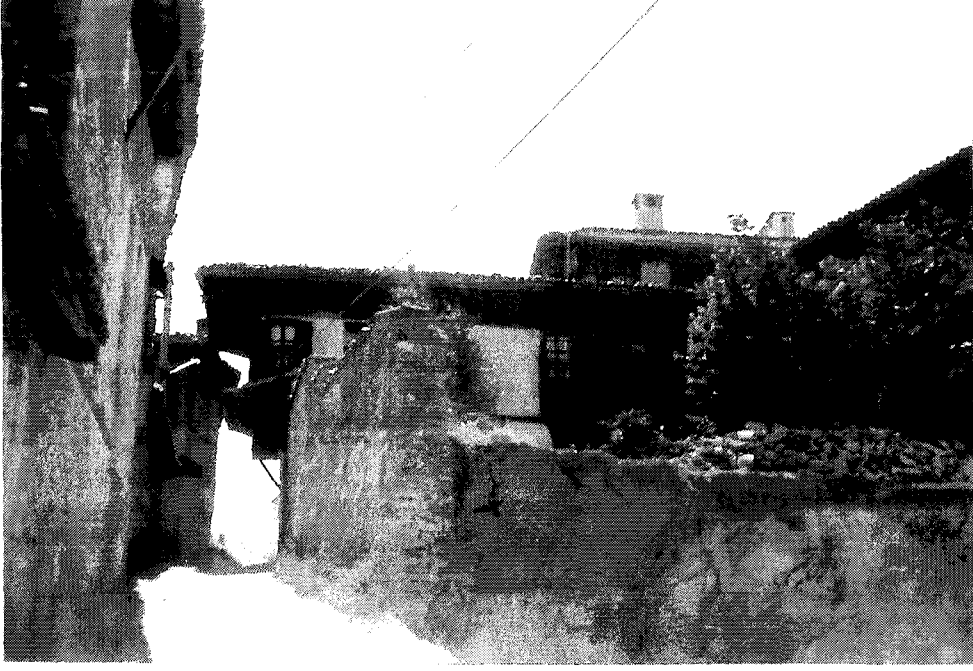
Şekil 3.142 Avrahoğulları Evi Sokaktan Görünüş
