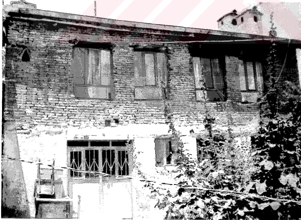
Şekil 3.53 Yüzeyi Sıvanmadan Bırakılmış Tuğla Duvar Örneği.
