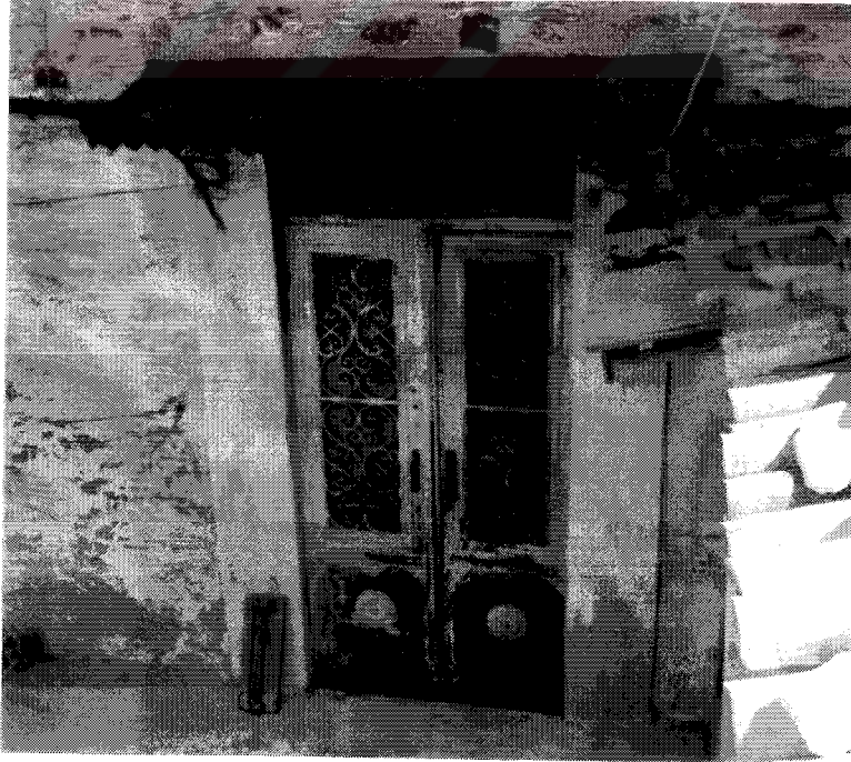
Şekil 3.172 Talat Tarakçı Evi Giriş Kapısı
