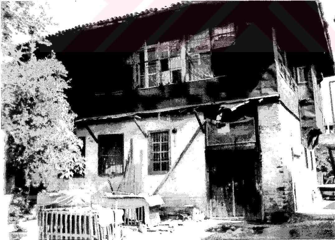
Şekil 3.57 Cephesi Ahşabı Koruma Amacıyla Teneke İle Kaplanmış Bir Buldan Evi
