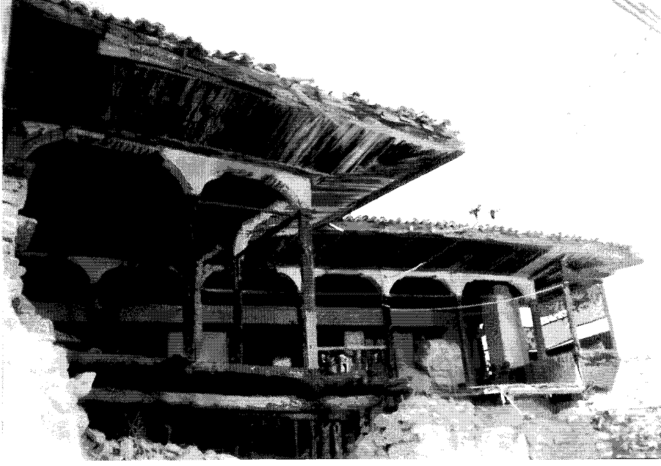
Şekil 3.113 Şazuman Bey Evi Cephesi, Sol Kanat Yıkılmadan Önce
