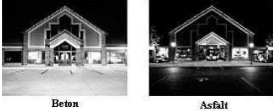
Şekil 2.1 Beton yol ve asfalt yolun gece görüntüleri
