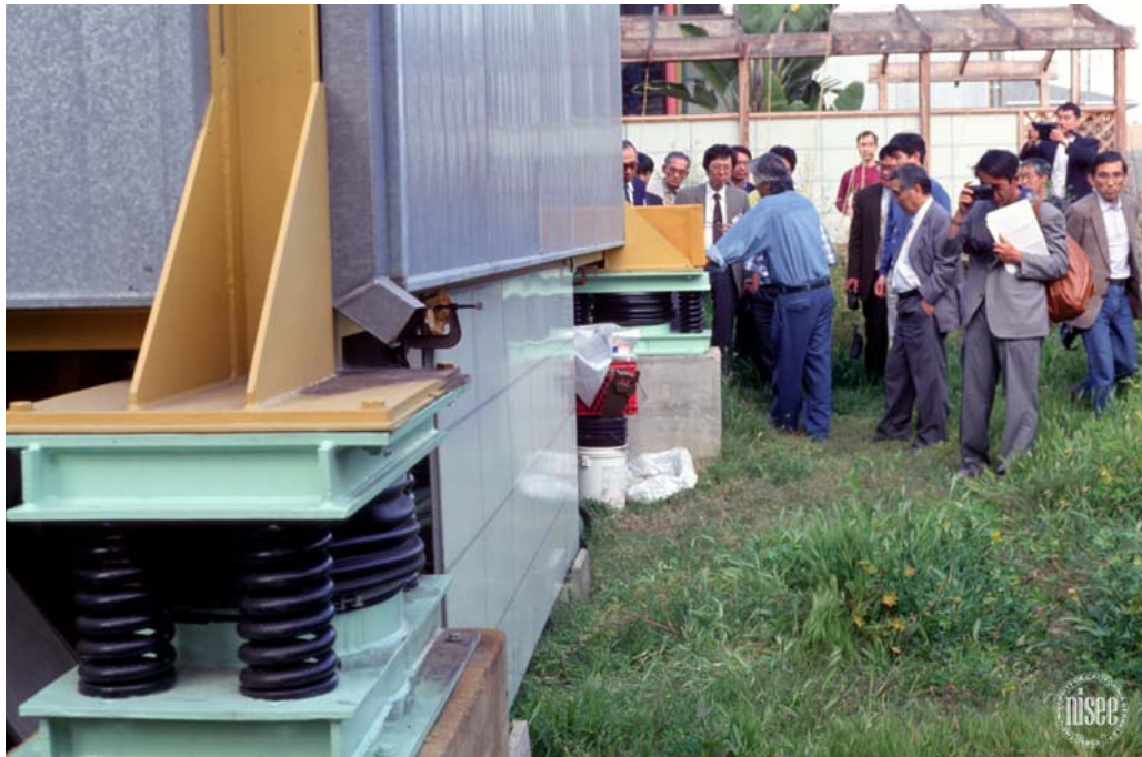
Şekil 2.15 Yay tipi sistemlere örnek uygulama-Gerb sistemi (University of California Berkeley, b.t.)
