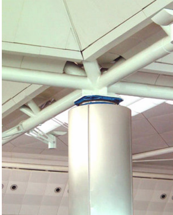
Şekil 2.12 Atatürk Hava Limanı Terminalinin çatısında kullanılan sürtülmeli sarkaç mesnet detayı (Earthquake Protection Systems Inc., b.t.)
