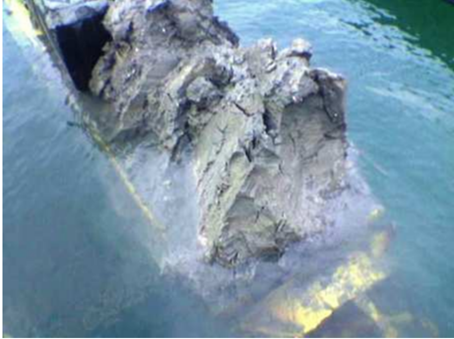
Şekil 2.2 Sıkı zeminde ekskavatörlü tarama ile yapılan bir çalışma (Yurder, 2005).
