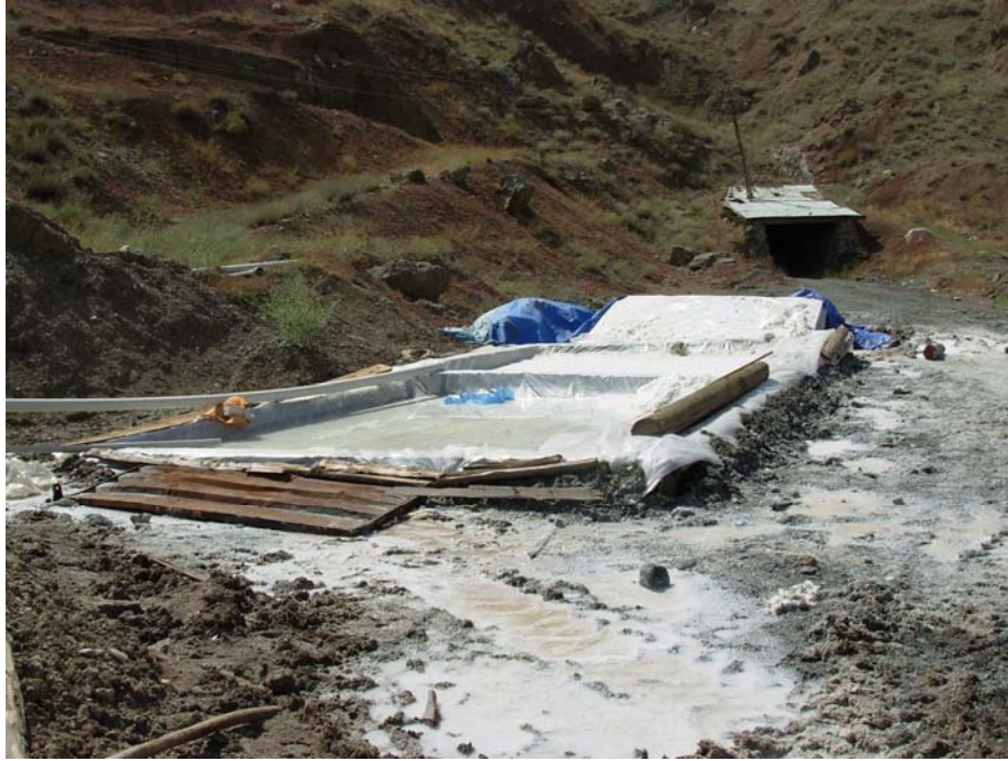
Şekil.5.6 Kağızman kaya tuzu kapalı işletmesinde görülen tuz havuzu, bu havuza kapalı işletme girişinde bulunan bir çatlaktan sızan tuzlu su aktarılmaktadır.
