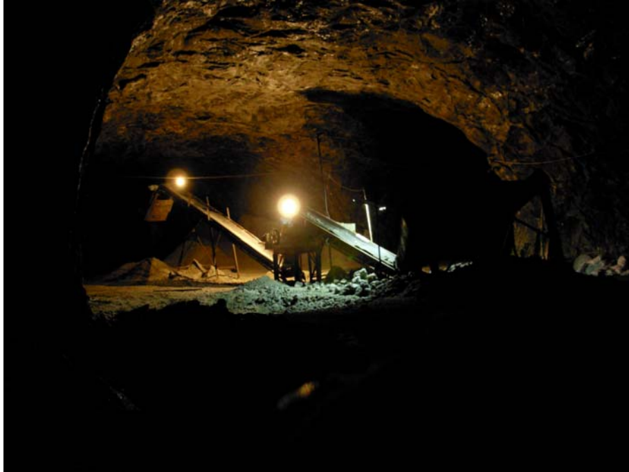
Şekil 5.9 Tuzluca kaya tuzu kapalı işletmesinde bulunan oda ve topuğun görünümü. Odalardan dinamit ile patlatılan tuz, birincil kırıcıdan geçirildikten sonra ikincil kırıcıdan da geçirilerek istenen boyuta getirilir ve elde edilen bu tuz kamyon yardımıyla dışarı çıkarılıp paketlenir.
