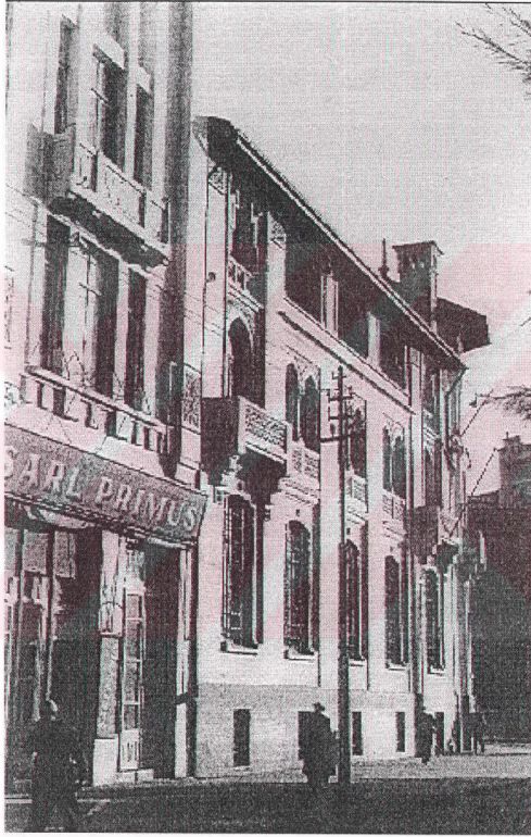
Şekil 4.15 Yan cephe ve çevresinin eski görünümü
