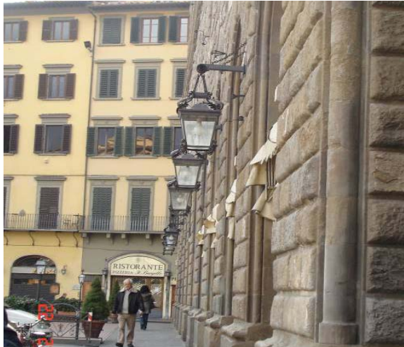
Şekil 4.22 Mimari tasarım prensiplerine uygun olarak dizi şeklinde yerleştirilmiş aydınlatma elemanları.
