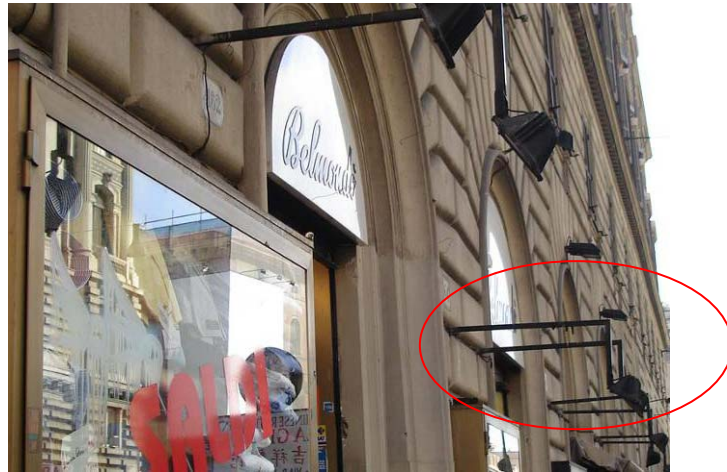
Şekil 4.26 Roma'da zemin kat dükkanları aydınlatan bir dizi halinde konumlandırılmış konsol aydınlatma elemanları
