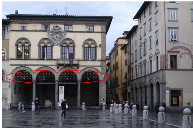
Şekil 4.73 Lucca'da meydana bulunan, zemin katı boşaltılan bir yapı ve aydınlatma elemanları
