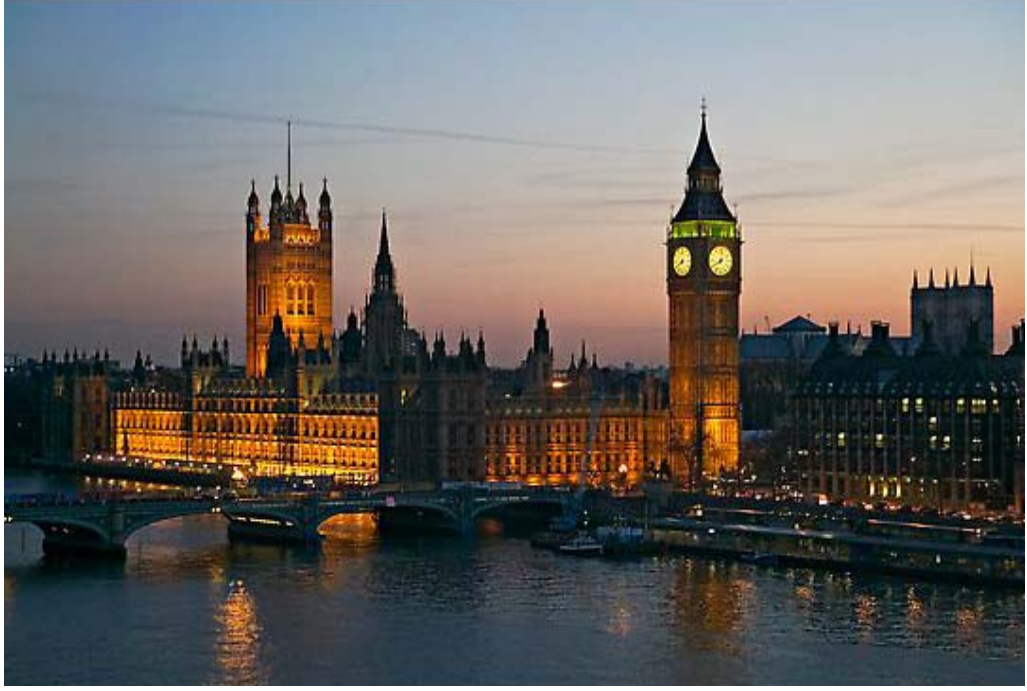
Şekil 2.3 Londra, İngiltere, Parlamento Binası ve Saat Kulesi, (İngiltere Fotoğrafları, (b. t). 2007, www.terrageria.com) Kulenin ve yapının aydınlatma ile gündüzden daha etkili olarak algılanışı
