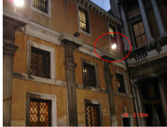
Şekil 4.32 Venedik'te sokak ve zemin kat aydınlatması için kullanılan projektör tipi örneği ve konumu
