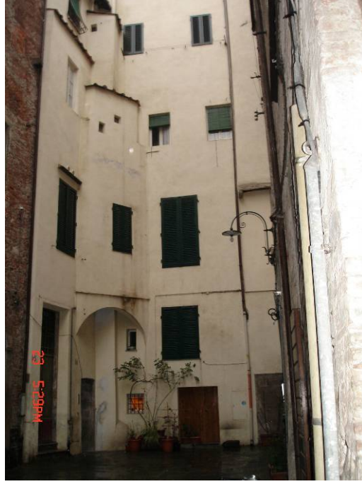
Şekil 4.20 Lucca'da bir binaya çıkan sokaktan görünüm
