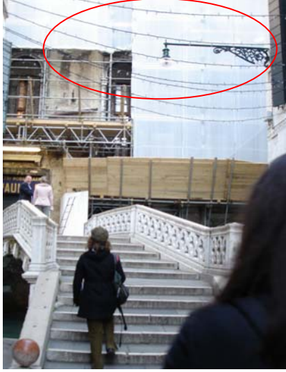
Şekil 4.16 İki cephe arasında asılan ışıklı örtü ve aydınlatma elemanı
