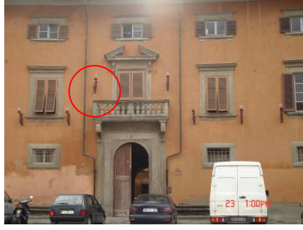
Şekil 4.42 Pisa'da ritmik aydınlatma elemanlarının olduğu bir cephe
