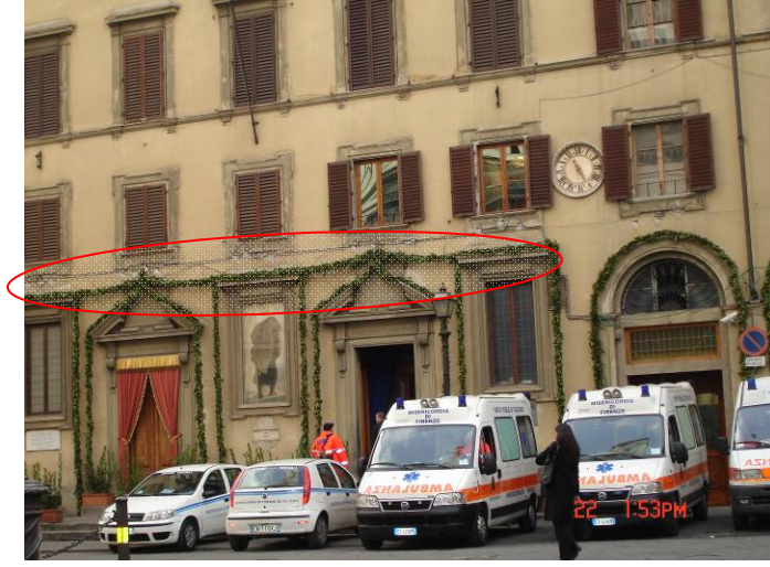
Şekil 4.31 Floransa'da bir yapının cephesi üzerine aydınlatma elemanlarının monte edilmesi sonucunda açıkta bırakılan kabloların oluşturduğu görüntü kirliliği
