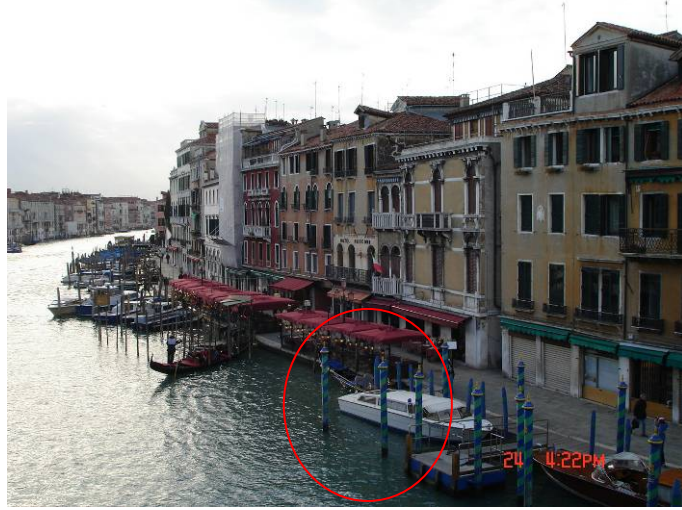
Şekil 4.12 Su altına monte edilmiş olan direkler ve uçlarına yerleştirilen armatürler.
