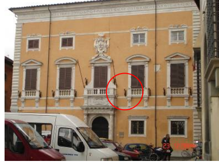
Şekil 4.43 Pisa'da ritmik aydınlatma elemanlarının olduğu bir cephe
