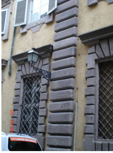
Şekil 4.29 Tarihi doku içine monte edilmiş aydınlatma elemanı
