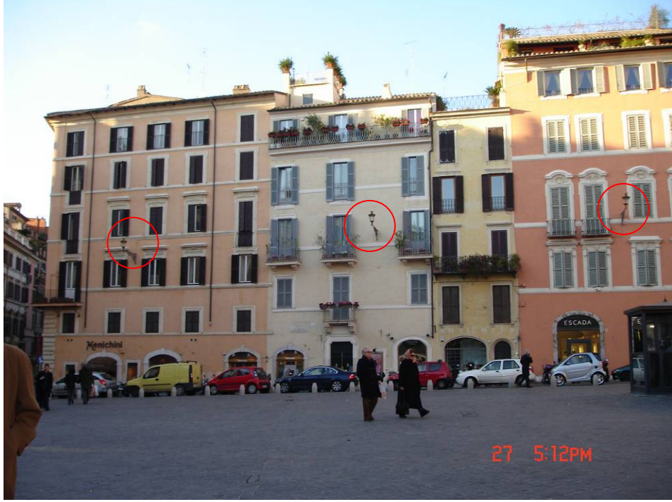
Şekil 4.28 Roma'da bir cephe üzerine monte edilen tekil aydınlatma elemanları
