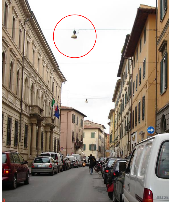
Şekil 4.8 Pisa’da iki cephe arasına yerleştirilen sokak aydınlatma elemanı
