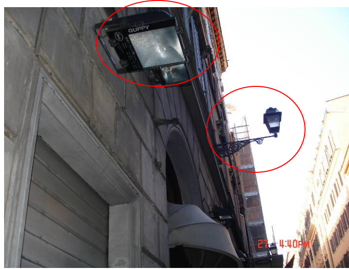
Şekil 4.54 Sokak, dükkan ve zemin kat aydınlatması için tarihi yapının cephesine monte edilen farklı tipte elemanlar
