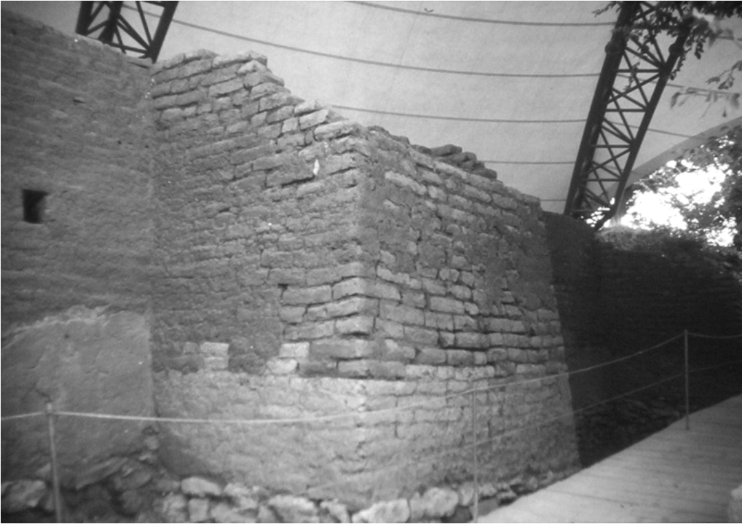
Şekil 3.105 Troya II/III, G-6 megaronu , koruma çatısı, iç görünüm, restorasyonu tamamlanmış kerpiç duvarlar, (Dinçer, bt).
