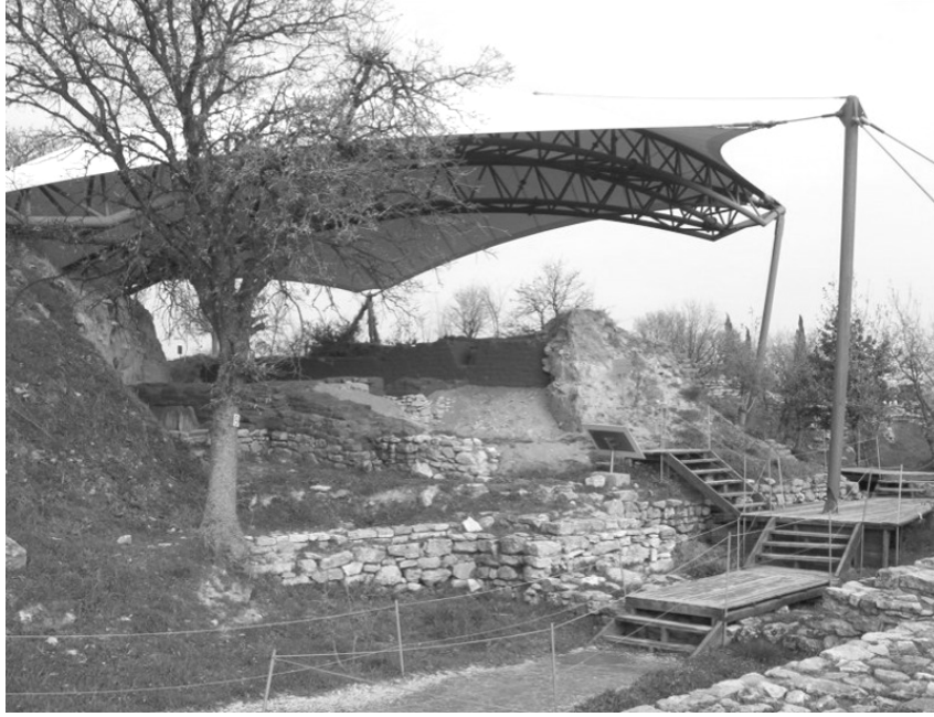
Şekil 3.102 Troya II/III, G-6 açmasındaki megaron kerpiç kalıntıları koruyan modern çatı strüktürü, ve gezi platformu, (Dinçer, bt).
