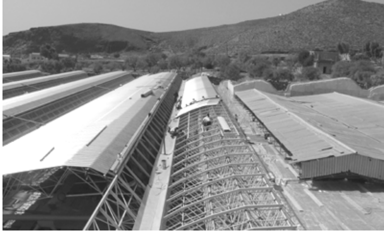
Şekil 3.10 Mevcut koruma çatısının yerine yenisinin inşa edilmesi, Ocak 2003, (Doumas ve Fintikakis, 2007).
