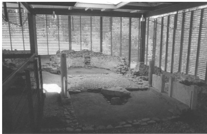
Şekil 3.127 Hıristiyanlığın ilk zamanlarına ait Piskopos Kilisesi üzerine inşa edilen koruyucu strüktür, (Schirmer, 2000, s.36).
