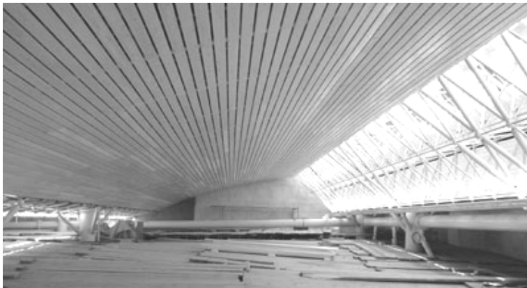
Şekil 3.12 Strüktürün, kalıntılara bakan iç kısımlarının ahşap malzeme ile kaplanması, Haziran 2005, (Doumas ve Fintikakis, 2007).
