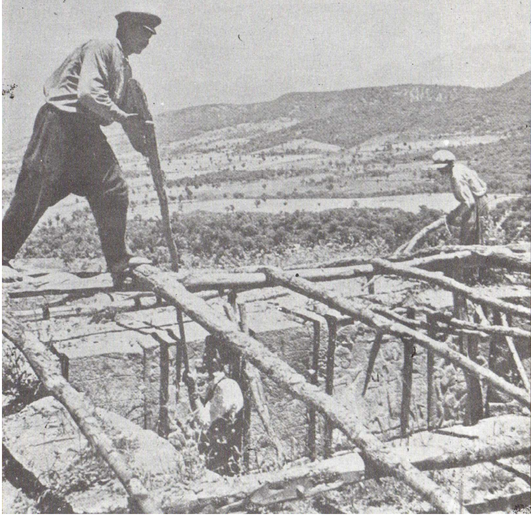
Şekil 3.97 Karatepe kazı alanı, kabartmaların üzerlerinin geçici koruyucu örtüsü ile kapatılması, (Erendor, E., çev., 1994).
