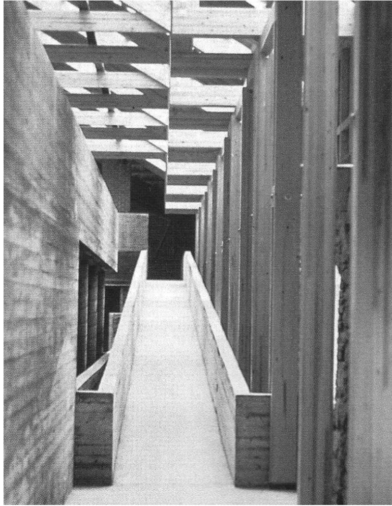
Şekil 3.121 Hedmarkmuseum, koruma çatısı içi, ahşap oturma çatı, yürüyüş yolları, (Fehn, 2005, s. 121).
