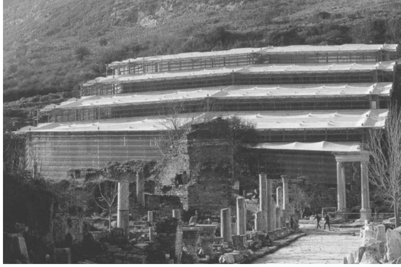
Şekil 3.87 Mermer Cadde'den Yamaç Ev 2 üzerindeki koruma binasına bakış, kuzey cephesi, (Achleitner, 2000, s. 45).
