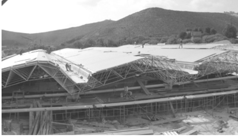
Şekil 3.11 Şantiye sürecinde ilk dört tonozun alüminyum malzeme ile kaplanması, Ocak 2003, (Doumas ve Fintikakis, 2007).
