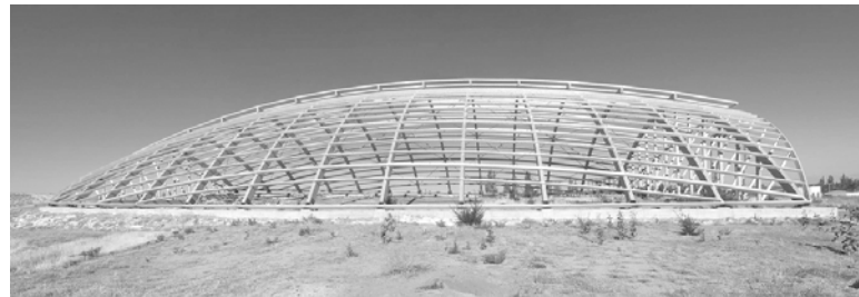
Şekil 3.76 Çatı strüktürü yapım süreci (ahşap lamine konstrüksiyon taşıyıcılar), (Çatalhöyük, shelter under construction , 2008).
