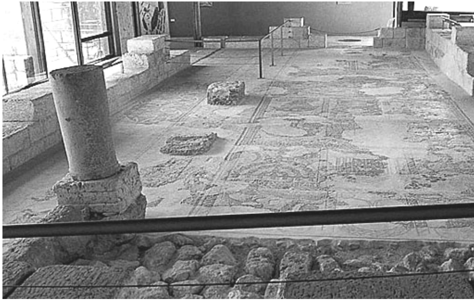
Şekil 3.133 Zippori, Sinagog, koruma çatısı, koruma çatısı içi, mozaik döşeme, (Stewart, Neguer ve Demas, 2006).
