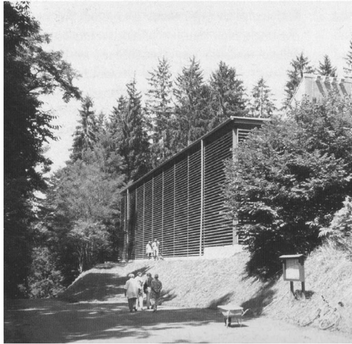
Şekil 3.126 Hıristiyanlığın ilk zamanlarına ait Piskopos Kilisesi üzerine inşa edilen koruyucu strüktür, (Schirmer, 2000, s.36).
