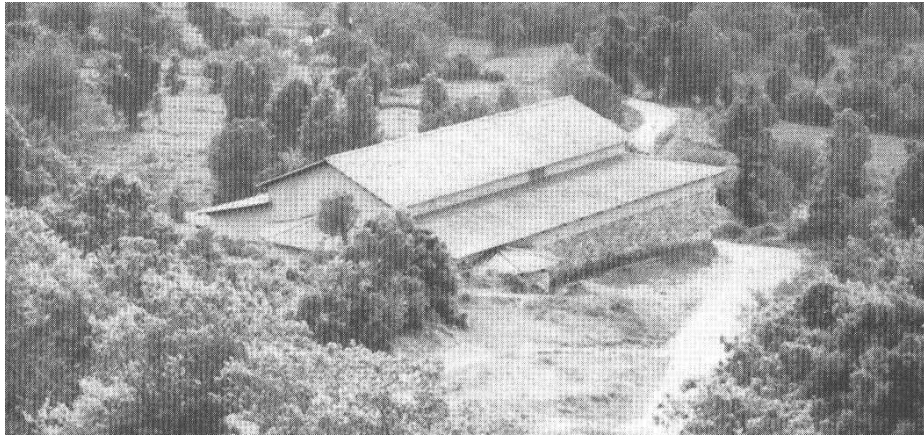
Şekil 3.128 Klavsi (Yunanistan), Leonides Bazilikası üzerindeki ahşap koruma binası, (Schirmer, 2000, s.37).
