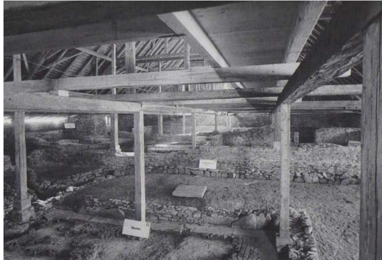
Şekil 3.125 Hüfingen (Almanya), Roma Kale Hamamı üzerindeki koruma binası, gezi platformları ve sergilenen kalıntılar, (Schirmer, 2000, s.36).
