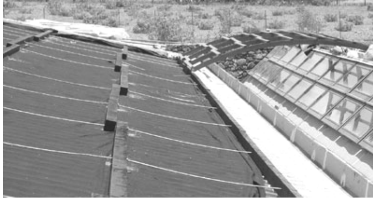
Şekil 3.13 Alüminyum çatı kaplaması üzerinin geotextil malzeme ile kaplanması, Mayıs 2005 , (Doumas ve Fintikakis, 2007).
