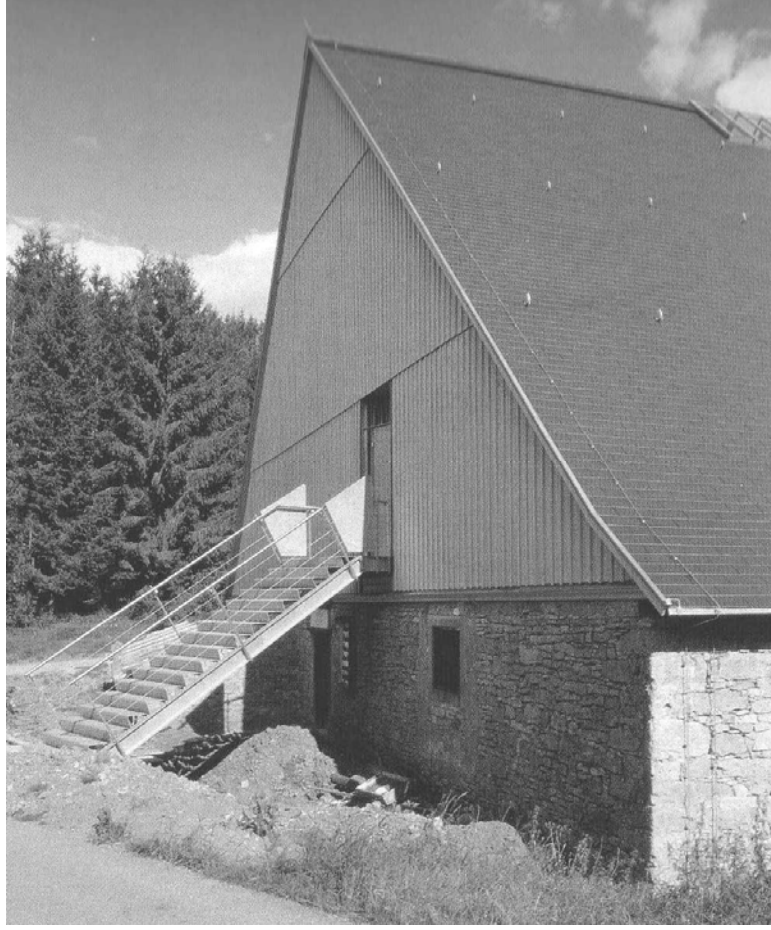
Şekil 3.124 Hüfingen (Almanya), Roma Kale Hamamı üzerindeki koruma binası, dıştan görünüm, (Schirmer, 2000, s.36).
