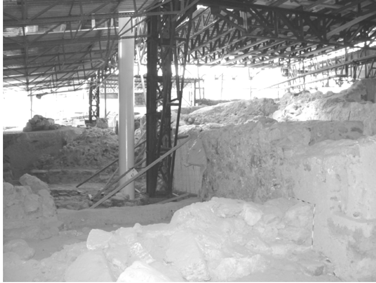
Şekil 3.20 Eski strüktüre ait kolonun yerine yenisini yerleştirilmesi, Mayıs 2003, (Doumas ve Fintikakis, 2007).
