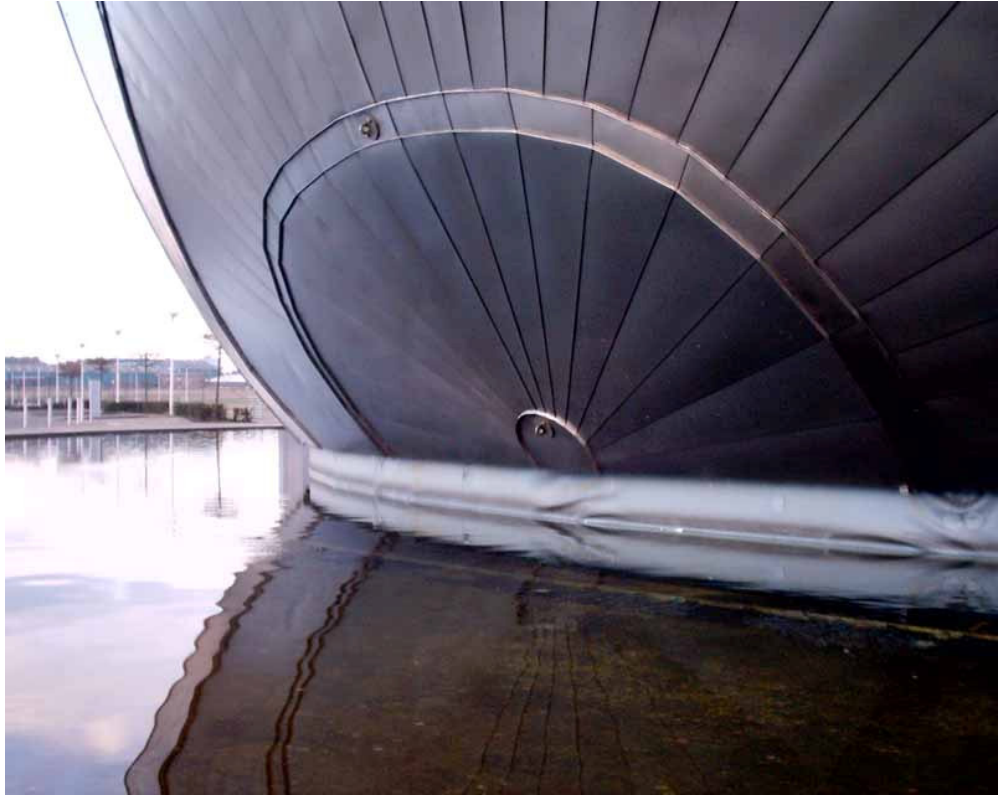
Şekil 3.23 İskoç Ulusal Bilim Merkezi dış cephe titanyum kaplama yakın görünüşü ( www.glasgowarchitecture.co.uk/jpgs/imax_base.jpg )
