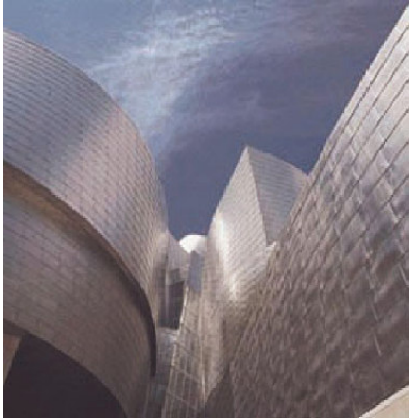
Şekil 3.14 Guggenheim müzesi dış cephe titanyum kaplama yakın görünüşü ( www.timet.com/architecture/portfolio.asp )
