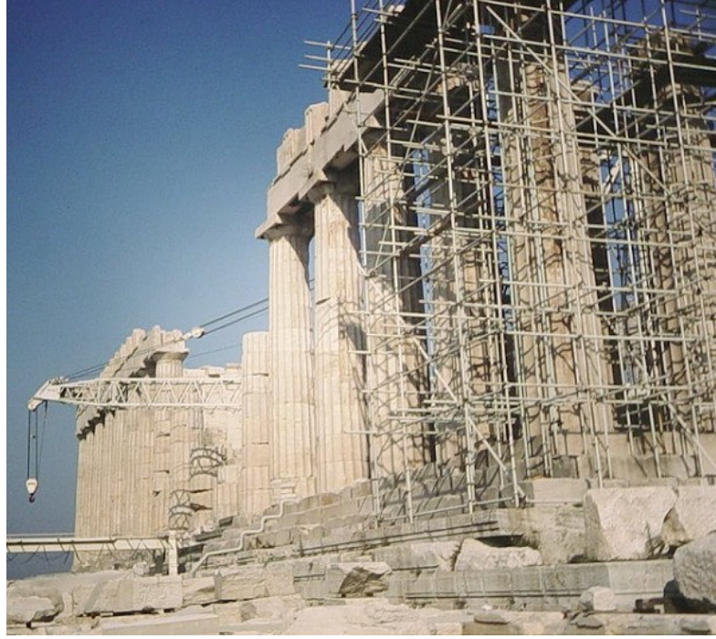
Şekil 3.83 Parthenon Tapınağı Restorasyonu ( http://en.structurae.de/structures/index.cfm )
