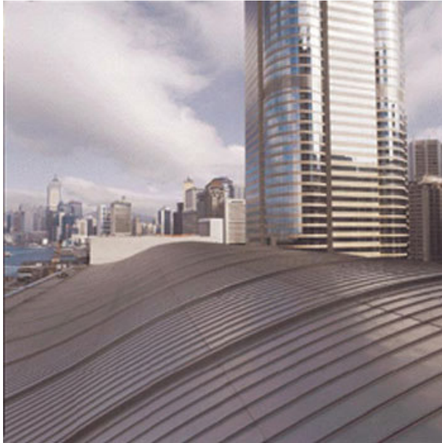
Şekil 3.55 MTRC Central Station çatısı genel görünümü ( www.timet.com/architecture/portfolio.asp )
