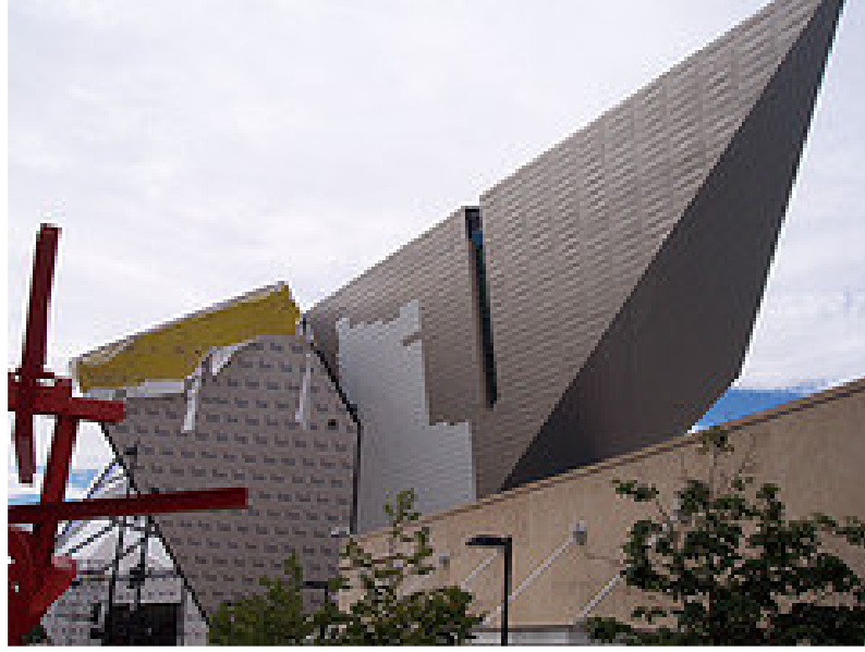
Şekil 3.42 Denver Art Müzesi yapım sırasında dış cephe kaplanması ( www.designbuild-network.com/projects/dam/dam8.html )
