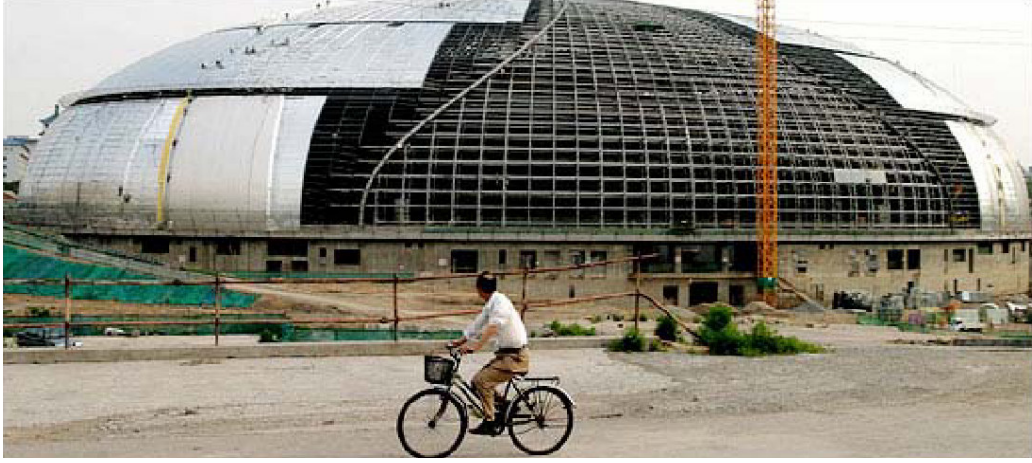
Şekil 3.48 National Grand Theater dış cephe kaplanması aşamasında görünüm ( www.paul-andreu.com/projets_recents/ )
