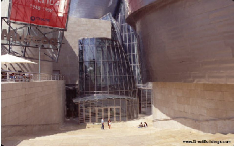
Şekil 3.13 Guggenheim müzesi girişi, ( www.greatbuildings.com/buildings/Guggenheim_Bilbao.html )
