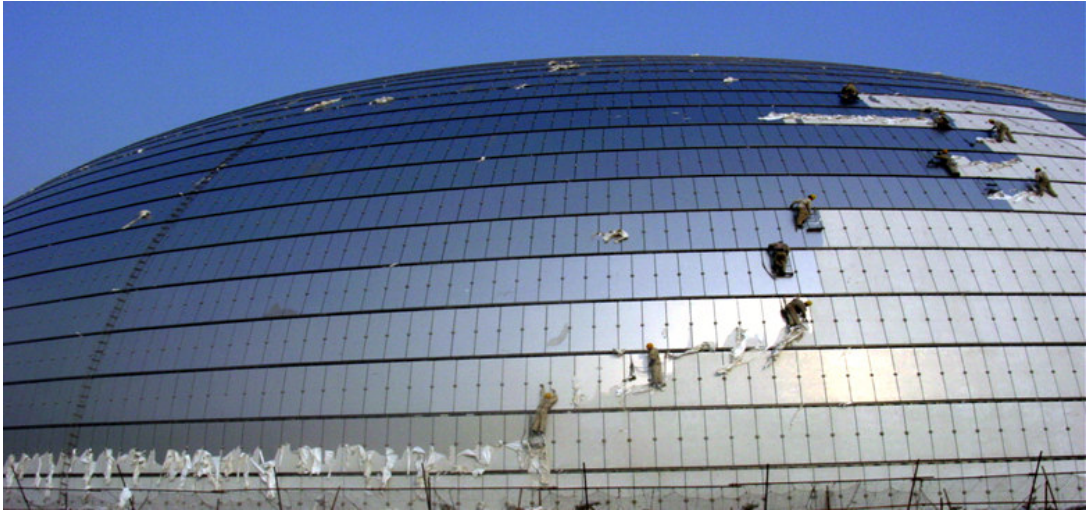
Şekil 3.47 National Grand Theater dış cephe titanyum kaplamasının koruyucularının çıkarılması ( www.chinadaily.com.cn/photo/2006-07/12/xin_2307031216196742750222.jpg )
