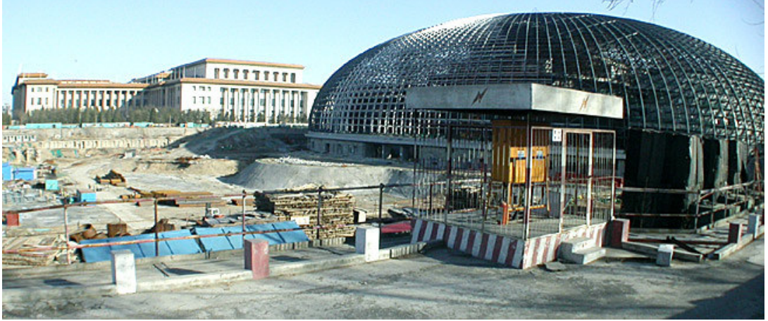
Şekil 3.46 National Grand Theater yapım aşamasında genel görünüm ( http://gluckman.com/ArchChina.html )
