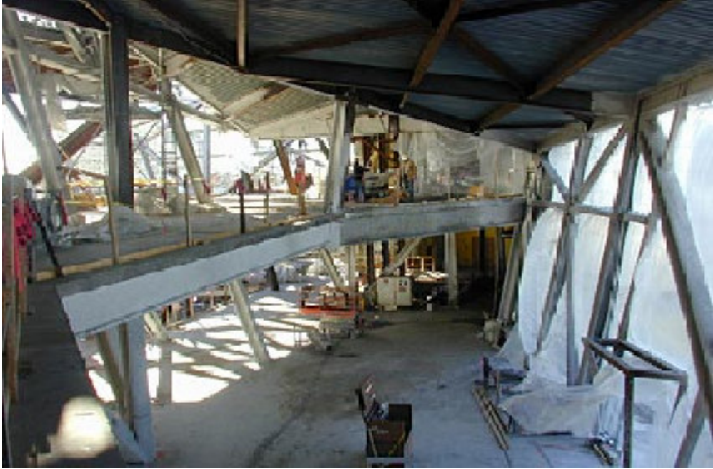
Şekil 3.41 Denver Art Müzesi yapım sırasında iç mekandan görünüm ( www.arcSPACE.com/architects/Libeskind/denver2/denver2.html )
