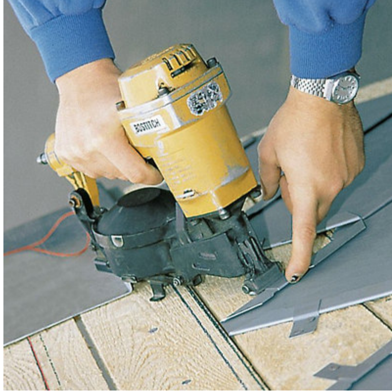
Şekil 3.7 Titanyum kaplamanın uygulanış yöntemi ( http://www.archidose.org/Jul04/071904f-pic.html )
