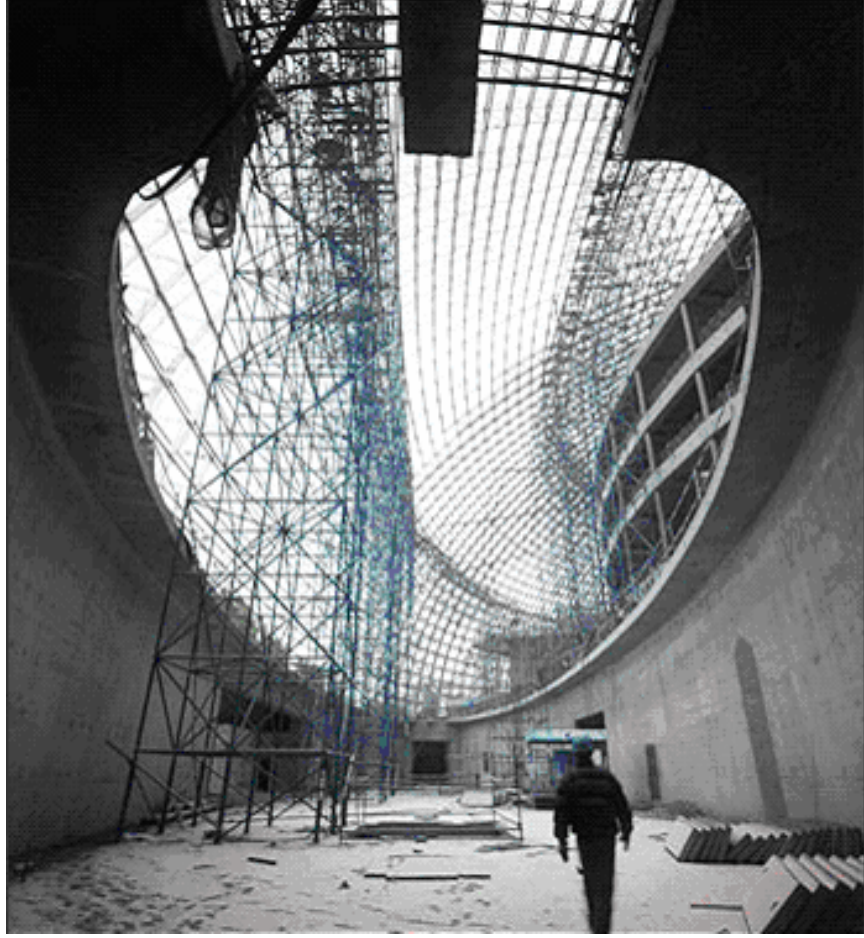
Şekil 3.50 National Grand Theater yapım aşamasında iç mekandan görünüm ( http://grace91grace.spaces.live.com/photos/cns!B6ED35857ADFAEF6!290/ )
