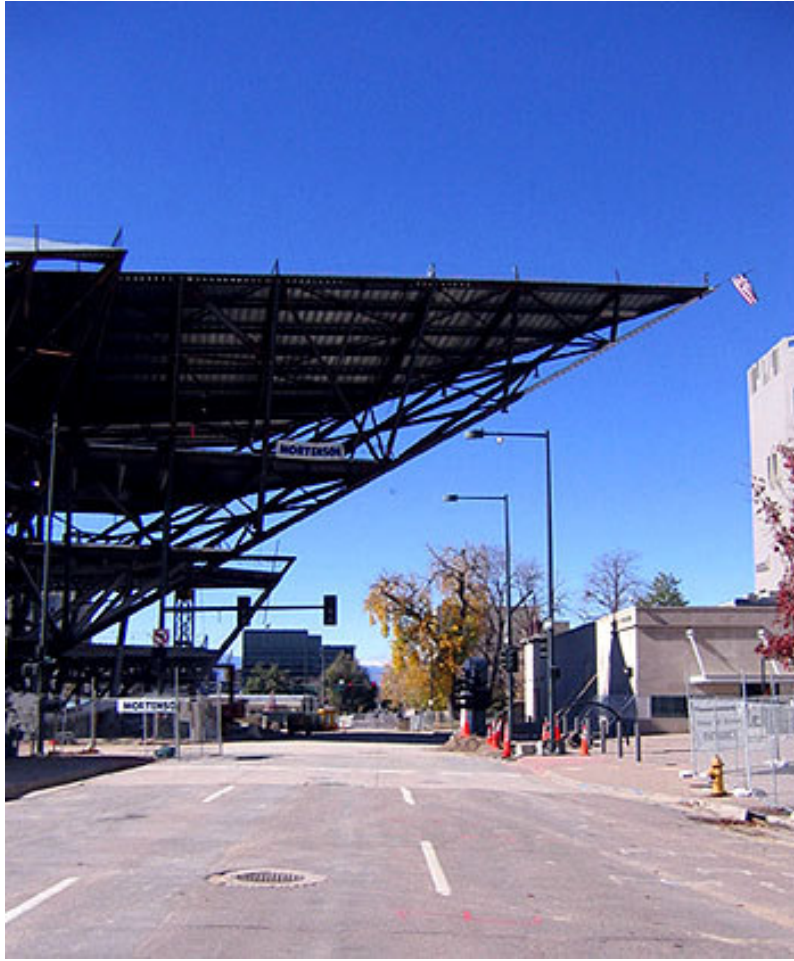
Şekil 3.43 Denver Art Müzesi taşıyıcı sistem kısmi görünümü ( www.designbuild-network.com/projects/dam/dam8.html )
