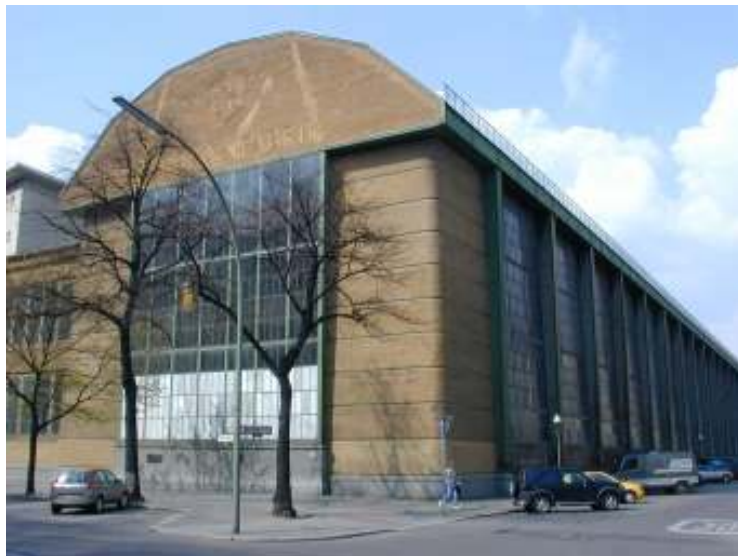
Şekil 2.1 Peter Behrens, Aeg Fabrikası (Peter Behrens. b.t)
