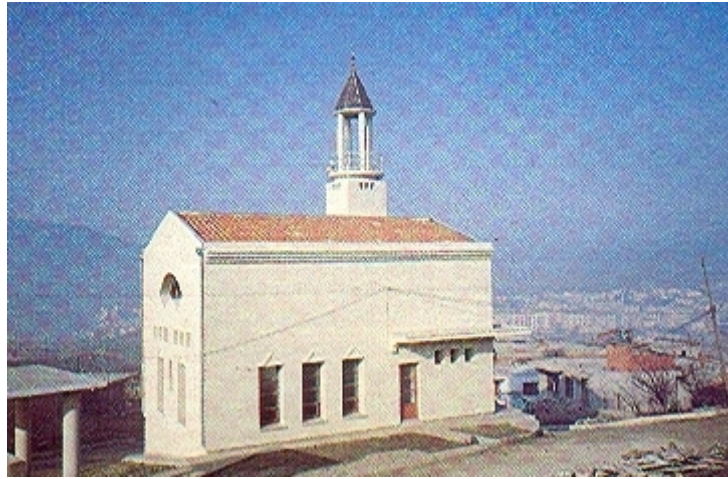
Şekil 5.8 Yapının genel görünüşü (Yücesan, 1991, s.57 ).
