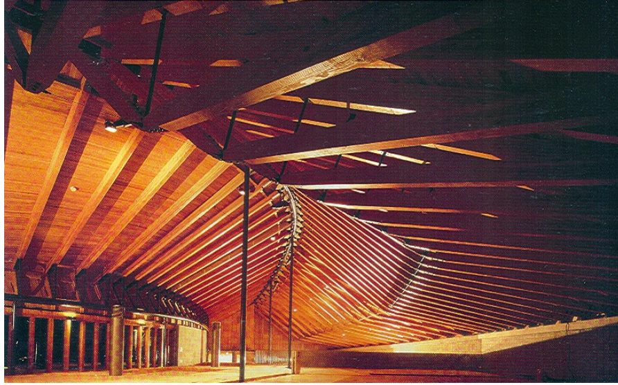
Şekil 5.78 Yapının iç mekanından görünüş ( Naito, 2001, s.898 ).
