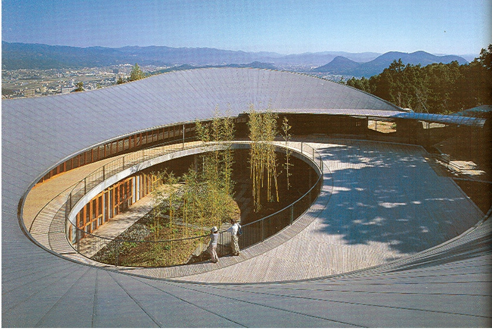
Şekil 5.76Yapının iç bahçesinden görünüş ( Naito, 2001, s.897 ).
