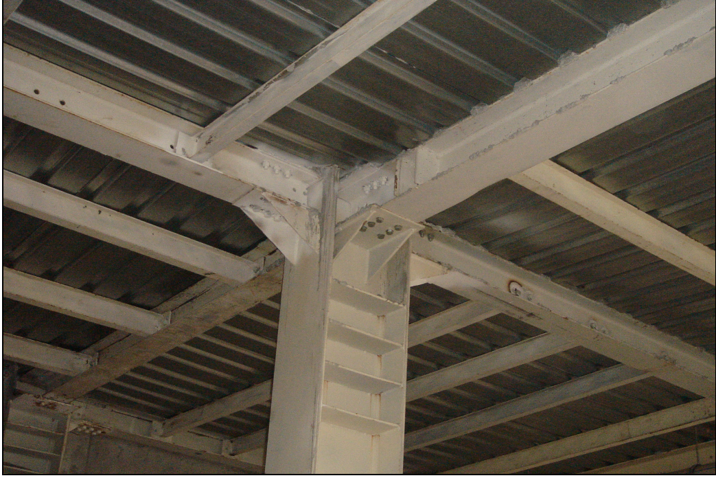
Şekil 4. 17 Kolon, kiriş ve döşeme birleşimi.
