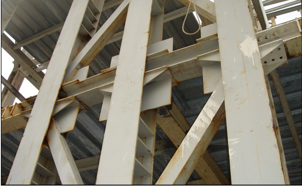
Şekil 4. 13 Cephede perde fonksiyonu gören taşıyıcılar.
