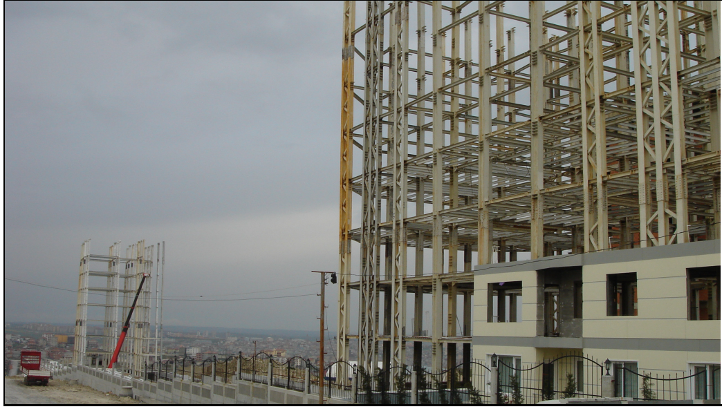
Şekil 4. 2 Projenin yapım aşaması (İstanbul Beylikdüzü, 30/03/2008).
