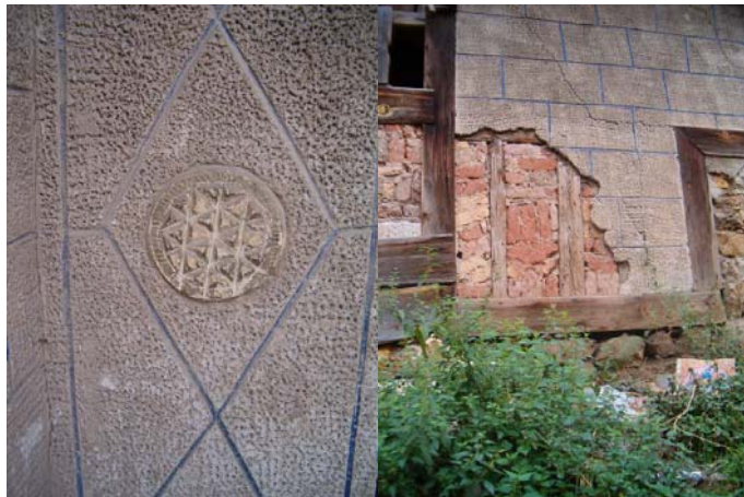
Şekil 4.29 Sıvada görülen süsleme ve kesme taş taklidi sıva
