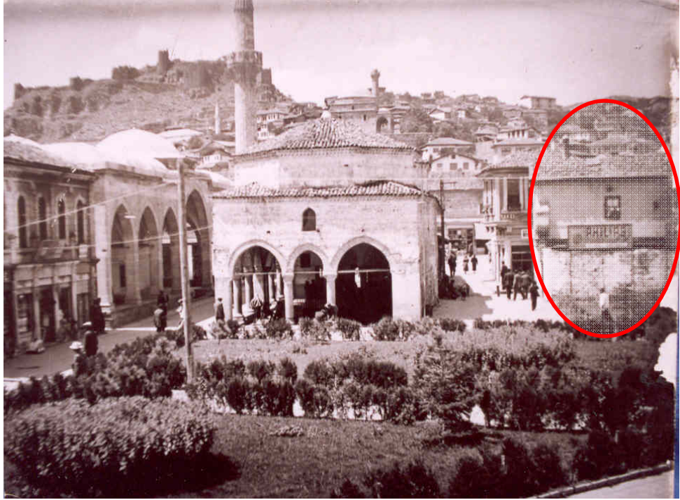
Şekil 2.17 Nasrullah Camisi ve günümüzde yıkılmış olan Dükkanlar (Kaynak: Rıfat Ilgaz Kültür Merkezi Arşivi)
