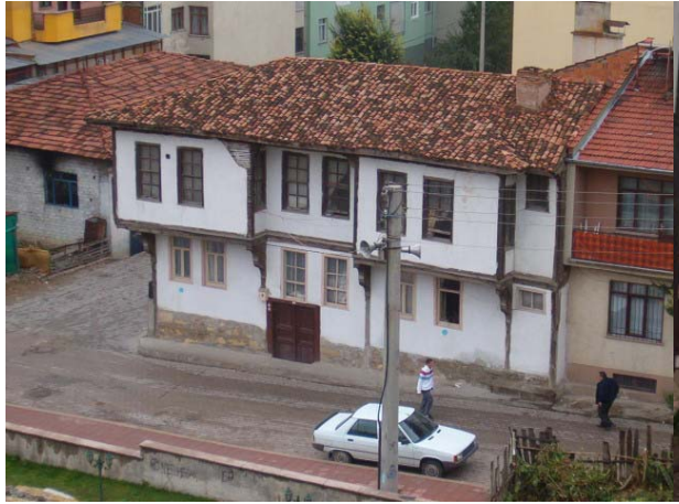
Şekil 4.15 Kırma çatı örneği
