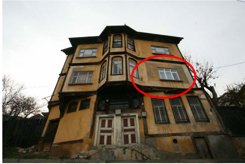
Şekil 5.6 Değiştirilen pencere boşlukları ve doğramaları
