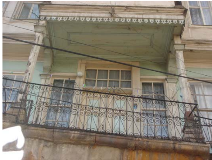
Şekil 4.9 Ahşap ayaklar üzerine oturtulmuş çıkma örneği
