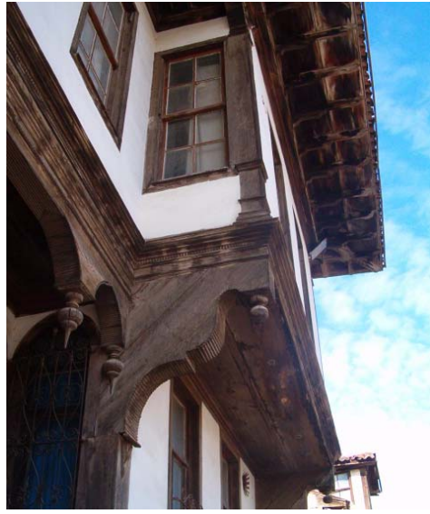
Şekil 4.8 Payanda destekli çıkma örneği
