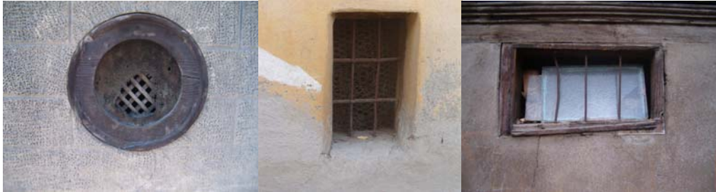
Şekil 4.10 Servis mekanları pencereleri örnekleri
