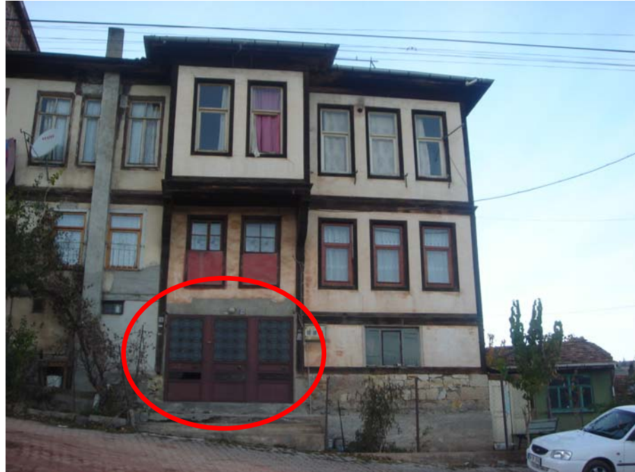
Şekil 5.9 Kapı malzemesinde görülen değişim
