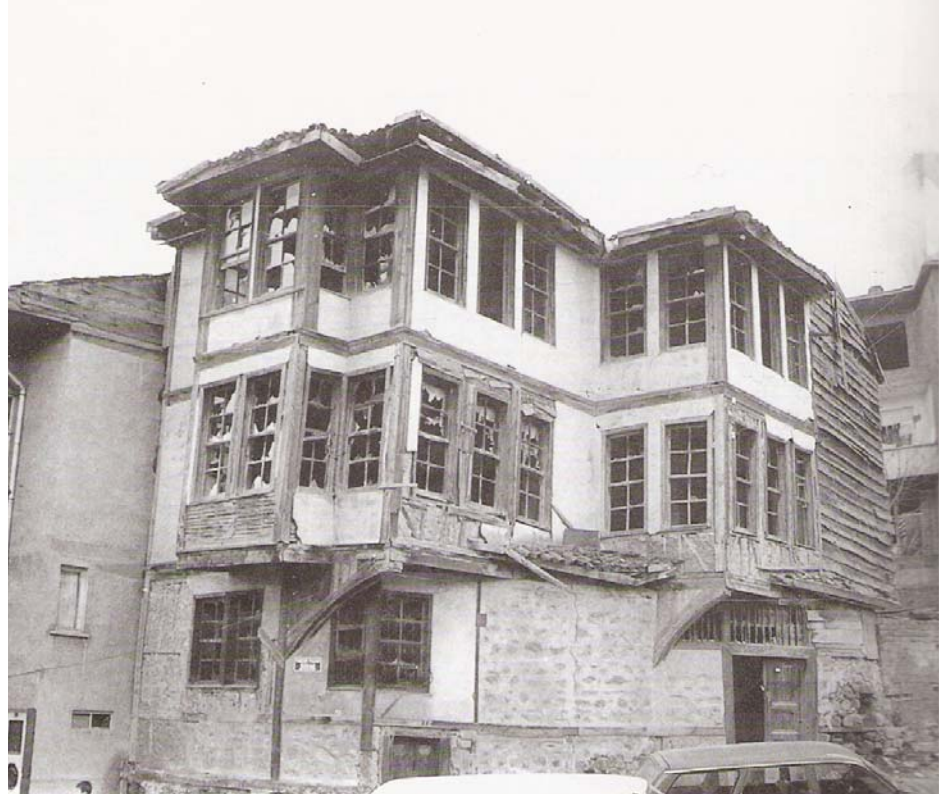
Şekil 5.3 Yapının yıkılıp yerine betonarme benzerinin yapılması (konutun özgün hali)
