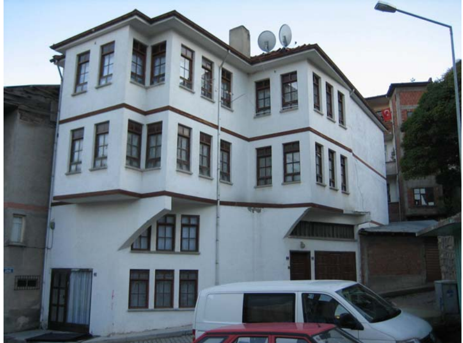
Şekil 5.4 Yapının yıkılıp yerine betonarme benzerinin yapılması (konutun yeni hali)
