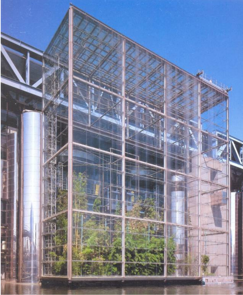
Şekil 2.37 Science Museum cephe görünüşü
