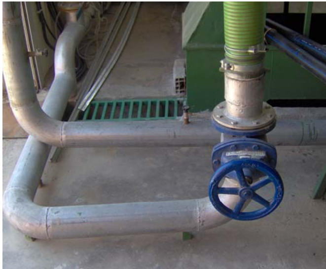
Şekil 3.14 Debiyi değiştirmek için kullanılan vana.
