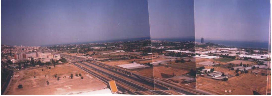
Şekil 3. 2 İnciraltı bölgesinden genel görünüş, (1999) (Kaynak: İzmir 1 Numaralı Kültür ve Tabiat Varlıklarını Koruma Bölge Kurulu Müdürlüğü(KTVKBKM) arşivi)
