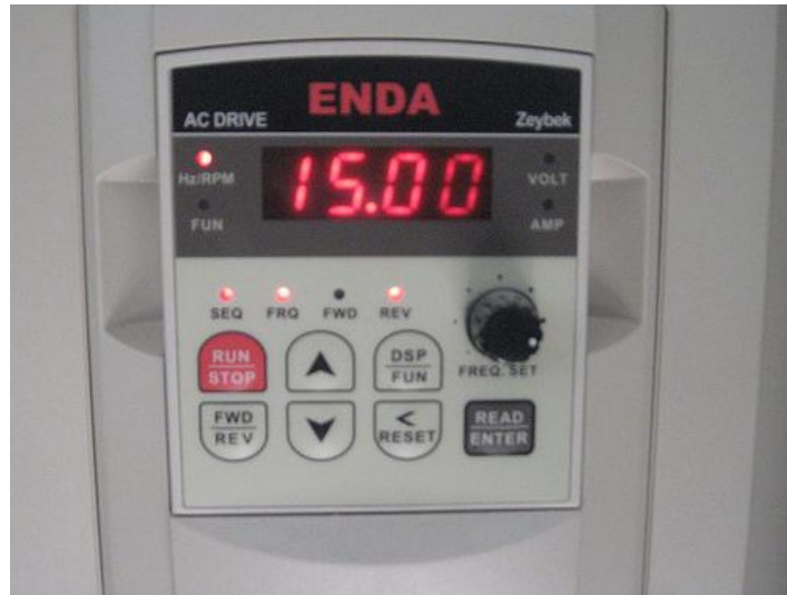
Şekil 4.13 Pompa debisini kontrol cihazı
