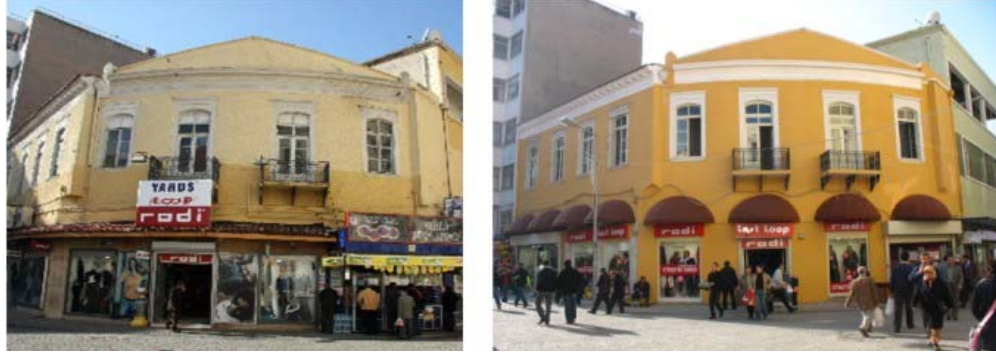
Şekil 3.53 Kemeraltı Yenileme Projesi 1. Etap Çalışmaları kapsamında Ankara Palas (İ.B.B. Tar. Çev. Md.)
