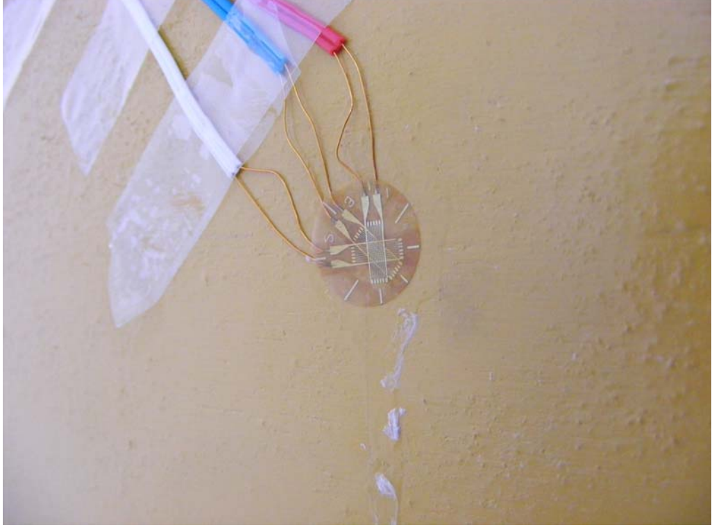
Şekil 6.28 Strain gaugelerin belirlenen noktalara yerleştirilmesi
