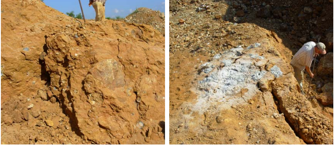
Şekil 1.37 Çatlaticının etkisiyle kayaç içerisinde oluşan genişleme çatlakları.
