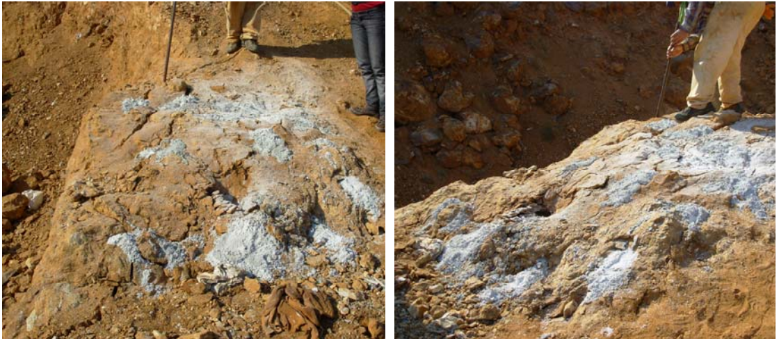
Şekil 1.36 Çatlatıcının deliklere şarjından 12 saat sonra deliklerin durumu.
