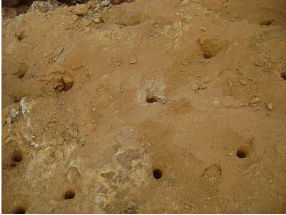
Şekil 1.33 Çatlatıcı malzemenin doldurulacağı 36 mm çapında, 30 ar cm aralıkla delinmiş delikler.
