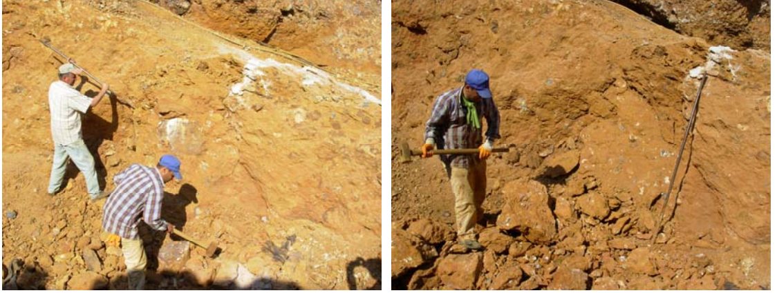
Şekil 1.38 Gevşetilen kayacın levye ve balyoz ile parçalanması.
