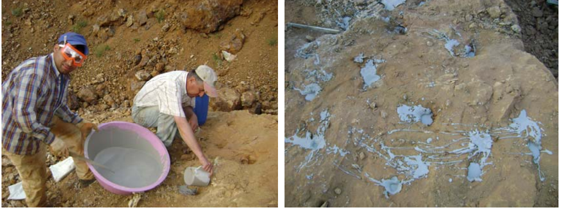
Şekil 1.35 Sulandırılmış çamur kıvamındaki çatlatıcının deliklere şarjı ve doldurulmuş delikler.
