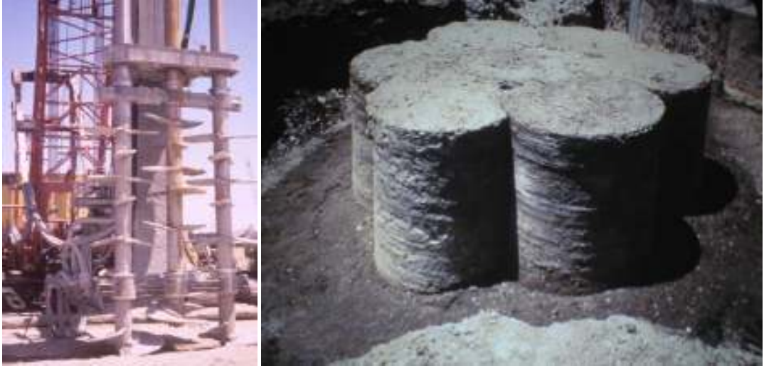
Şekil 2.11 Derin karıştırmada kullanılan delici makineye ve oluşan kolonlara ait birer örnek (Sağlamer, 2006).
