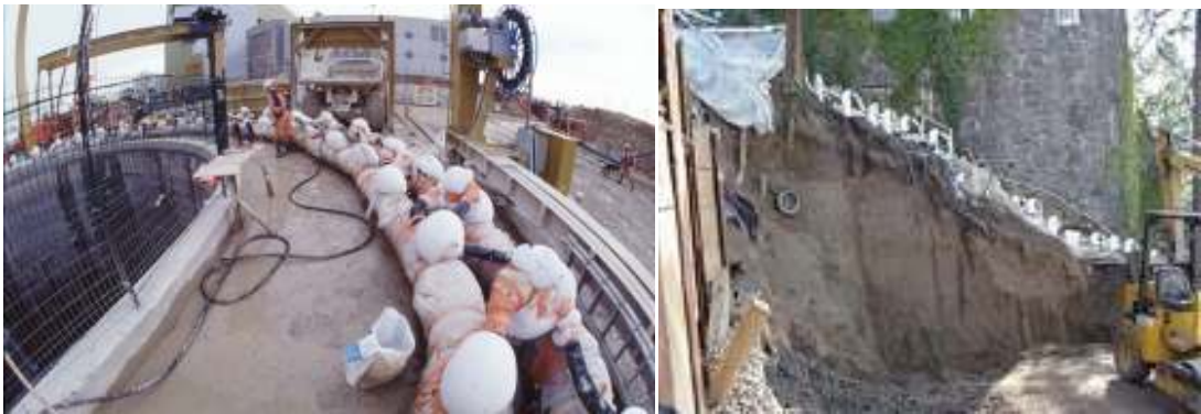
Şekil 2.13 Tünel shaftı ve zorlu bir şevin kontrolünde zeminin dondurulması
