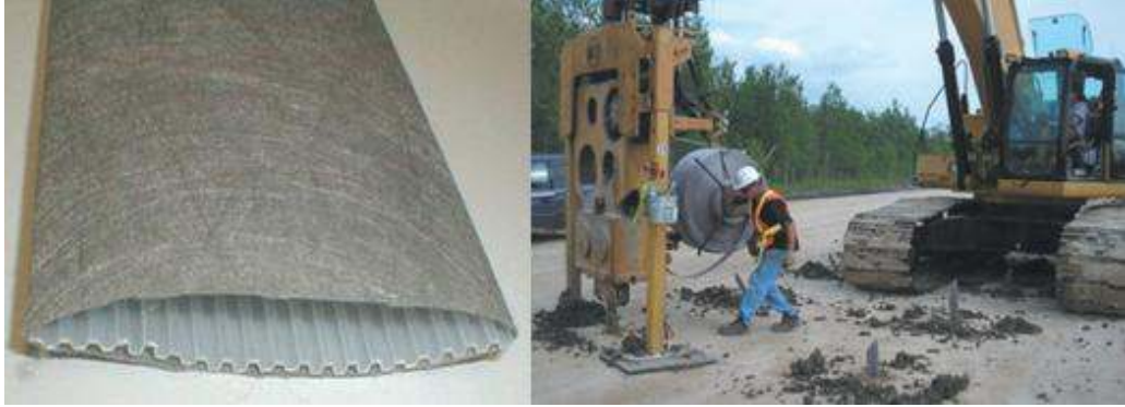
Şekil 2.14 Fitil dren numunesi ve drenin zemine çakılması
