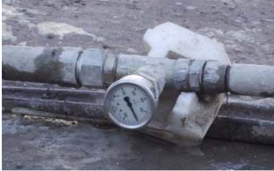
Şekil 3.13 Enjeksiyon hortumuna manometre bağlanması ile enjeksiyon basınç değerinin takibi.
