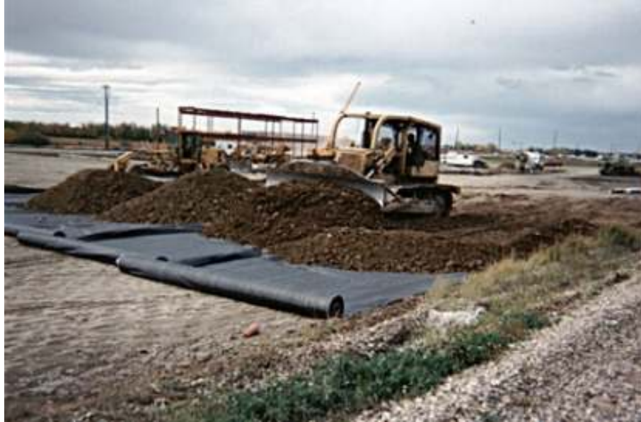
Şekil 2.7 Jeotekstil malzeme ile bir park alanı zemin iyileştirme çalışması ( http://www.baumpub.com/cep/industry/35/layfield_group_limited.html ).
