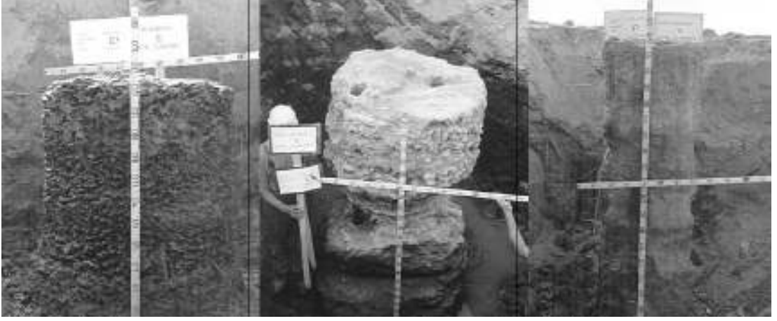
Şekil 2.26 Kolonların etrafının açılmasıyla çeşitli seviyelerde çap kontrolü (Sağlamer, 2006).
