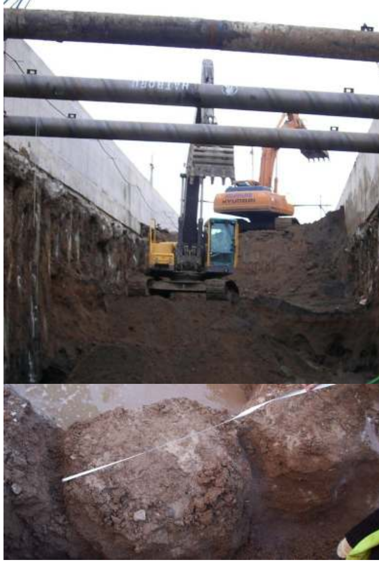
Şekil 3.14 Tünel kazısı sonrası jet-grout kolon çaplarının incelemesi.
