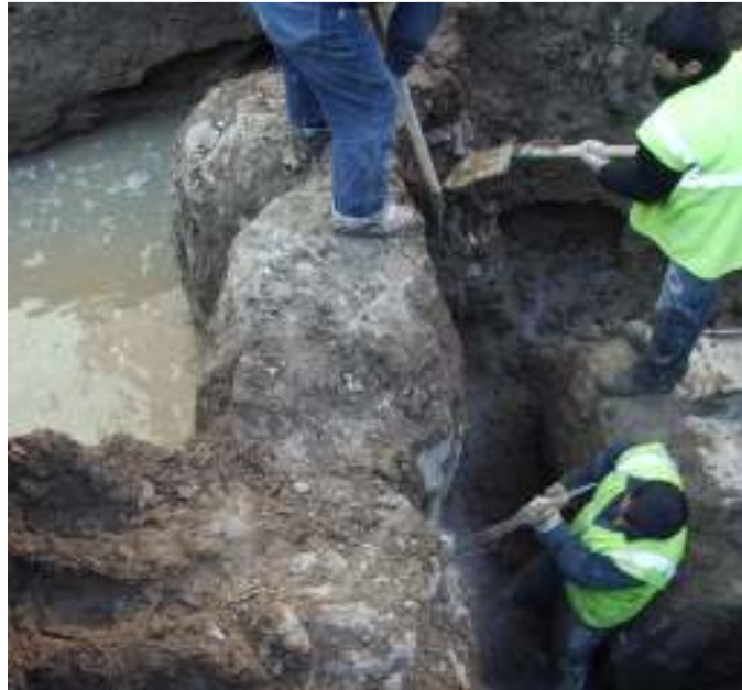
Şekil 3.10 Deney kolonlarının etrafının açılması.
