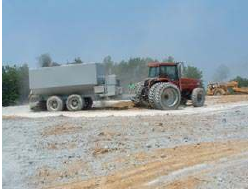
Şekil 2.15 Çimentonun zemine serilmesi
