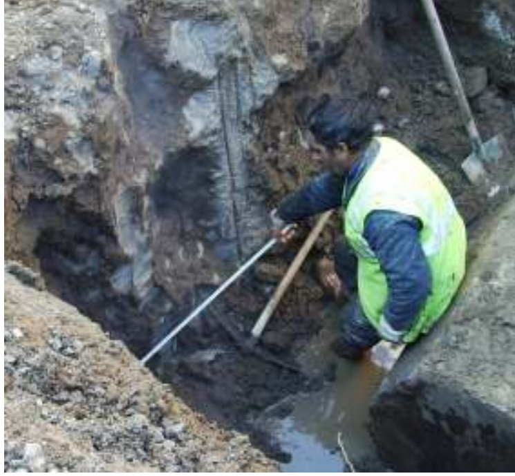
Şekil 3.11 Çeşitli seviyelerden kolon çapı tespiti.
