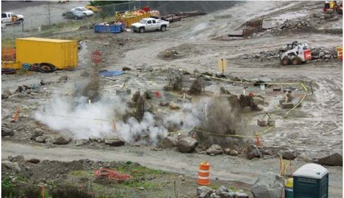
Şekil 2.5 Patlatma ile zemin iyileştirme yöntemine ait bir örnek ( http://www.pacificblasting.com ).
