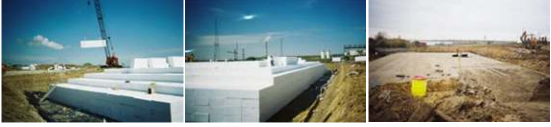
Şekil 2.17 Geoköpük ile ağırlığın azaltılması uygulaması ( http://www.houstonfoam.com/products/geofoam/ ).
