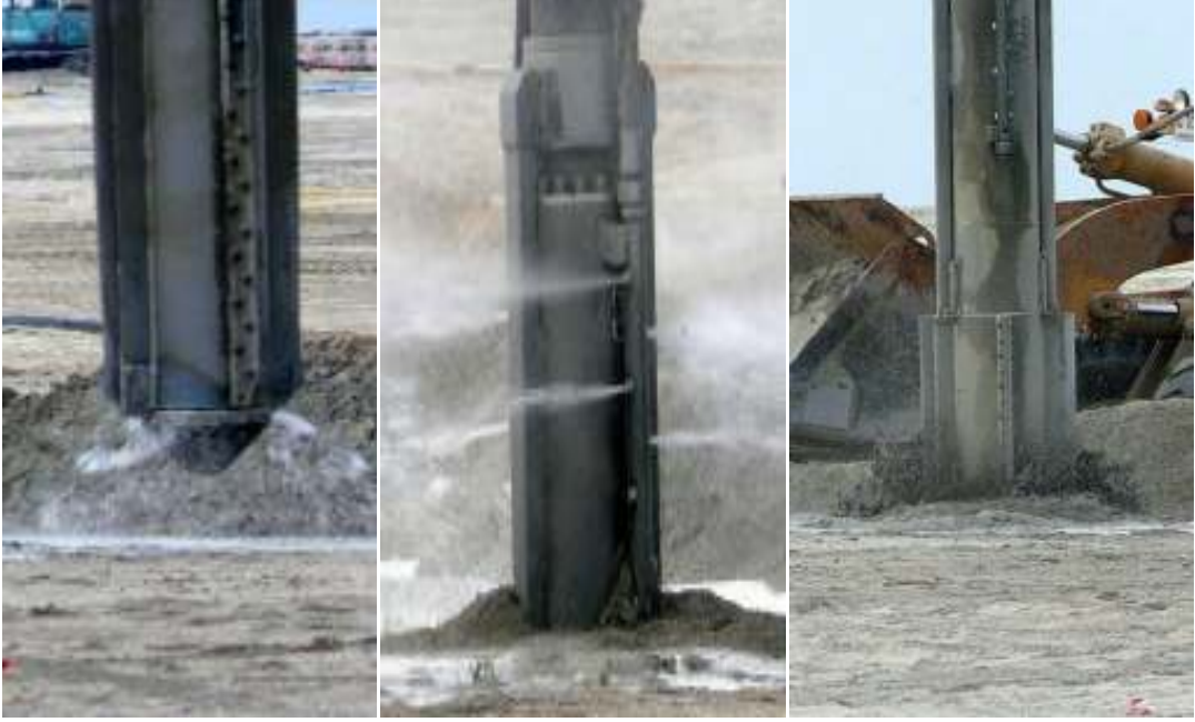
Şekil 2.2 Su jeti yardımıyla vibroflotun zemine giriş aşamaları ( http://forum.skyscraperpage.com/showthread.php?t=107871&page=10 ).
