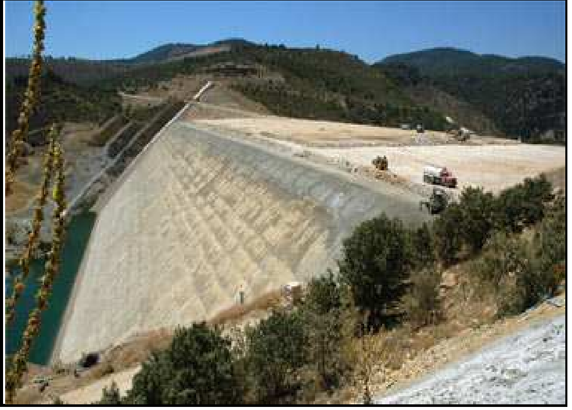
Şekil 2.3 Gördes Barajından bir görünüm.
