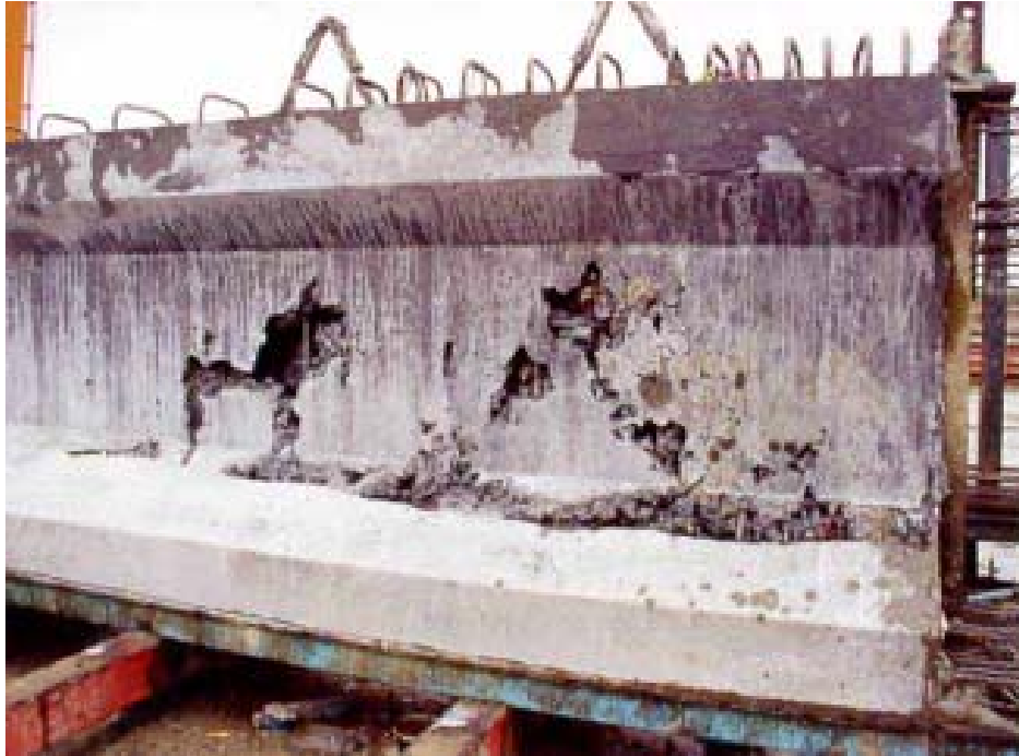
Şekil 1.3 Geleneksel betonda yetersiz vibrasyon.
