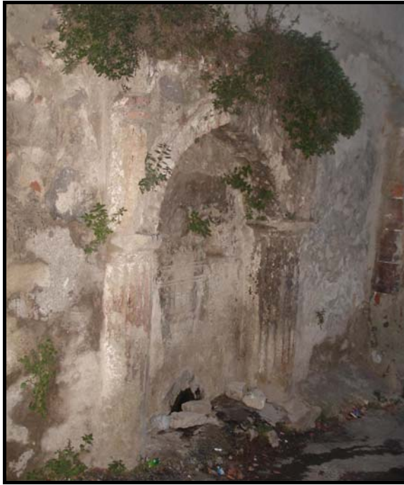
Şekil 5.3 Bitkilenme, tuzlanma ve yüzeyde aşınma (9 no'lu çeşme, 2008)
