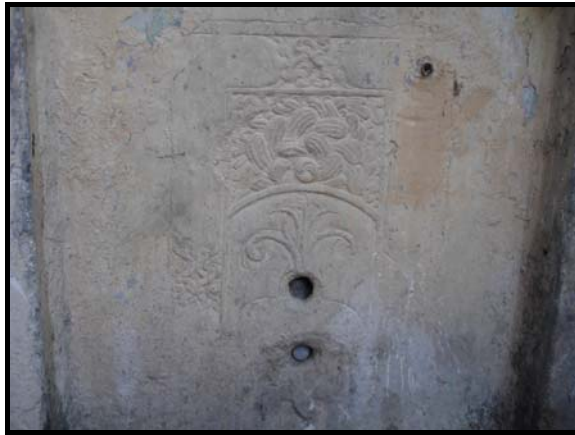
Şekil 5.7 Bezemelerde aşınma (15 no'lu çeşme)
