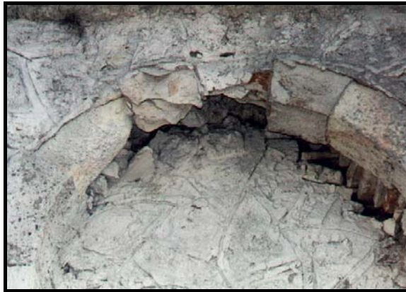
Şekil 5.4 Taşlarda aşınma ve dağılma (12 no'lu çeşme, 2008)
