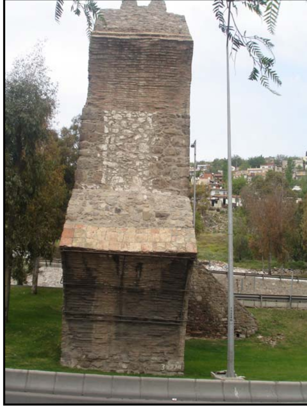
Şekil 3.39 Yeşildere Su Kemerinin kuzey bölümünden detay
