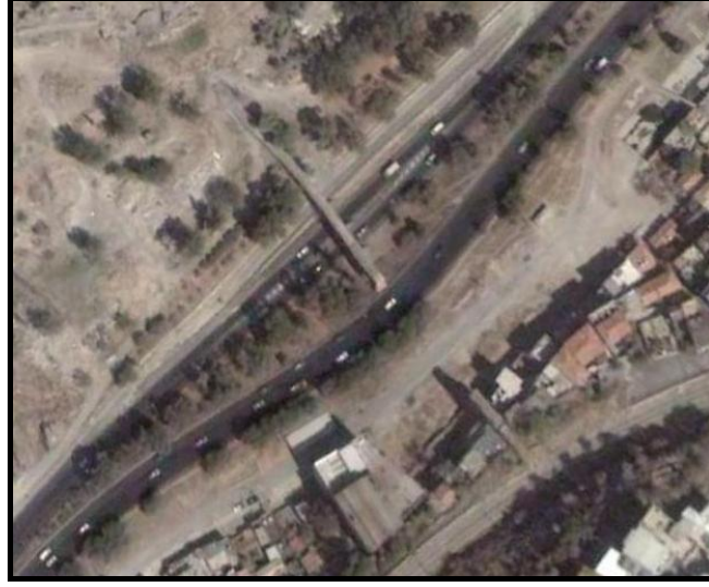
Şekil 3.35 Yeşildere Su Kemerı (Google Earth)
