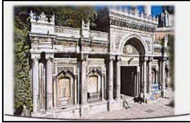
Şekil 2.10 Pertevniyal Valide Sultan Çeşmesi
