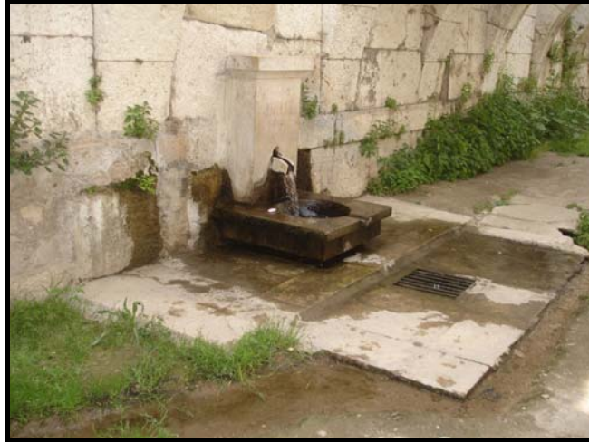
Şekil 3.41 Agora Batı Stoa, Restorasyon kapsamında su kaynağına yapılan çeşme.
