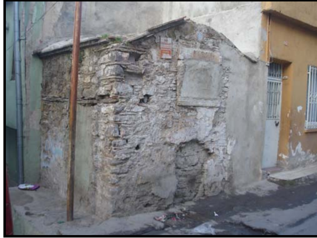
Şekil 5.16 Kapatılan açıklıklar ve çimento katkılı sıva uygulaması (13 no'lu çeşme)
