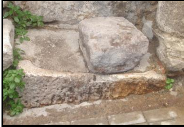
Şekil 5.14 Yalağın beton ile doldurulması (4 no'lu çeşme).
