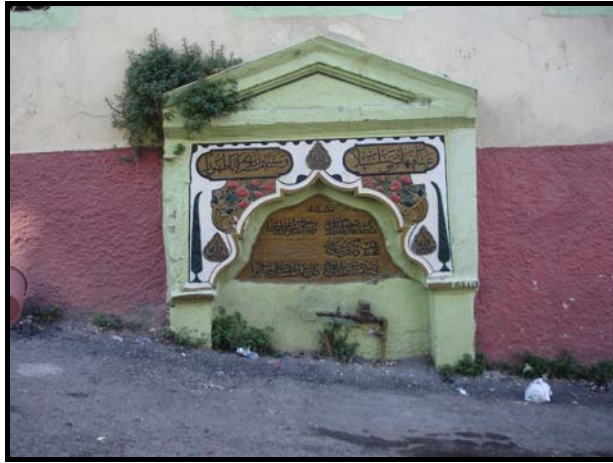
Şekil 5.15 Yol kot'unun yükseltilmesi (32 no'lu Toraman Cami Çeşmesi)
