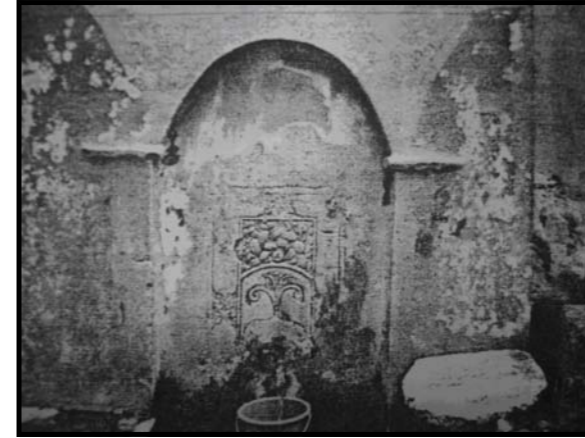
ESKİ DURUMU (ERENLER, 1993)
