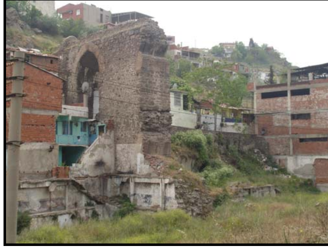
Şekil 3.38 Yeşildere Su Kemerinin güney bölümü.
