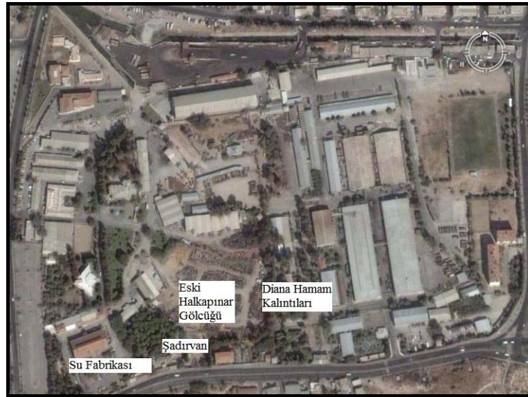
Şekil 3.42 Halkapınar su yapıları (Google Earth).
