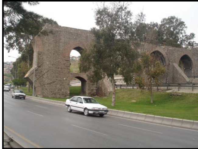
Şekil 3.37 Yeşildere Su Kemerı'nın kuzey bölümü
