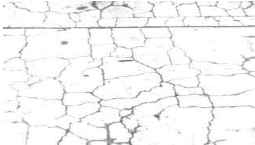
Şekil 2.6 Kanada'da, ACR'nin kaldırım döşemesine etkisi ( http://www.tfhr.gov/pavement/pccp/petro/chaptr10.htm , 2006).
