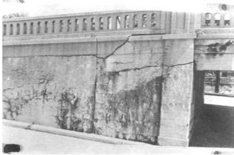
Şekil 2.7 New Jersey’de, ASR’nin ve ACR’nin birarada görülmesi ( http://www.tfrc.gov/pavement/pccp/petro/chaptr10.htm , 2006).
