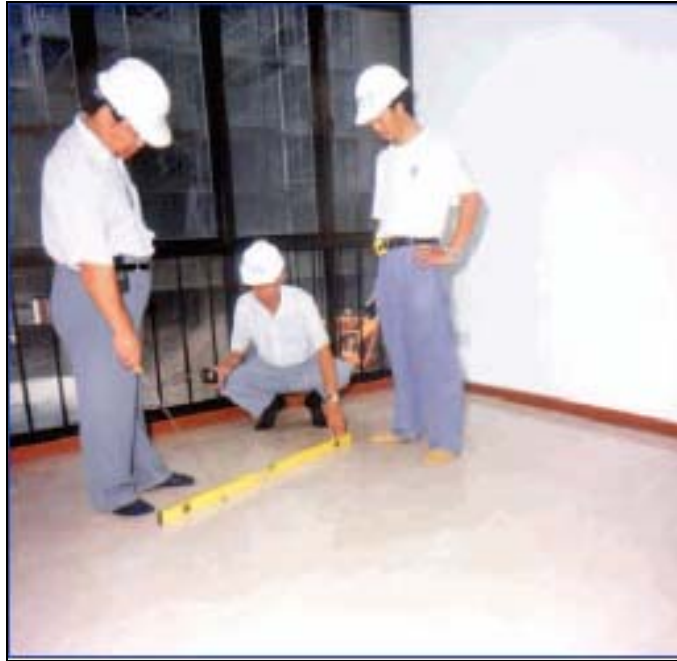
Şekil 5.23 Ebatlı doğal taşların montajı
