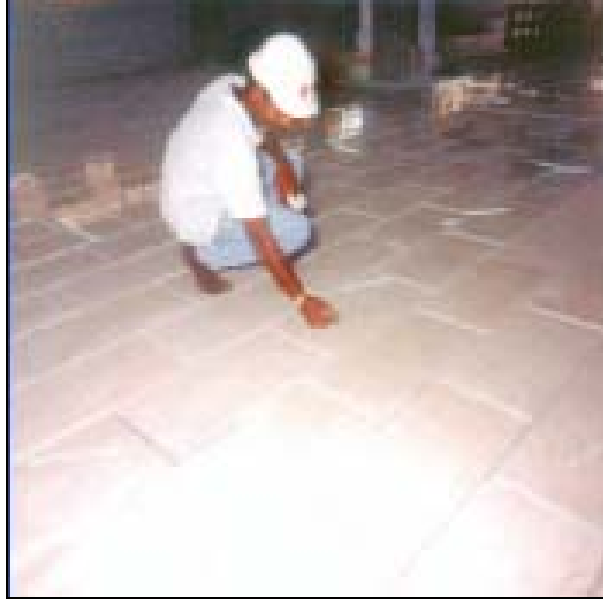
Şekil 5.22 Ebatlı doğal taşların asıl uygulama yerinde kontrol uygulaması
