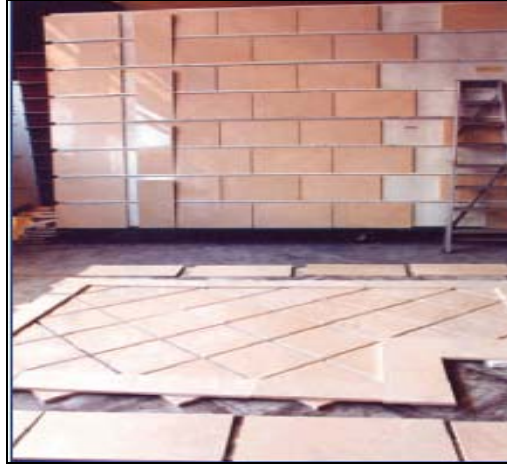
Şekil 5.20 Fabrikada model olarak uygulanan duvar kaplaması ve zemin döşemesi
