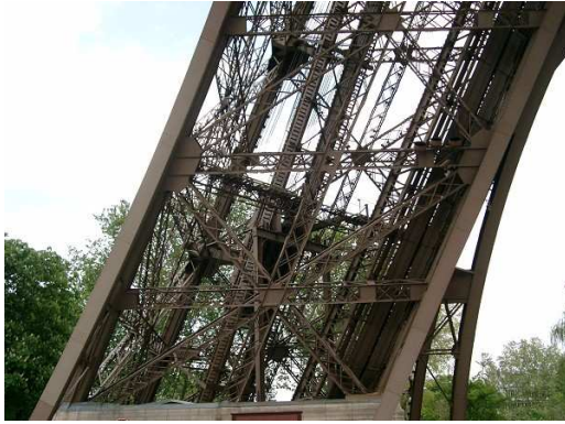
Şekil3.32 Eiffel Kulesi'nin ayakları http://en.structurae.de/photos/index
