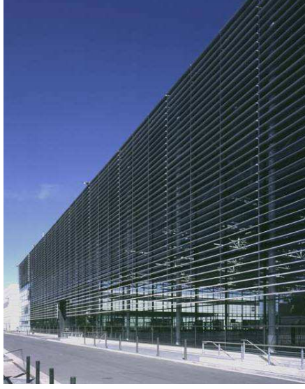
Şekil 3.61 Messe Hall 13 güney cephesindeki güneş kırıcılar
