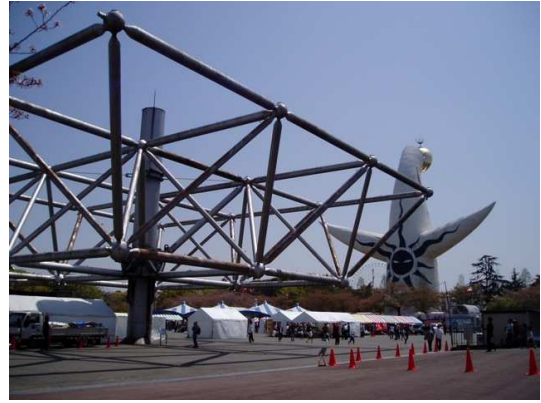
Şekil 3.44 Festival Plaza örtüsünün kolanlar üzerinde kaydırılarak yükseltilmesi Clinton, J. Space Grid Structures, 2000, sf.62
