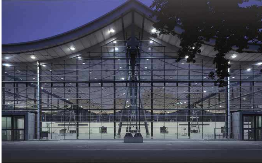
Şekil 3.57 Messe Hall 8/9 görünüşü
