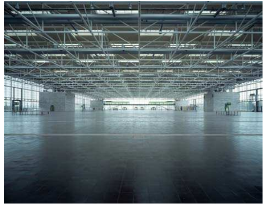
Şekil 3.60 Messe Hall 13 iç görünüş
