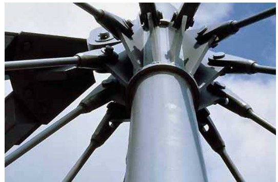
Şekil 3.88 Tagungs Center Kabloların Ana Taşıyıcıya Bağlantı Detayı
