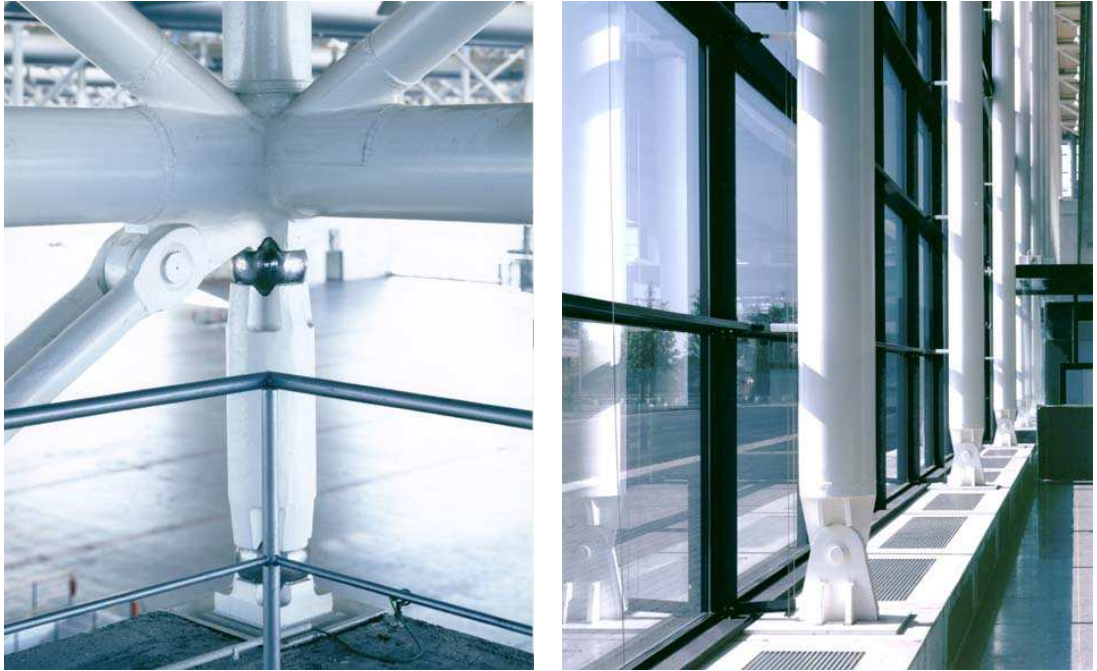
Şekil 3.62 Messe Hall 13 kolon bağlanma detayları
