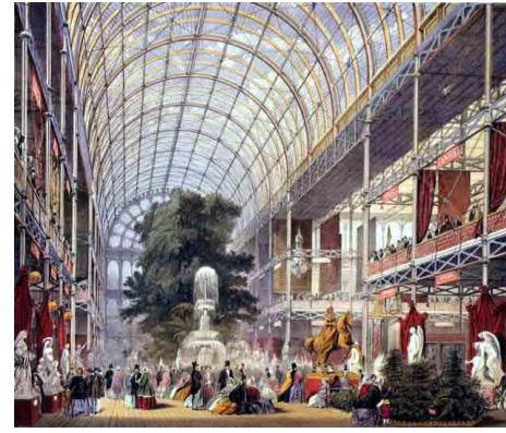
Şekil 3.9 Crystal Palace iç görünüm
