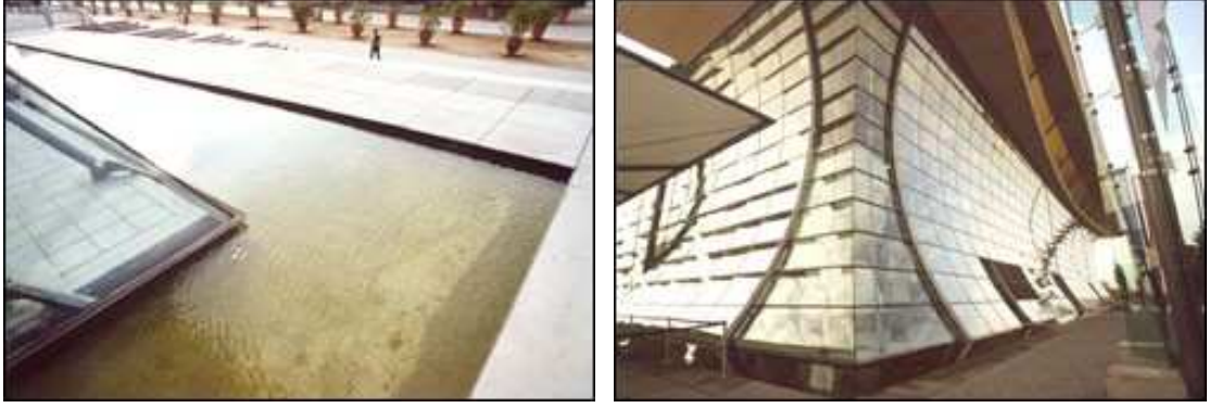
Şekil 3.76 Pavyonun çevresindeki su kanalı
