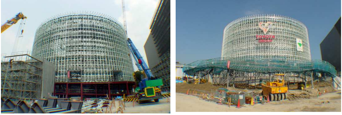
Şekil 3.90 Yapım Aşamasından Görüntüler – Çelik karkas taşıyıcı sistem
