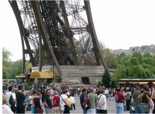
Şekil3.33 Eiffel Kulesi'nin ayakları http://en.structurae.de/photos/index
