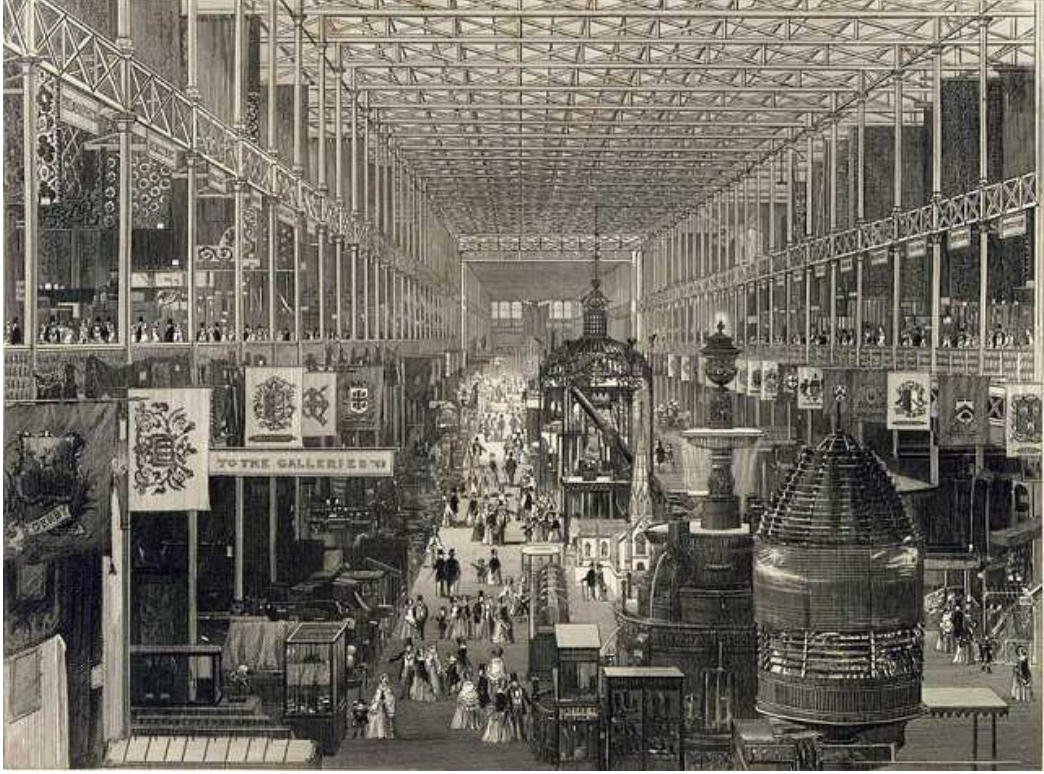
Şekil 3.10 Crystal Palace iç görünüm
