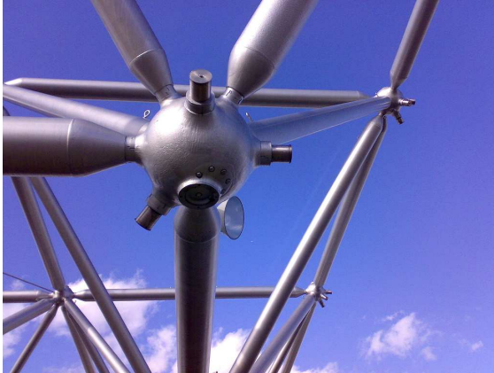
Şekil 3.45 Festival Plaza düğüm noktası detayı http://www.flickr.com/photos/yancunyang/420062111/sizes/l/
