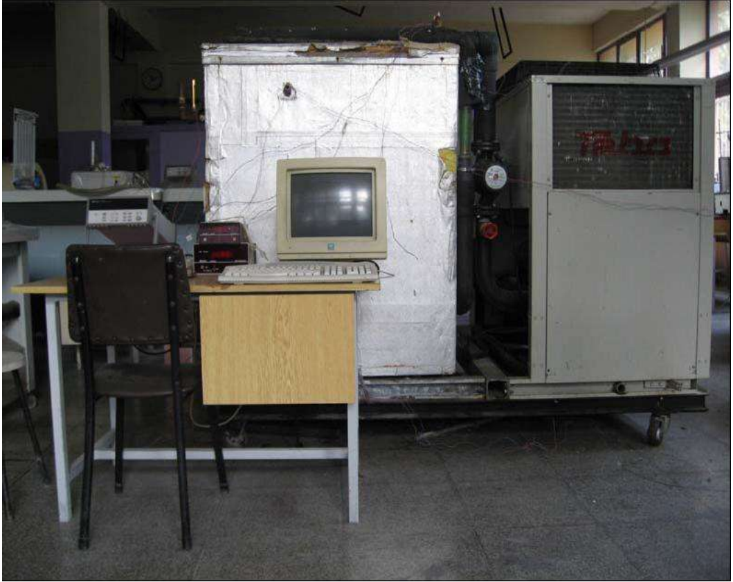
Şekil 3.1 Soğutma grubu ve entegre buz deposu
