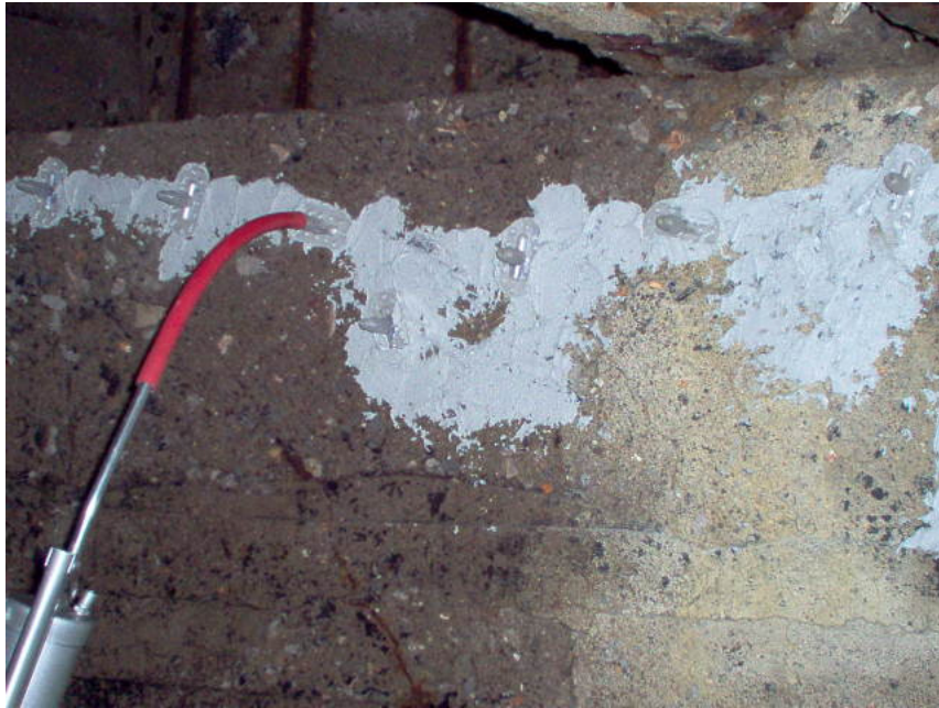
Şekil 5.6 Enjeksiyon uygulama örneği
