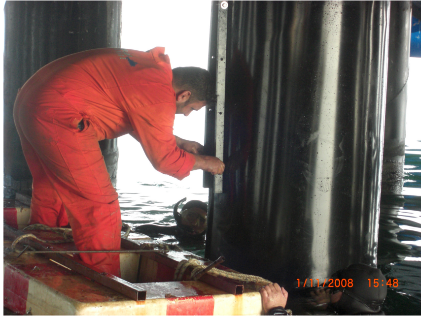
Şekil 5.5 Kaplama uygulama örneği 2.aşama
