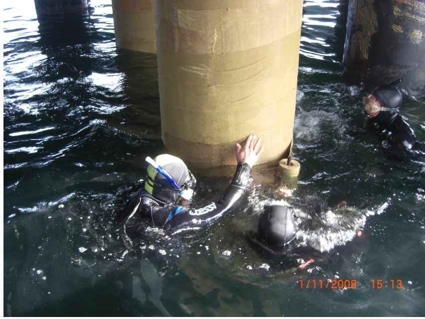
Şekil 5.4 Kaplama uygulama örneği 1. aşama
