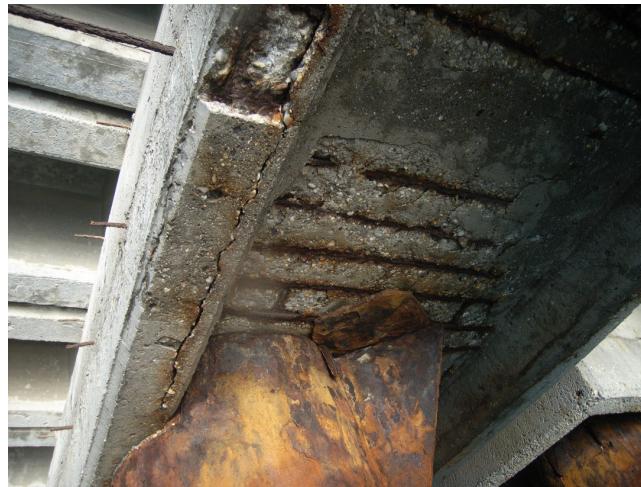
Şekil 5.12 Başlık içine düzgün oturmeyen kazık örneği
