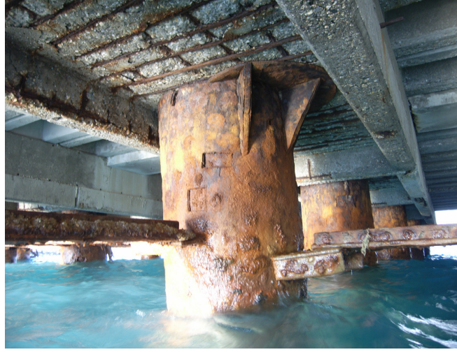
Şekil 5.13 Başlık içine düzgün oturmeyen ve donatı yerleşimi şüpheli olan kazık örneği
