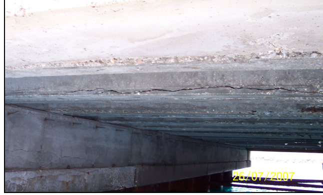
Şekil 5.11 Döşeme altı betonarme prekast elemanlar
