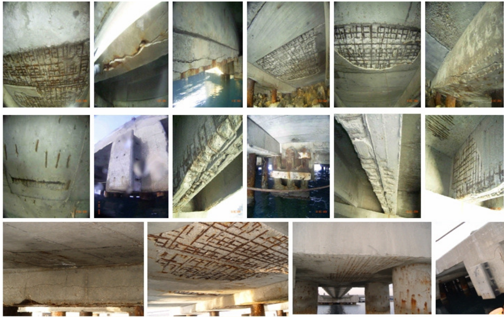
Şekil 5.3 Betonarme korozyon
