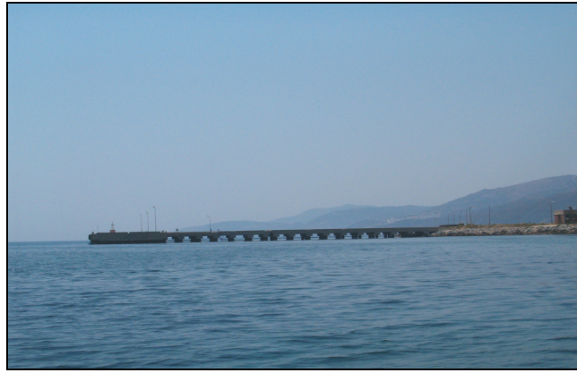
Şekil 5.8 Kemerköy ağır yük iskelesi genel görünümü
