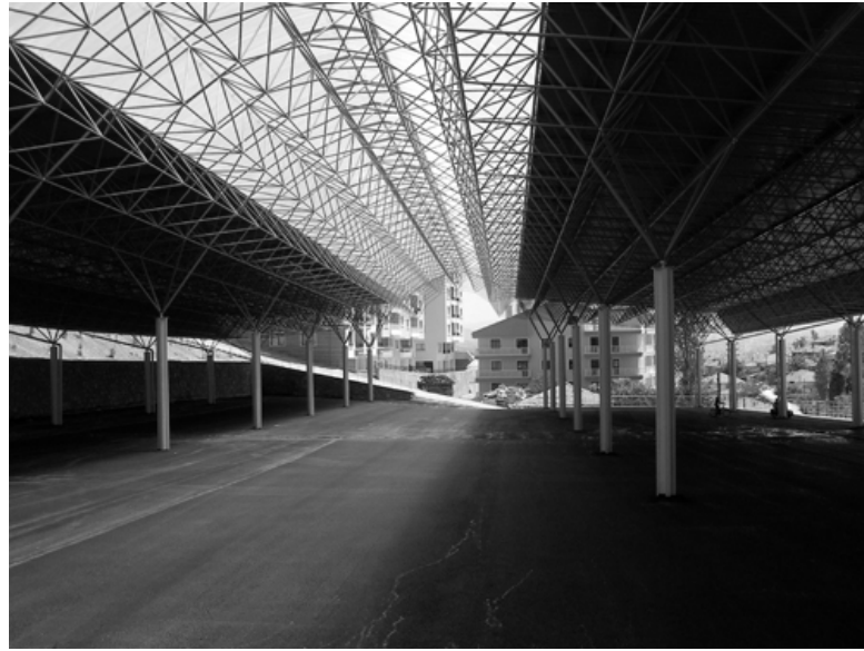
Şekil 2.6 Tek eğrilikli çelik uzay kafes (www.sanayiden.com).
