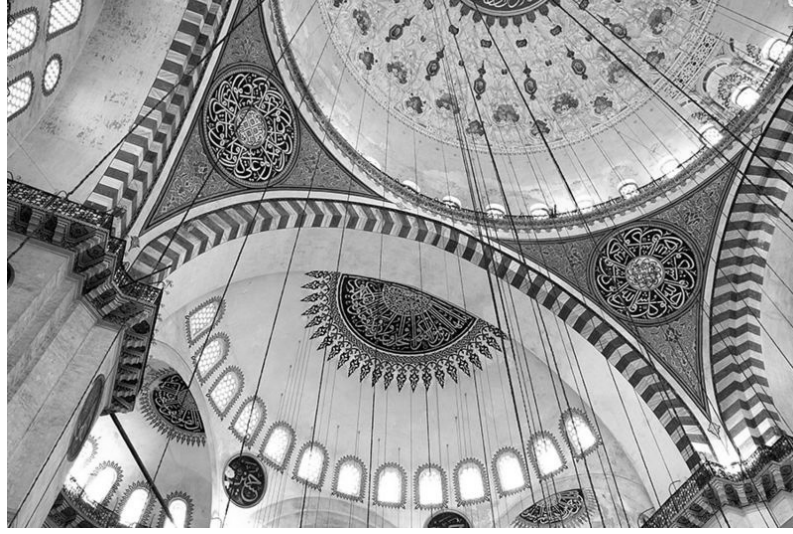
Şekil 1.3 Süleymaniye Camii fil ayağı destekli kubbeler
