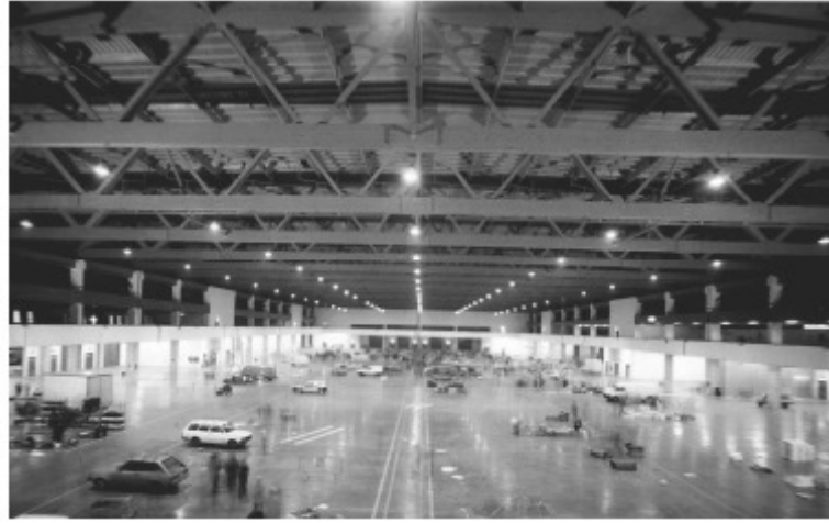
Şekil 2.12 Tutkallı Tabakalı Ahşap Düzlem Kafes Kiriş Örneği
