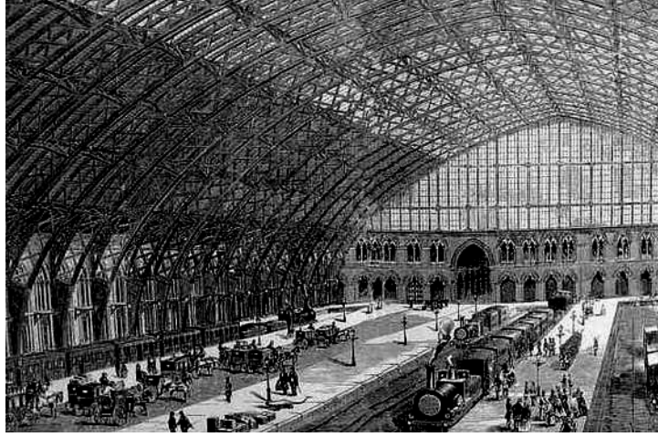
Şekil 1.4 St. Pancras Tren İstasyonu, Londra (Elliott, 1992).
