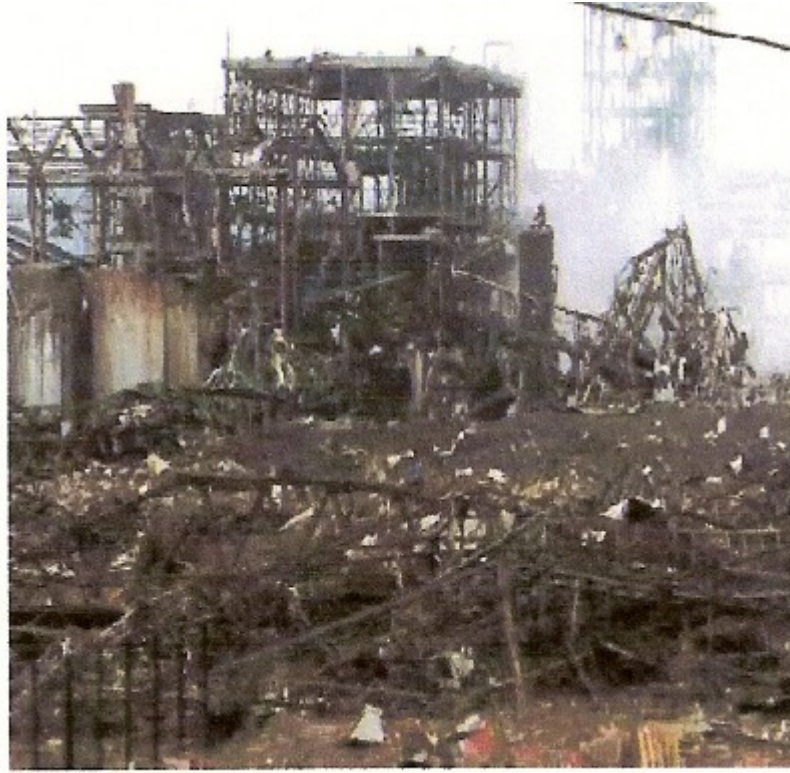
Şekil 1.39 Elektrostatik yüklenme sonucu yanmış bir toz toplama ünitesi
