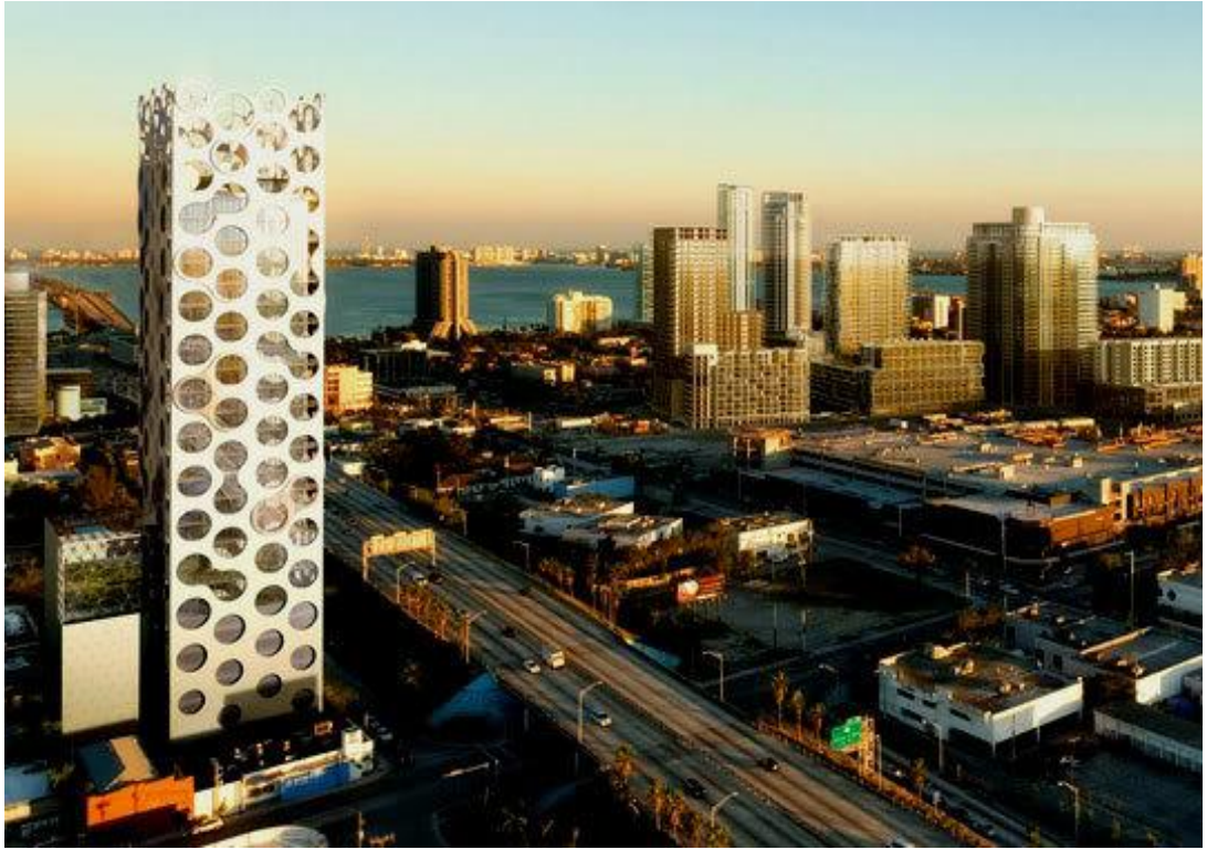
Şekil 3.45 COR Binası genel görünümü
