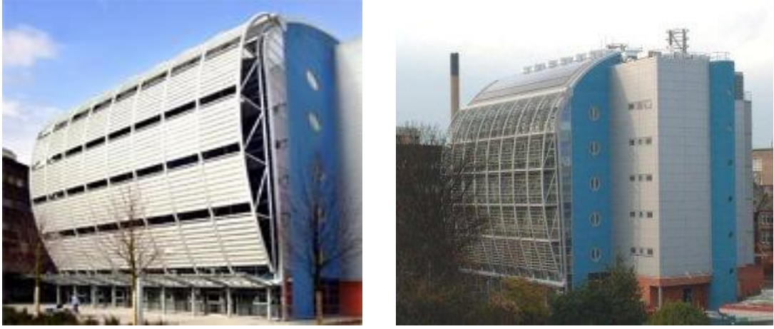
Şekil 3.24 Devonshire Binasının güney cephesinde yer alan akıllı cephe sistemindeki güneş panellerinin kapalı ve açık durumdaki görüntüleri ( http://www.pmg.ie/images/casestudies/mainpics_portrait/devonshire_sq.jpg )
