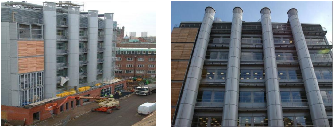
Şekil 3.27 Devonshire Binasının kuzey cephesinde yer alan yağmur suyu toplama sistemi ( http://www.greenspec.co.uk/html/imagebank/devonshire.html )
