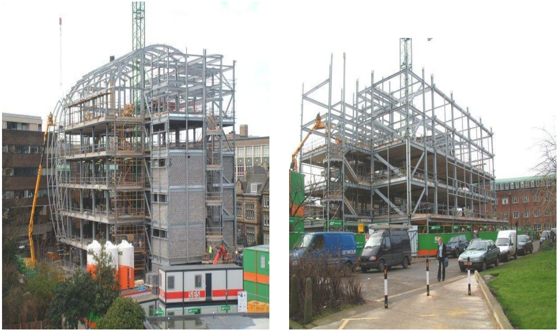
Şekil 3.21 Devonshire Binasının yapım tekniğiyle yapım aşaması ( http://www.levolux.com/L_products/brise_soleil_details.htm ).
