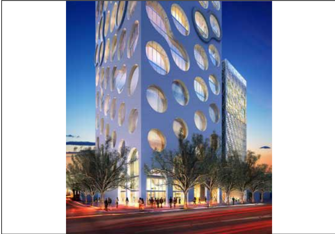
Şekil 3.46 COR Binası genel zemin katında yer alan restoran ve ticaret gibi sosyal mekanlar ( http://www.openoffice.com/ )
