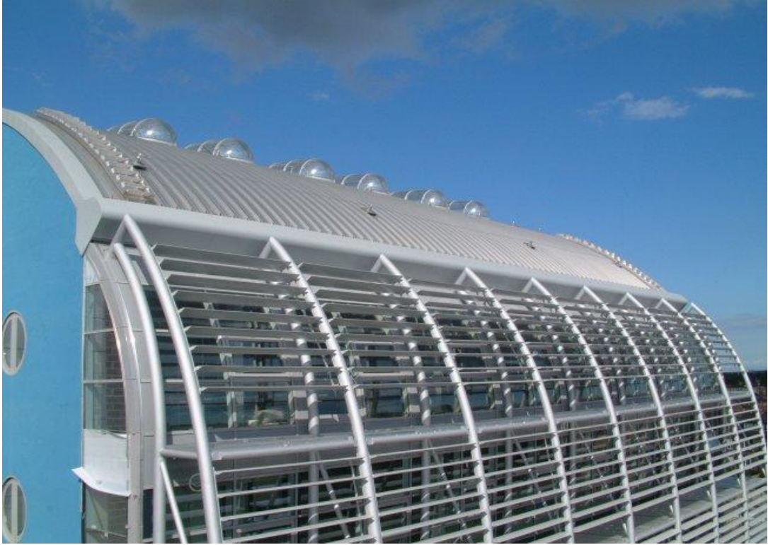
Şekil 3.23 Devonshire Binasının güney cephesindeki akıllı cephe sistemi ( http://www.5reb.net/Technology/Solar-Building/solar001.jpg )
