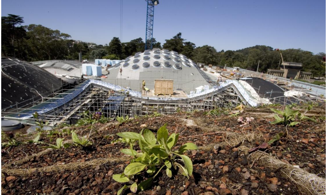
Şekil 3.40 Kaliforniya bilim müzesinin “yeşil çatı” sının yapım aşaması ( http://www.architectureweek.com/cgi-bin/awimage?dir=2008/1112&article=environment_1-3.html&image=14065_image_3.jpg )
