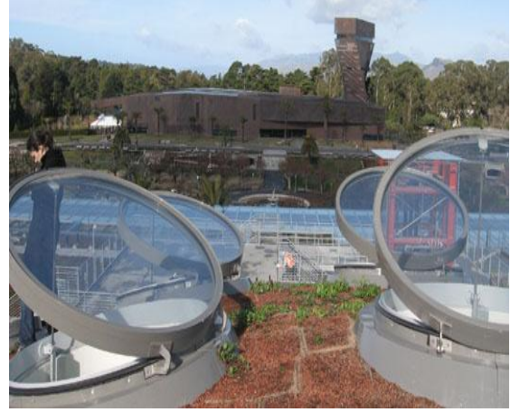
Şekil 3.43 Kaliforniya bilim müzesinin çatısında yer alan havalandırma kapakları ( http://www.metropolismag.com/story/20080917/green-architectures-grand-experiment-part-1-the-building )
