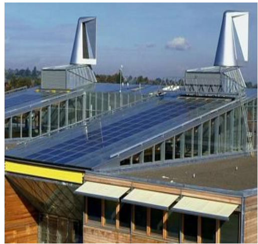
Şekil 3.5 Solar Office Doxford International binasında fotovoltaik pil kullanımı (solda) - Nottingham Üniversitesi Jubilee Kampüsü binasında fotovoltaik pil kullanımı (sağda)
