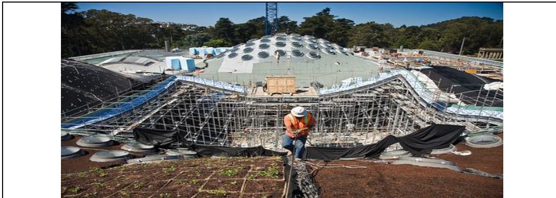
Şekil 3.39 Kaliforniya bilim müzesinin "yeşil çatı" sının yapım aşamasından görünüm ( http://content.techrepublic.com.com/2347-22_11-61706-61707.html?seq=1 )
