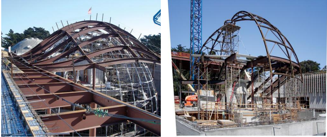
Şekil 3.36 Kaliforniya bilim müzesinin taşıyıcı sisteminden görünüm ( http://www.metropolismag.com/story/20080917/part-3-the-engineering )
