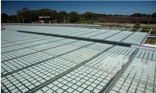
Şekil 3.44 Kaliforniya bilim müzesinin çatı saçağında yer alan PV hücreler ( http://www.metropolismag.com/story/20080917/green-architectures-grand-experiment-part-1-the-building )
