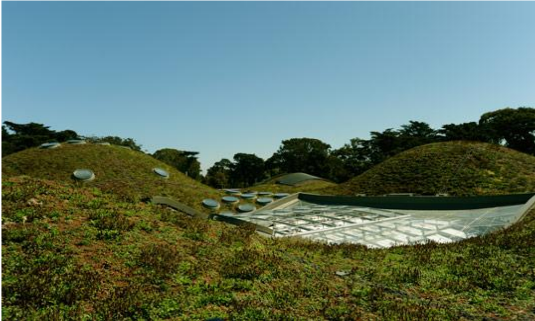
Şekil 3.42 Kaliforniya bilim müzesinin "yeşil çatı" sının yapım aşaması
