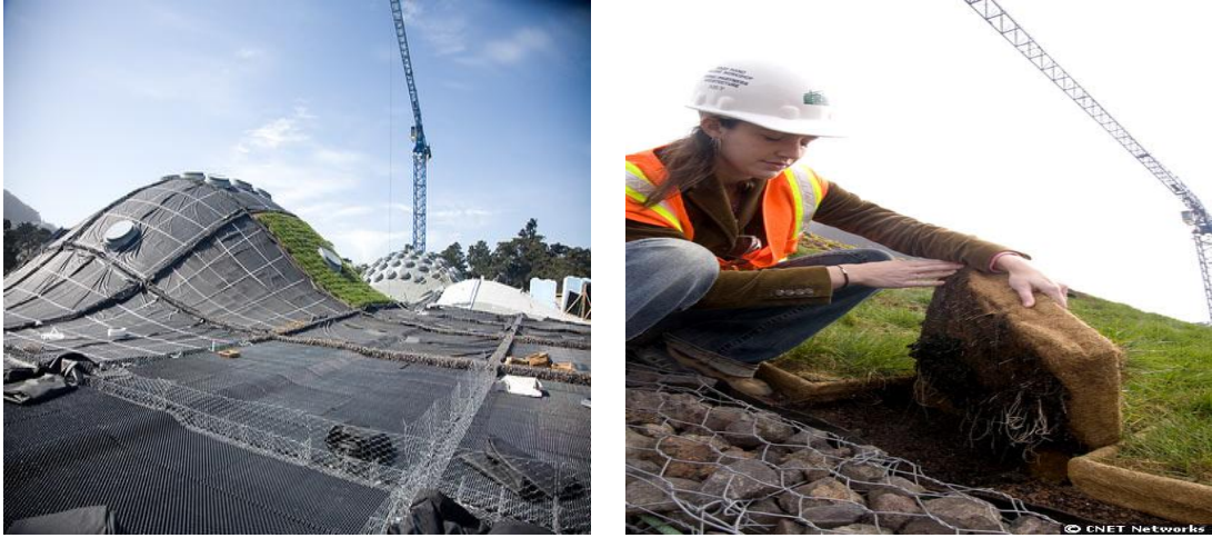
Şekil 3.41 Kaliforniya bilim müzesinin "yeşil çatı" sının yapım aşaması
