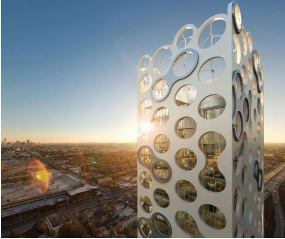
Şekil 3.47 COR Binası yüksek performanslı dış kabuğu ( http://dcnonl.com/article/20061211100 )
