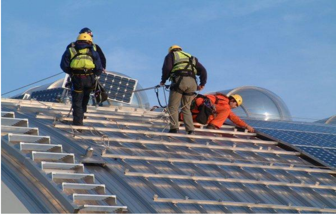
Şekil 3.25 Devonshire Binasının güney cephesinde yer alan ve yapının enerji ihtiyacının bir kısmının karşılandığı fotovoltaik hücreler ( http://www.greenspec.co.uk/html/imagebank/devonshire.html )
