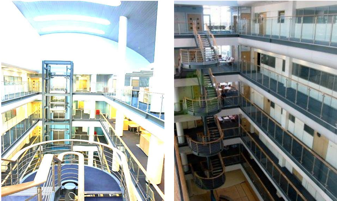
Şekil 3.22 Devonshire Binasının merkezinde yer alan büyük atrium doğal havalandırma ve aydınlatmanın sağlanmasında önemli rol oynamaktadır ( http://www.greenspec.co.uk/html/imagebank/devonshire.html )
