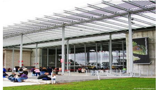
Şekil 3.44 Kaliforniya bilim müzesinin çatı saçağında yer alan PV hücreler ( http://www.metropolismag.com/story/20080917/green-architectures-grand-experiment-part-1-the-building )
