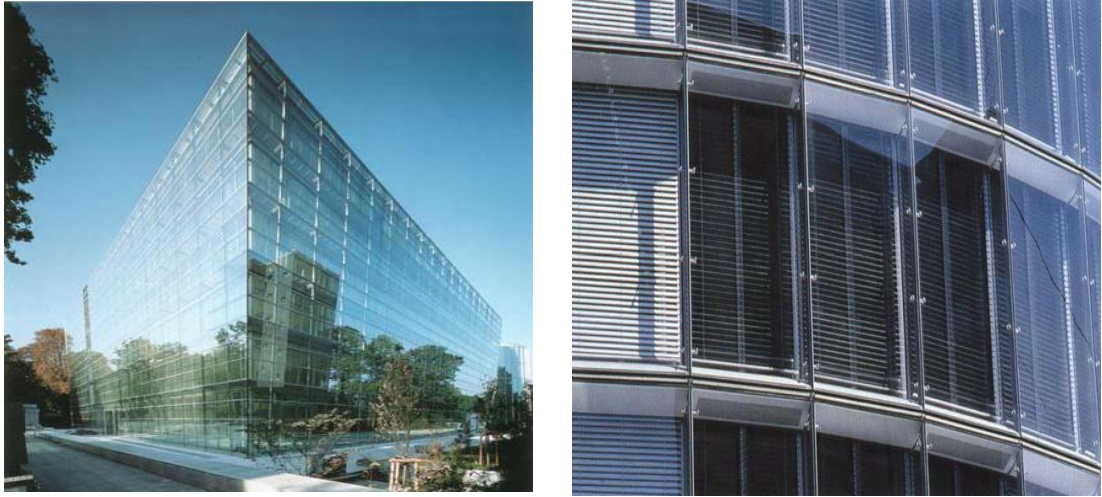
Şekil 3.6 Çift kabuklu cephe sisteminin uygulandığı Victoria Ensemble binası (solda) ( http://gaia.lbl.gov/hpbf/picture/thumbnail/t_victoria.jpg ) ve RWE Binası (sağda)
