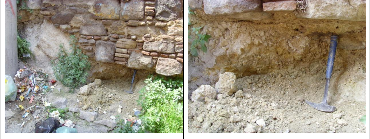
Şekil 4.7 Agora Güneyinden (Kadifekale sırtları) Alınan Kil Örneğinin Görünümü.
