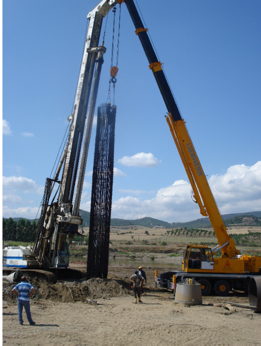
Şekil 6.8 Fore kazık demir donatının kuyu içerisine yerleştirilmesi
