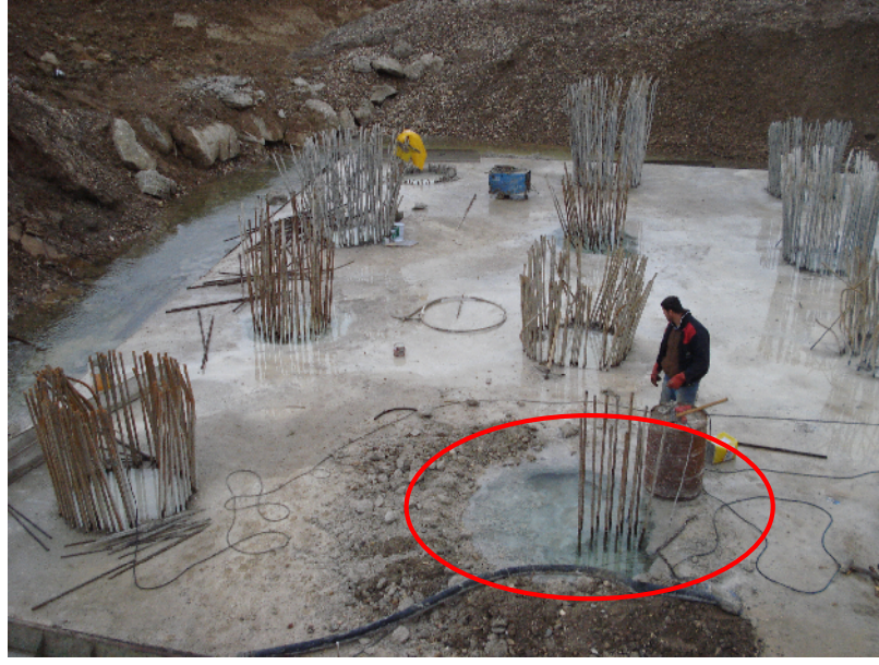
Şekil 8.6 Filiz ekimi gerçekleştirilen kazığa epoxy uygulanmaktadır.
