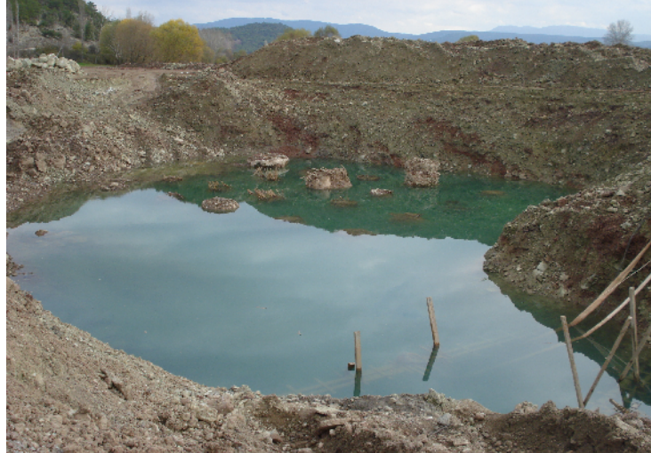
Şekil 8.1 Bir ekskavatör yardımı ile kazık imalatı yapılan aks açılarak imal edilen fore kazıklar ortaya çıkartılmıştır.
