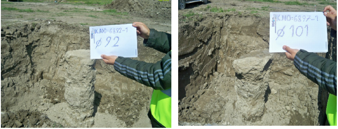
Şekil 7.1 Pamukova bölgesinde yapılan test kolonlarının 7 gün sonra açılması
