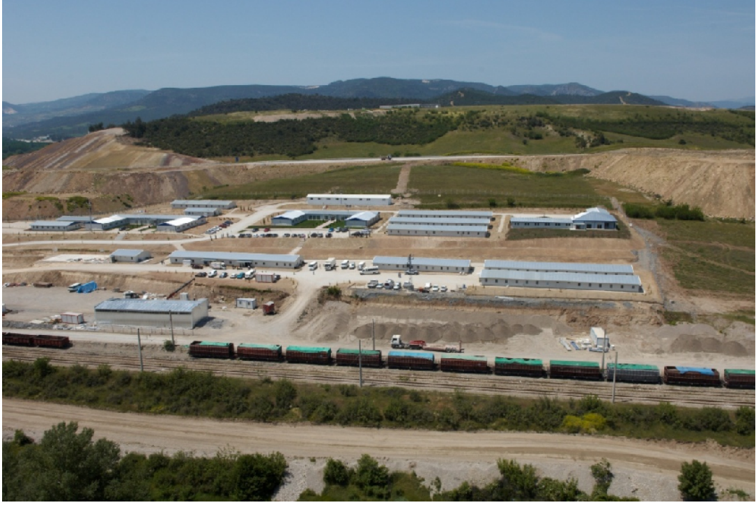
Şekil 1.2 Kesim-1 Osmaneli şantiyesi kamp alanı görünümü
