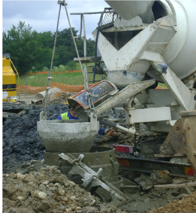
Şekil 6.9 Fore kazıklarda Tremie borusu ile beton dökülmesi
