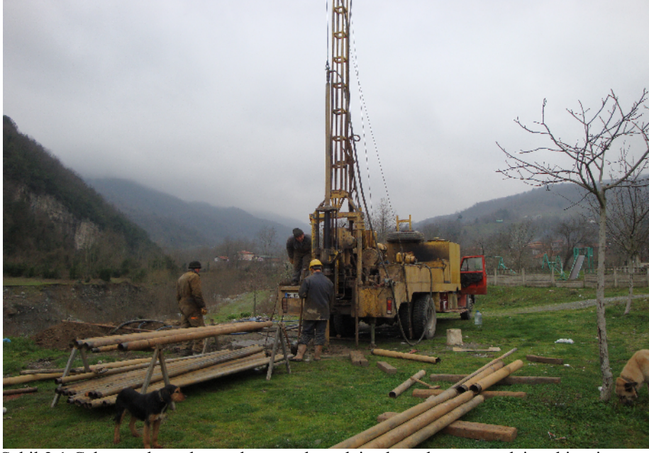
Şekil 2.1 Çalışma alanında yapılan temel sondaj çalışmaları ve sondaj makinesi
