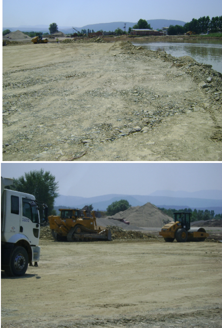
Şekil 6.5 Sakarya Nehri üzerinde bulunan fore kazık noktaları için uygun platformun hazırlanması.
