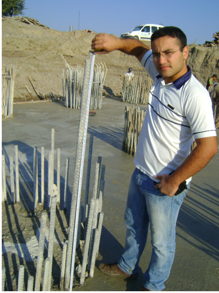
Şekil 8.4 Ya da bazı kazıkların demir filiz boylarının birbirleriyle orantılı olmadığı dolayısıyla demir donatının kuyu içerisinde bozulmaya uğradığı tespit edilmiştir.
