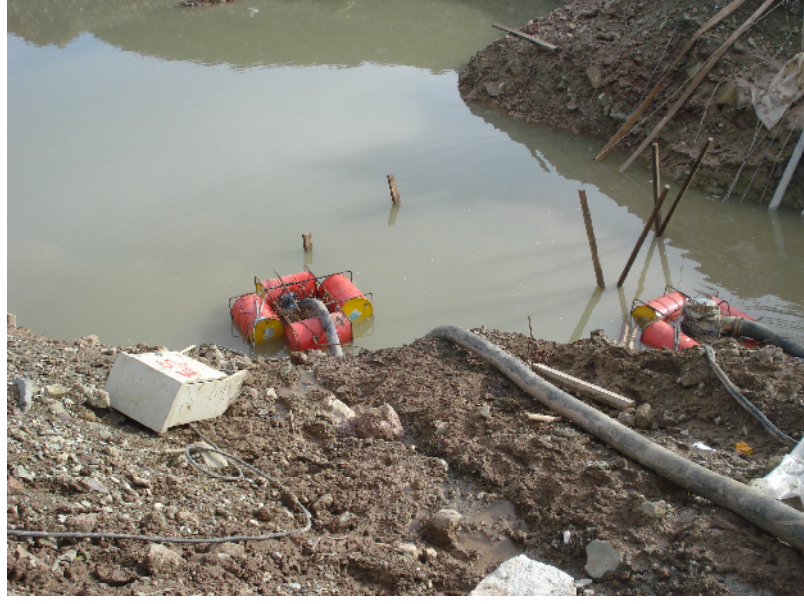
Şekil 8.2 Kazıklar açıldıktan sonra Sakarya nehri ile aynı kotta olan temel kazıklarında gelen mevcut su birkaç noktaya kurulan değişik kapasitelerdeki su pompaları ile Sakarya Nehrine boşaltılır.
