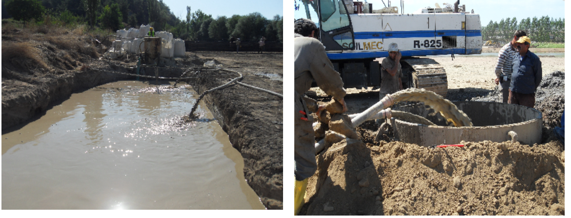
Şekil 6.6 Fore kazık uygulamasında bentonit kullanımı ve bentonit havuzu
