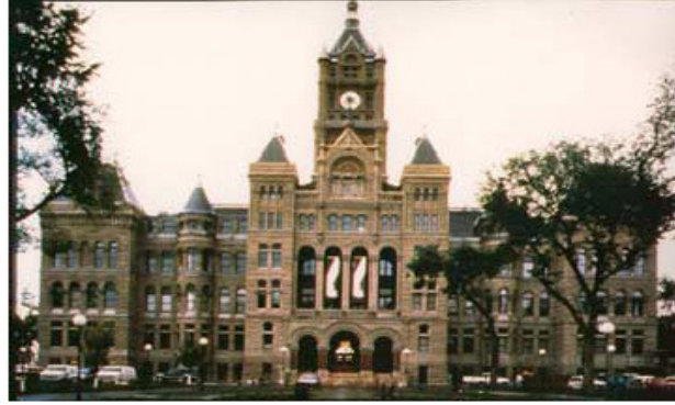
Şekil 4.7 Salt Lake City binası sismik izolatör kullanılarak güçlendirilmiştir. (Bailey and Allen, 1991).
