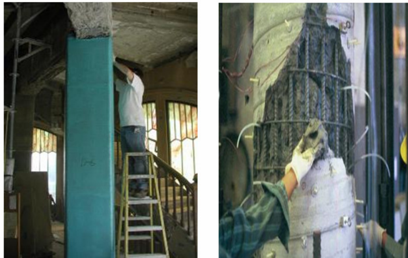
Şekil 4.2 Betonarme manto ile güçlendirilen bir kolon.
