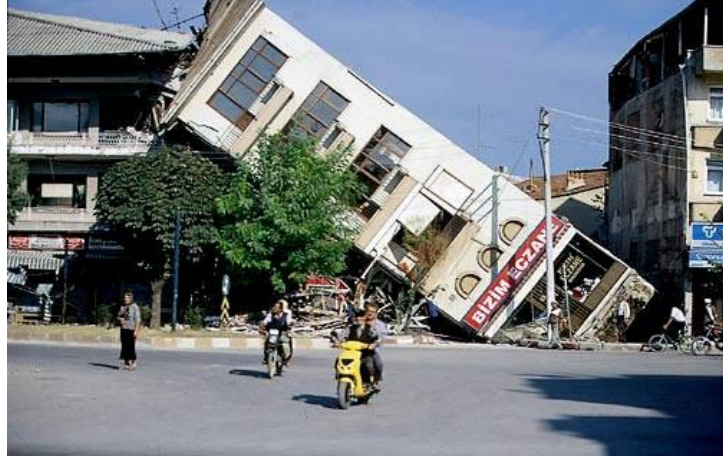
Şekil 1.2 Depremin doğrudan kayıplarına bir örnek: Göçme safhasına gelmiş bir yapı (Şahan, 2009).
