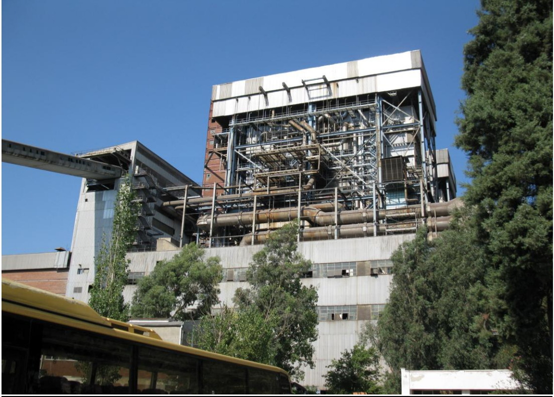
Şekil 1.3 Buhar üretim sistemi buhar kazanının dışardan görünümü (YEAŞ, 2010)
