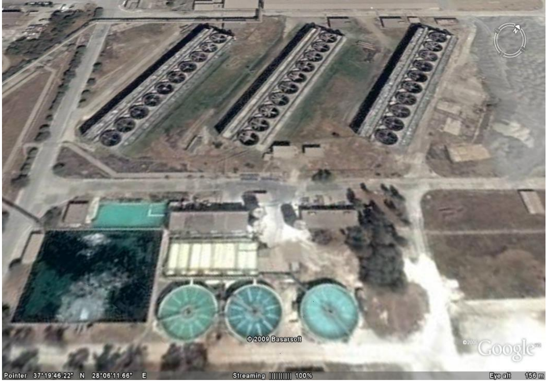
Şekil 1.6 Su soğutma kuleleri ve su ön dinlendirme havuzları (YEAS, 2010)
